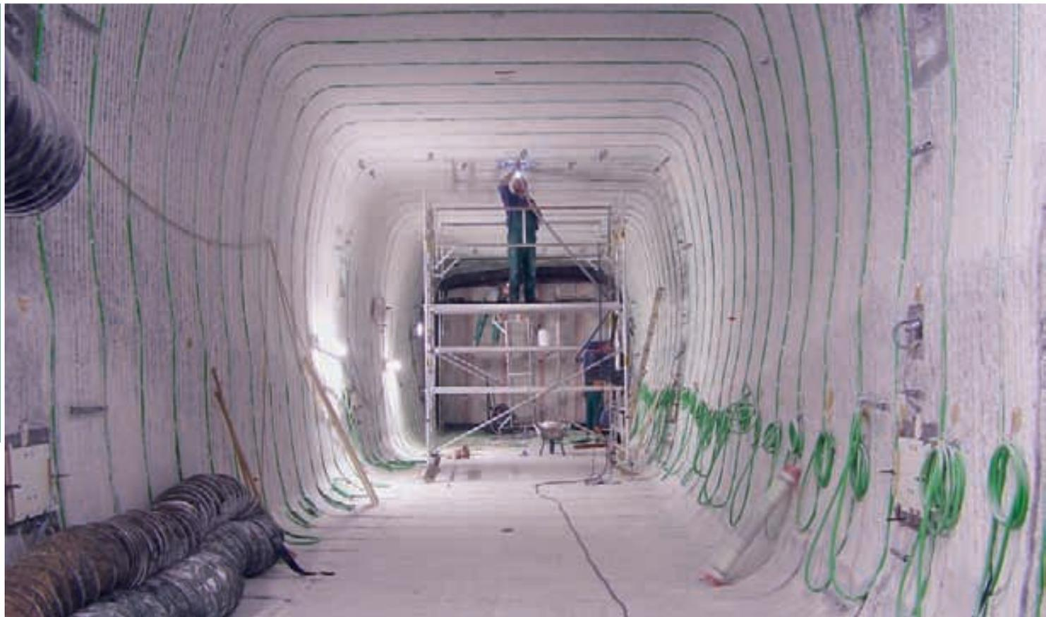
Установка измерительного и инъекционного оборудования
