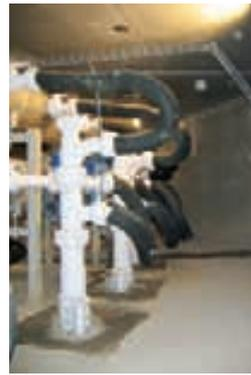
Оголовки труб в рассолопроводной галерее ствола №1
