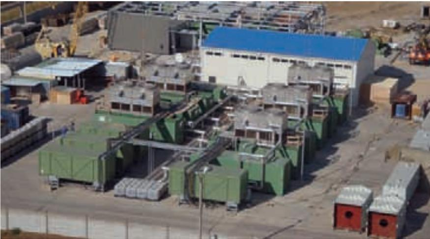
Замораживающая установка для скипового ствола №1
