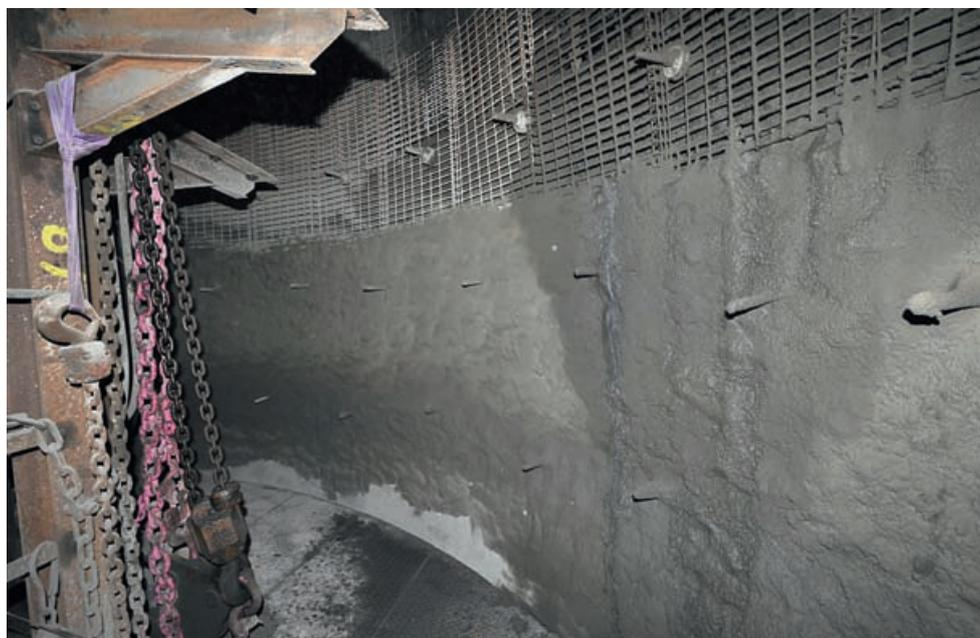
Нанесение набрызгбетона во время первого подъема полка снизу вверх
