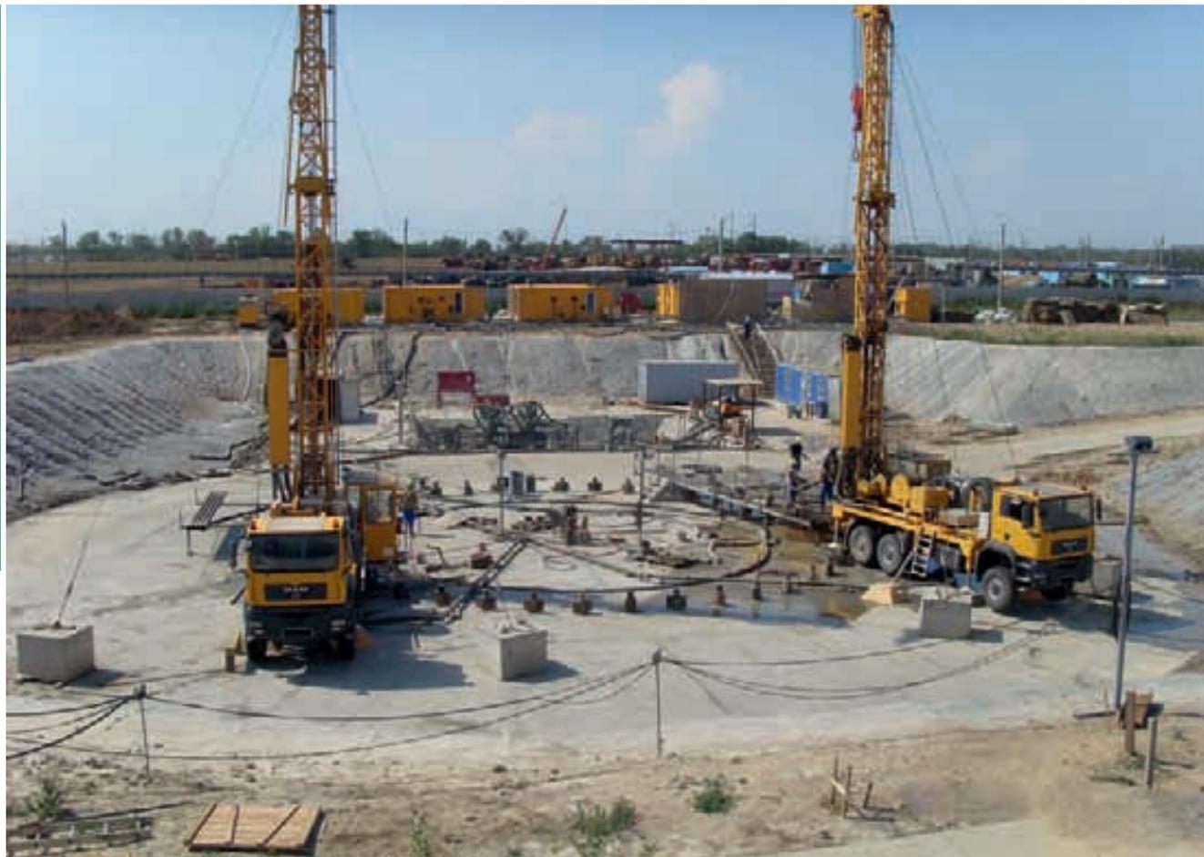
Использование двух буровых установок RB50 при бурении замораживающих скважин
