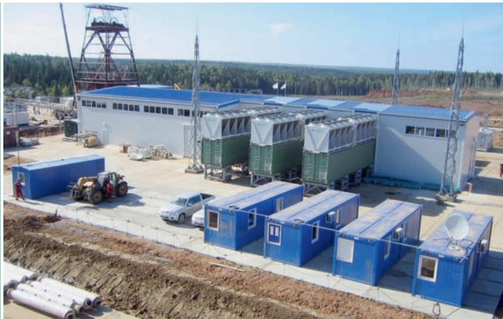
Замораживающая станция и проходческий копер ствола №1
