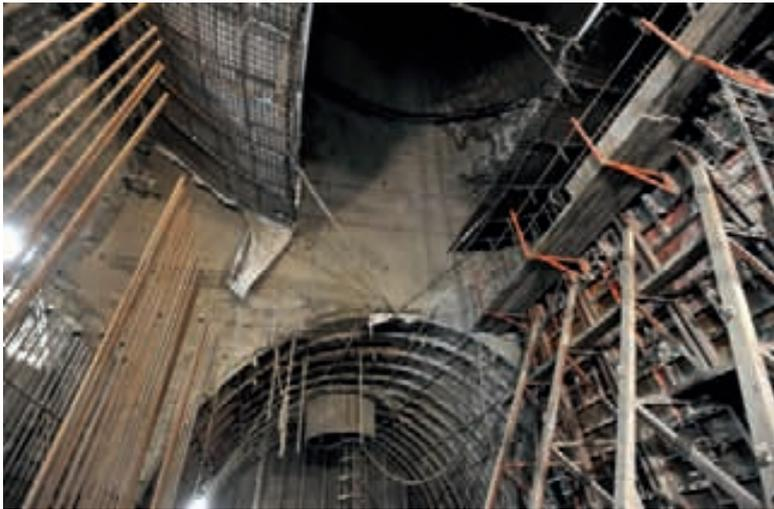
Изготовление стен для установки раструба, перекрытия во избежание загрязнения арматуры
