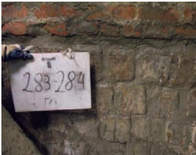
Очищенная каменная крепь шахтного ствола
