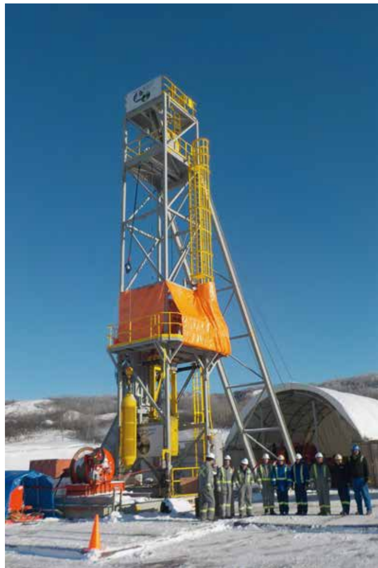
Осмотр буровой площадки после монтажа мобильного проходческого копра и подъемного оборудования
