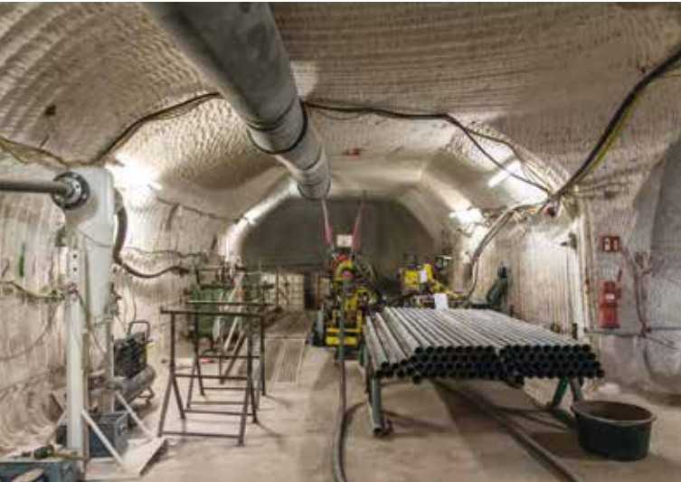
Буровая установка и склад буровых штанг на отм.-574 м
