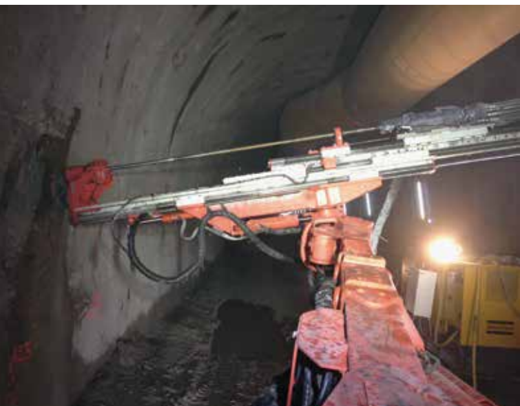
Крепление породного массива анкерами с помощью самоходной установки
