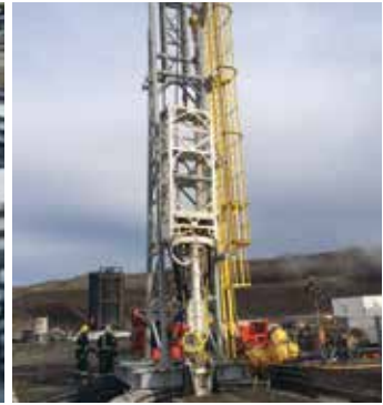
Рама грейфера была использована для проходки технологического отхода
