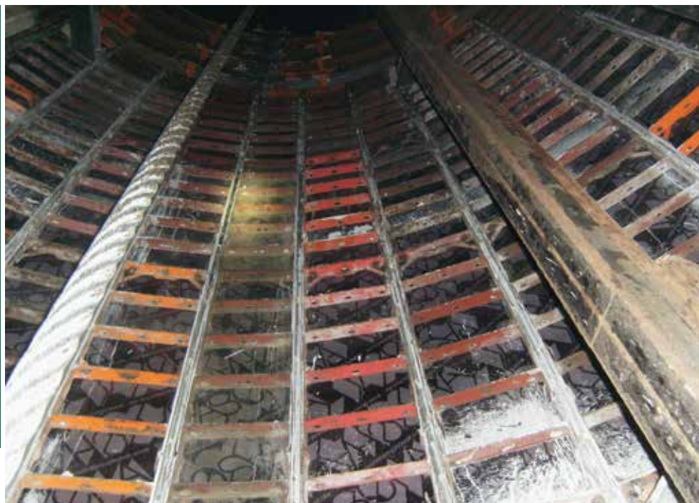
Системная опалубка для устройства бетонной усиливающей колонны
