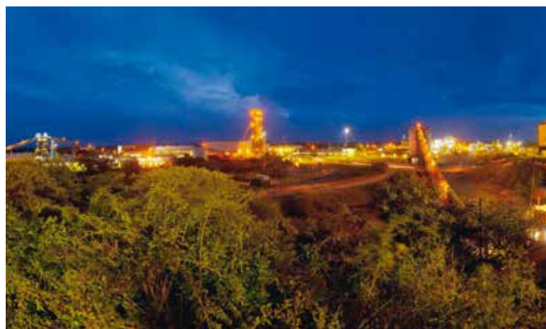
Промышленная площадка при ночном освещении
