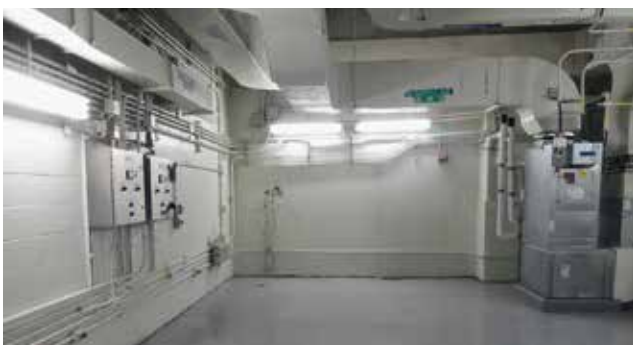
Бетонная отделка после успешно проведенных инъекционных работ
