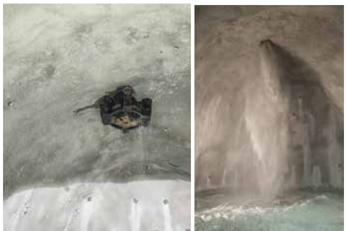
Успешная сбойка пилотной скважины в рекордные сроки
