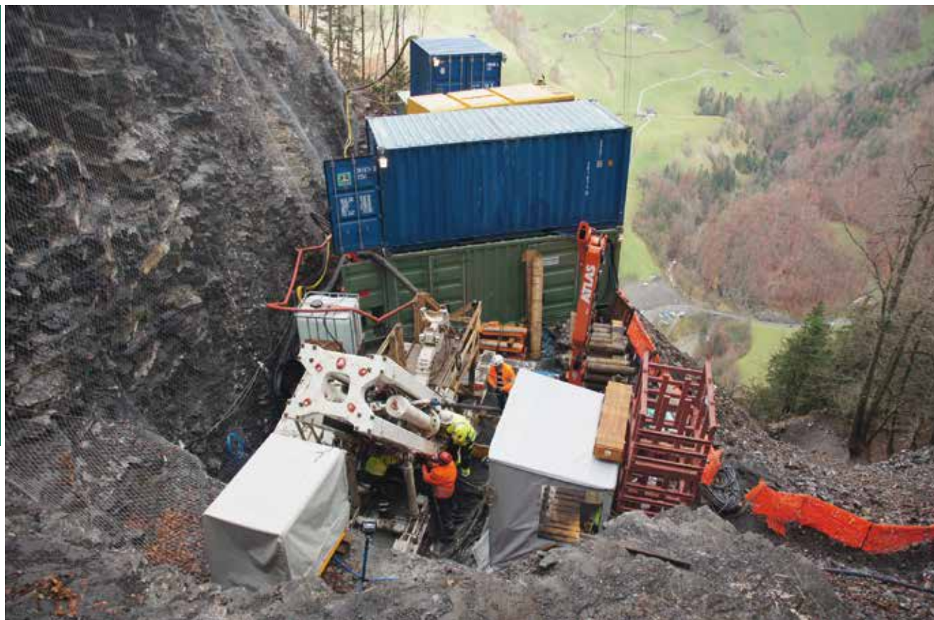
Рабочее место для установки восстающего бурения
