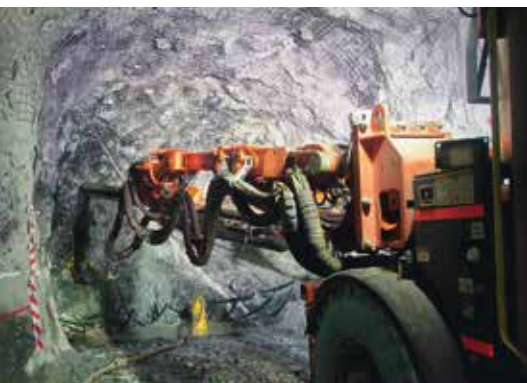
Передвижная установка для ведения буровзрывных работ в действии
