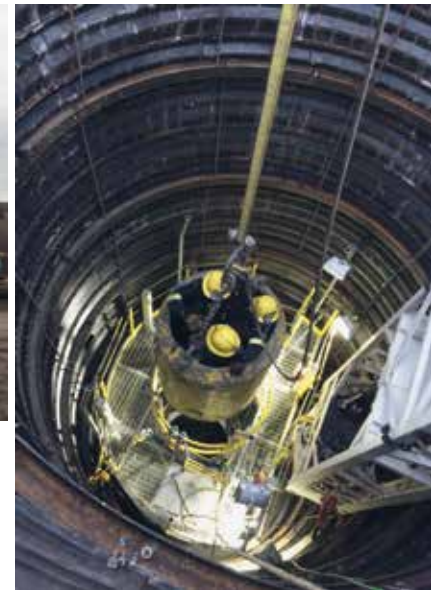
На фото справа проходка ствола
