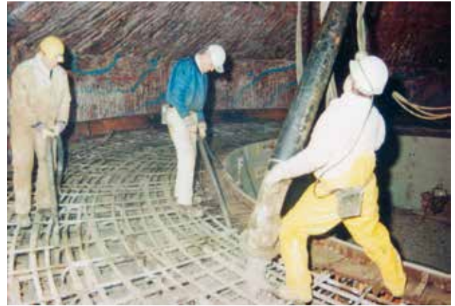
Устройство опорного фундамента для устройства скользящей крепи
