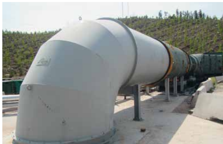
Воздуховод и горизонтальный переходный трубопровод
