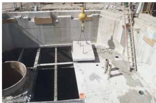
Демонтаж бетонного стального крепления ниже существующего устья ствола
