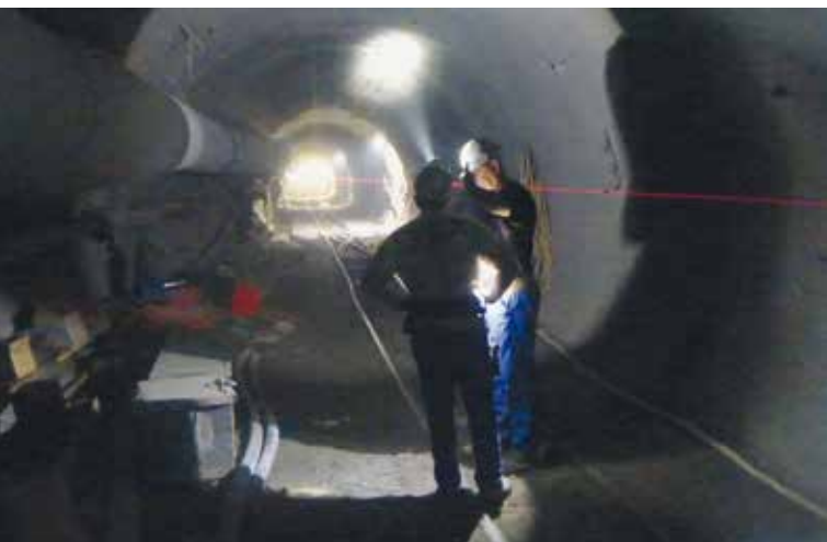
Сбойка с вентиляционным стволом
