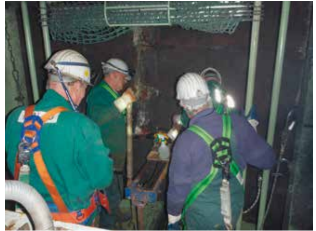
Подготовка отверстия тьюбинга
