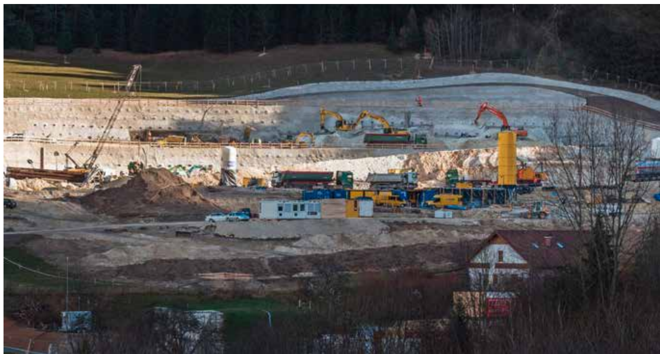
Земляные и специальные подземные работы для подходной выемки Гёстритц
