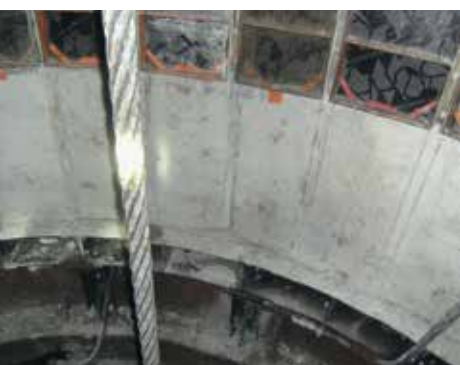
Опорное кольцо и первая бетонная заходка после снятия опалубки
