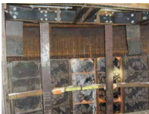
Верхний край системной опалубки и продольная арматура
