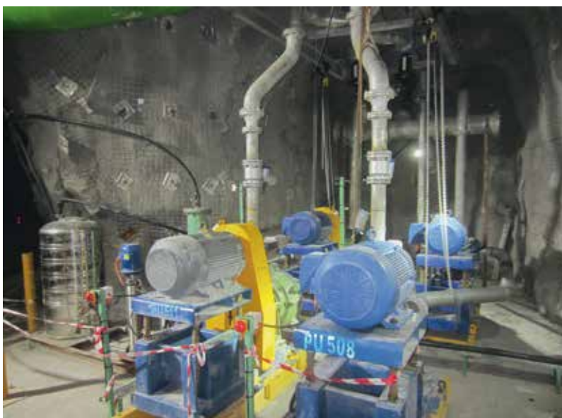
Две ветви по два в ряду 8/6 насоса Warman
