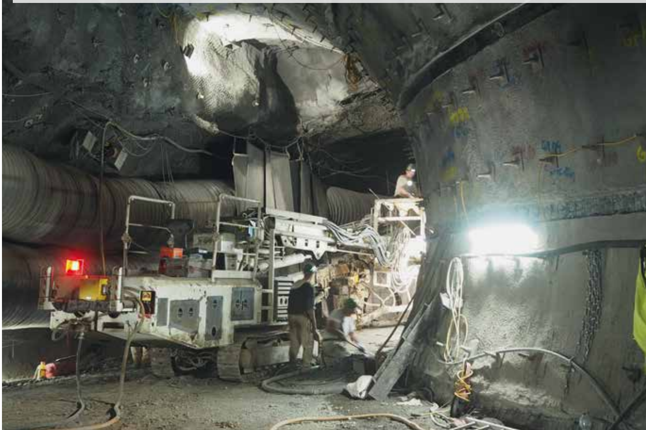
Крепление штрека анкерами и бетоном
