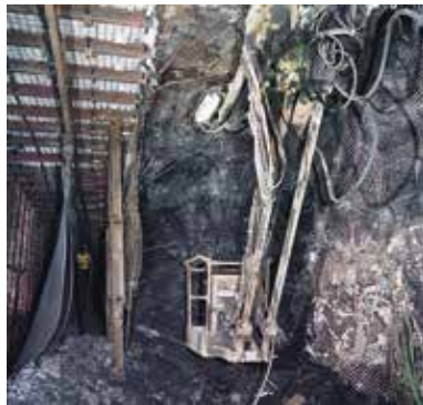
Крепление штрека с защитой от взрывов и с использованием полка для установки анкеров
