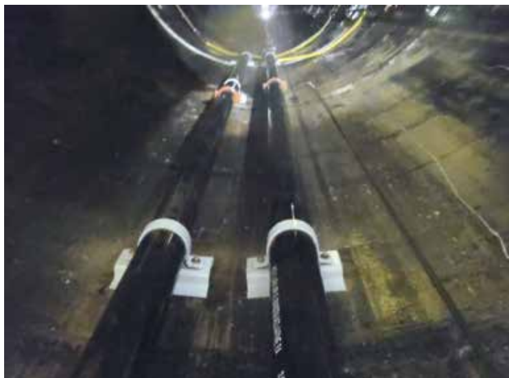
Вид с подвешенного полка на систему водопонижения
