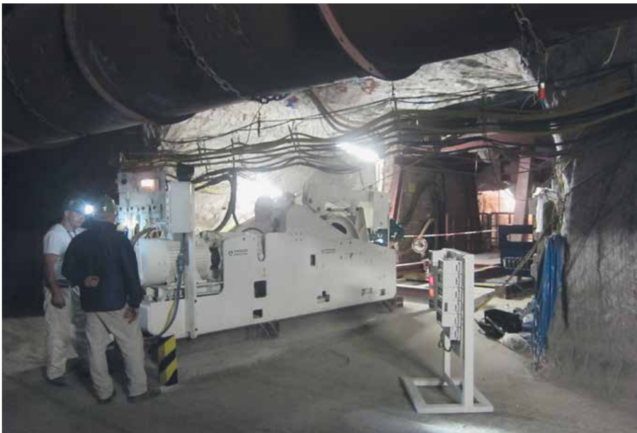
Монтаж лебедок у устья ствола
