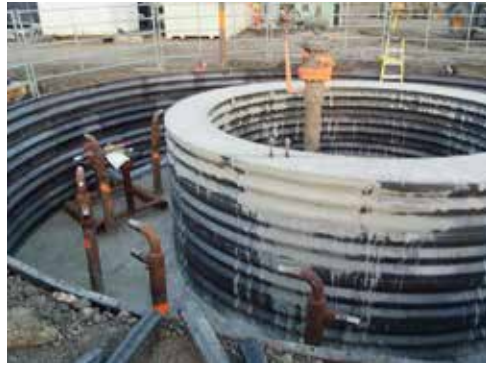
Фундамент оголовка ствола и замораживающая галерея
