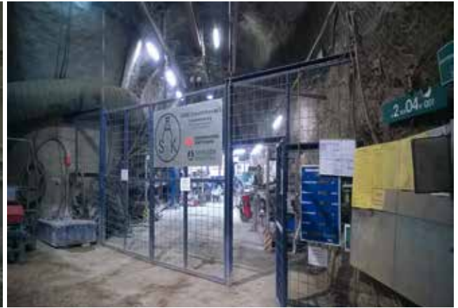
Аудит на строительной площадке, комплекс объектов «Конрад»
