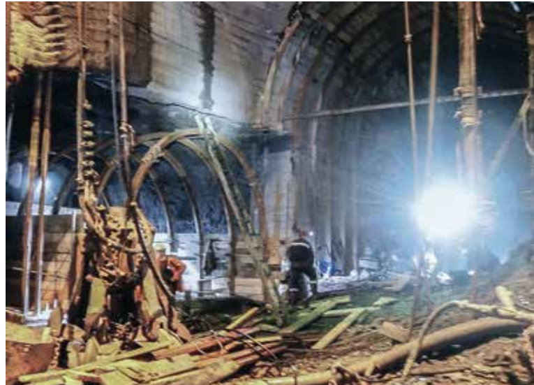
Монтаж бетонной опалубки на участке сопряжения
