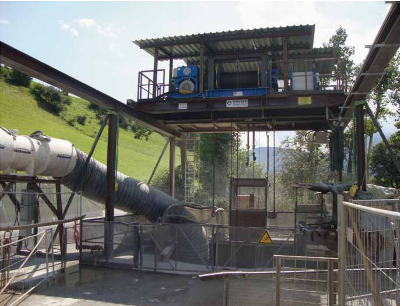
Оголовок ствола с проходческим краном
