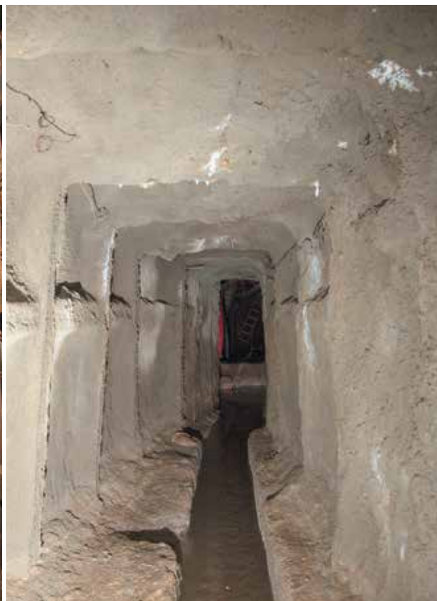
Крепление квершлага стальной крепью и набрызг-бетоном в водоотливной части ствола
