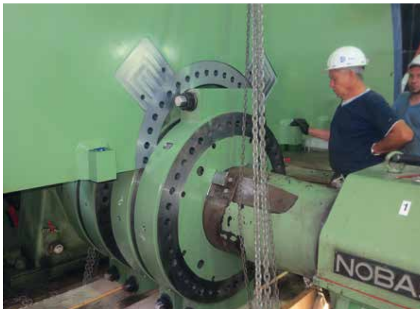
Установка первой половины ведущего шкива на вал
