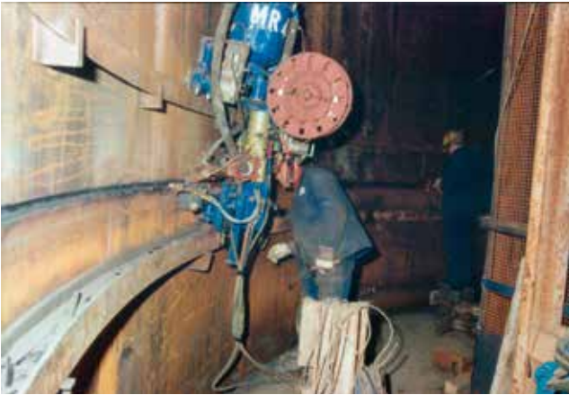
Сварка стального цилиндра при устройстве внутреннего крепления ствола
