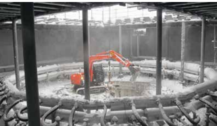
Начало строительства: устройство оголовка ствола до отм. -13,5 м
