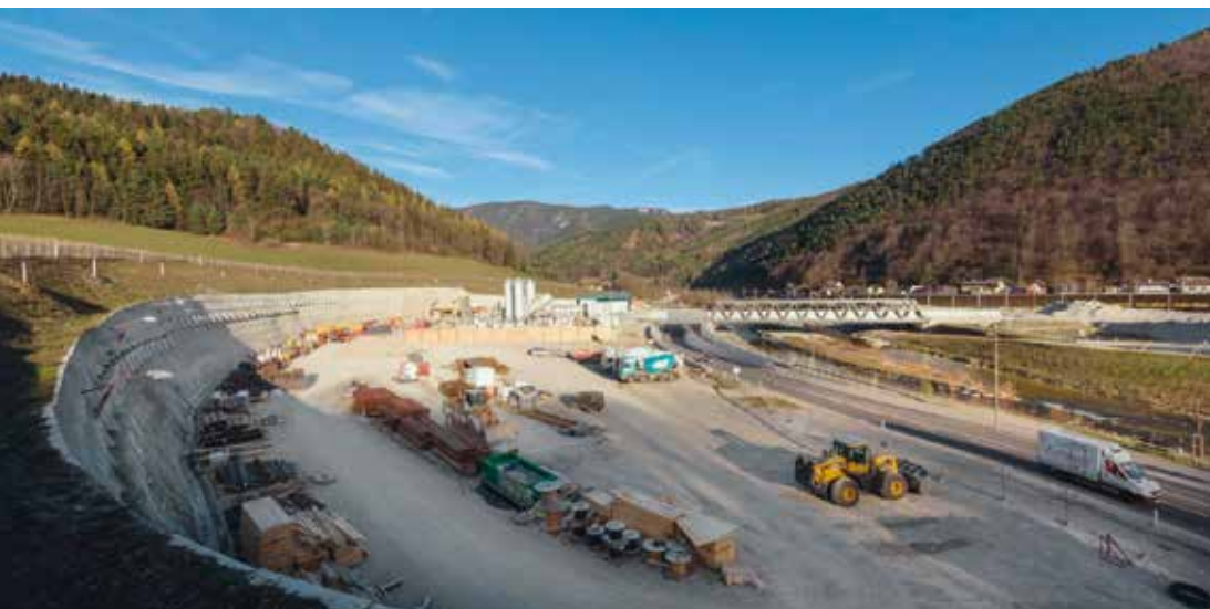
Оборудование строительной площадки в Глогнице
