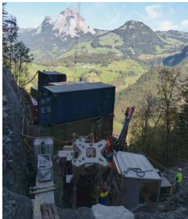
Сложная задача: монтаж установки для восстающего бурения в скальной породе на отм. 900 м
