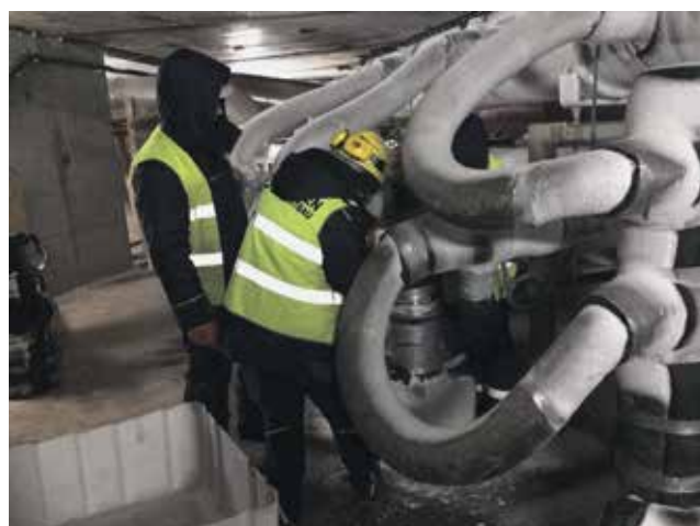
Образовавшийся лед на оголовках замораживающих колонок
