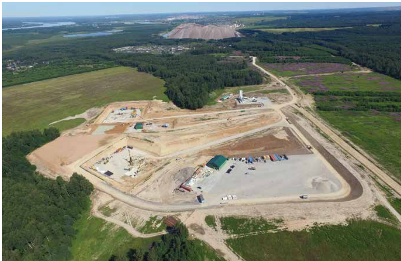
Строительная площадка СКРУ-2. Июль 2016 года. Через 7 месяцев после подписания Договора. На заднем плане соляной отвал рудника СКРУ-2, город Соликамск и река Кама
