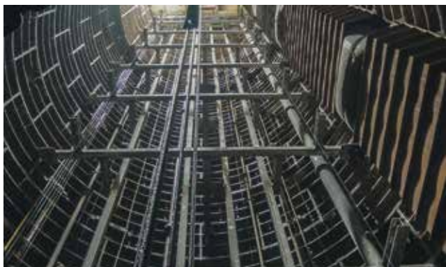
Направляющие и тубинговая крепь в шахтном стволе ВС-10
