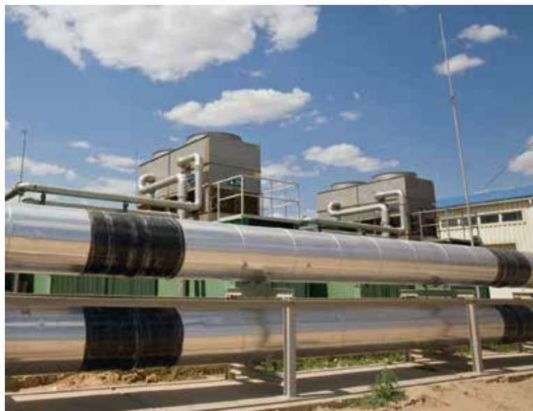
Изолированные коммуникации между морозильными машинами и шахтным стволом
