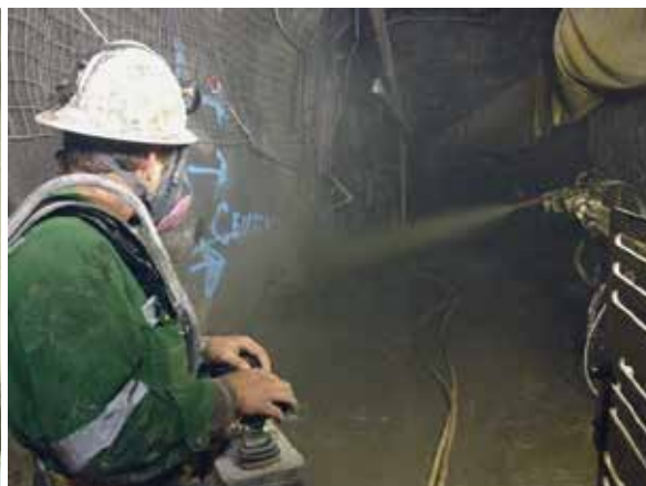
Урановый рудник – нанесение набрызг-бетона
