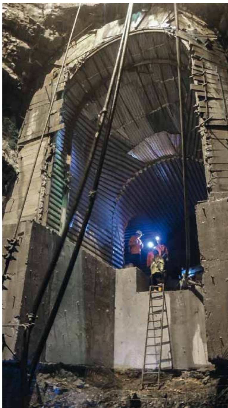
Бетонное крепление насосной камеры
