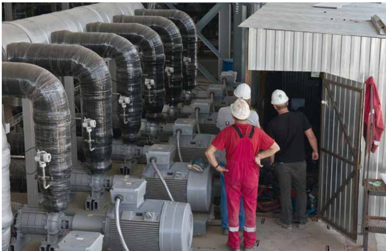
Сотрудники ТШ проводят проверку морозильной установки
