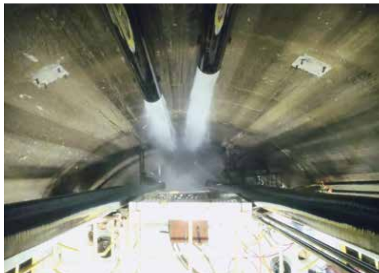
Вид с подвешенного полка на систему водопонижения вблизи от забоя
