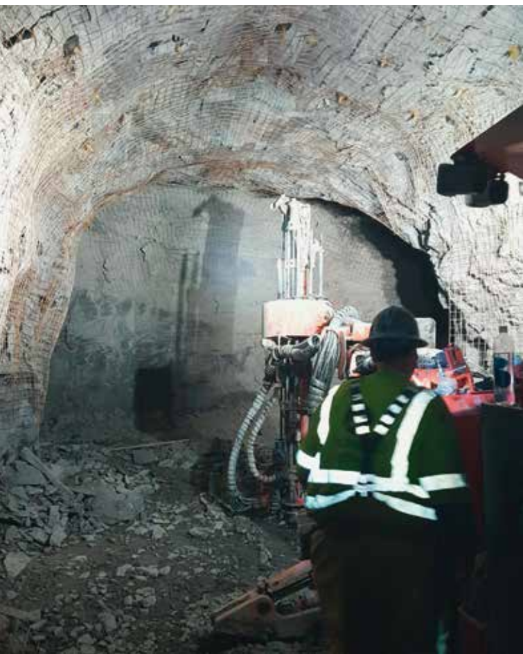
Устройство временного крепления
