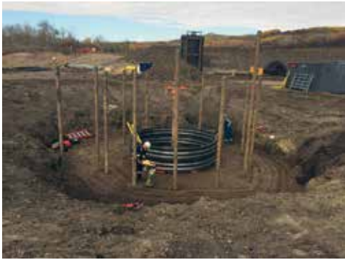
Эксплуатация грунта для устройства устья ствола и сооружение замораживающей галереи
