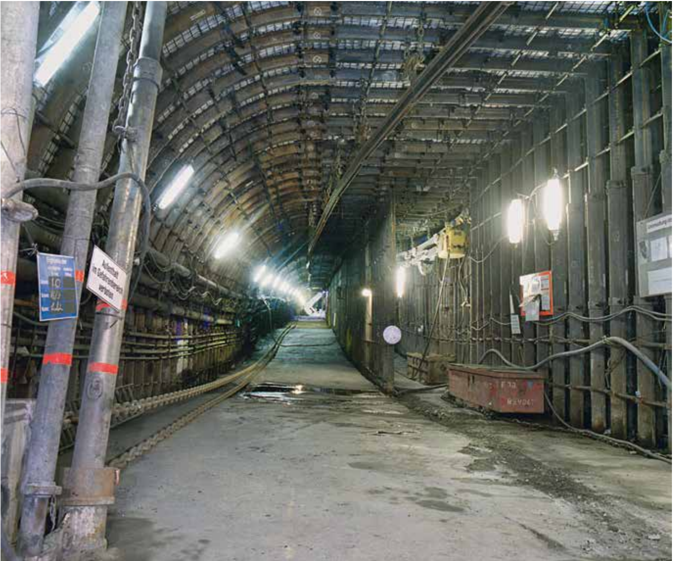
Готовый въезд для устройства щитовой механизированной крепи
