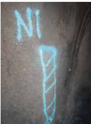
Участок, на котором требуется удаление лишнего материала
