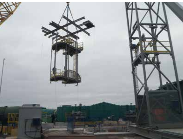
Монтаж стальной конструкции и подвешенного полка у устья ствола 2
