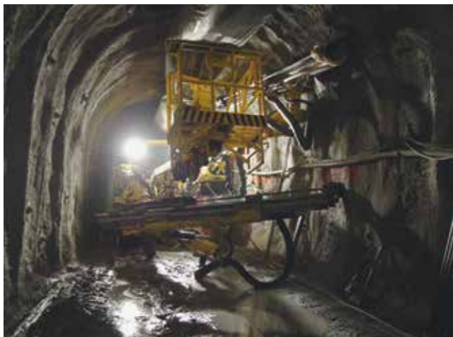
Бурение дренажных скважин установкой Atlas Copco Bohrrjumbo
