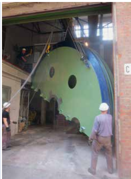
Доставка половины ведущего шкива в надшахтное здание
