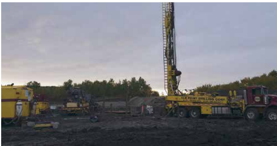
Буровая установка Elk Point Drilling готова к работе
