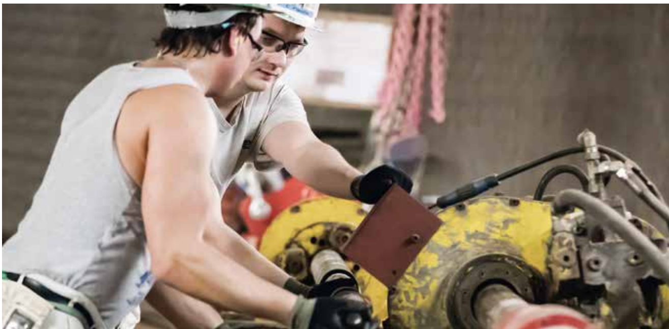
Монтаж внутренней колонковой трубы в буровой став для промывки на глубине
