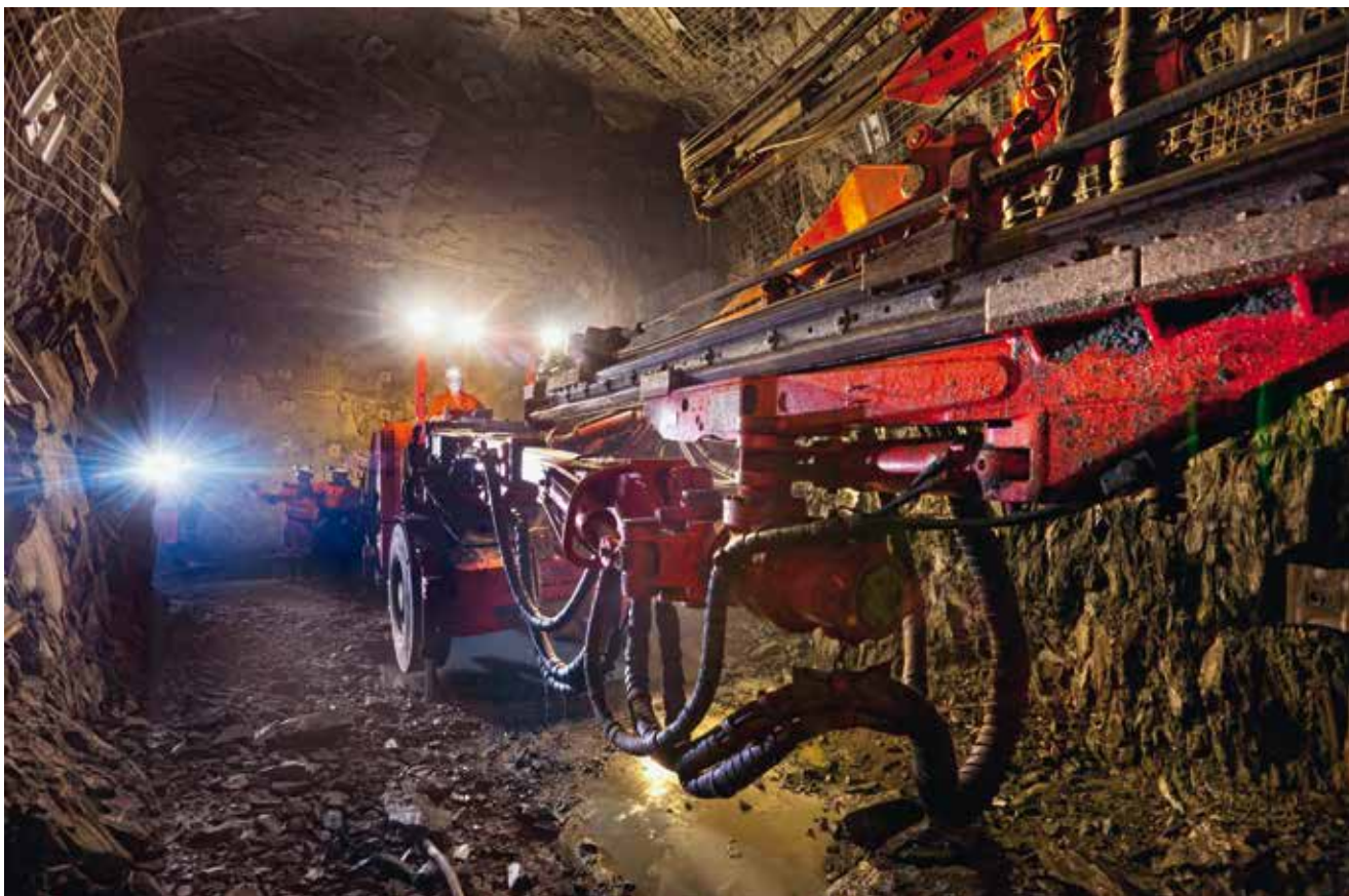
Передвижная установка для ведения буровзрывных работ
