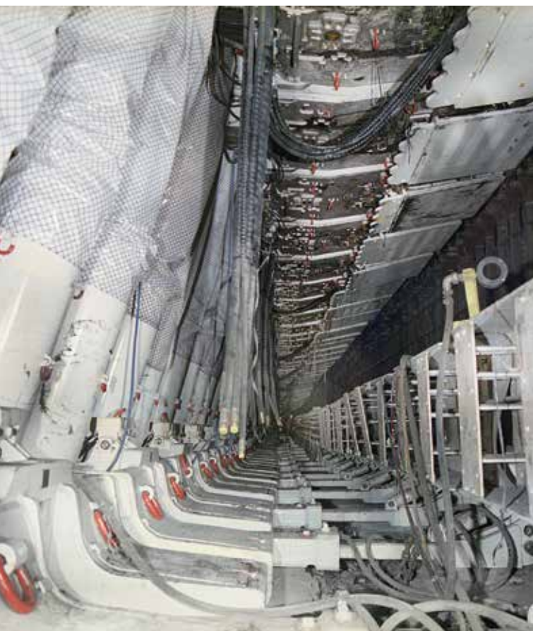
Готовый участок длинного очистного забоя
