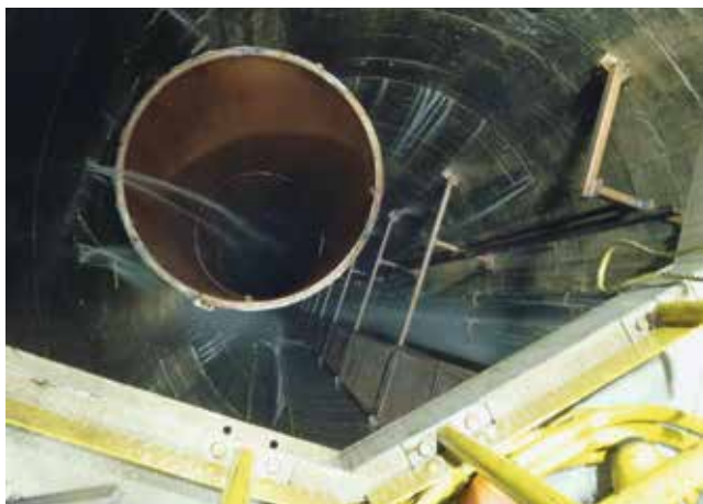
Вид с подвешенного полка на имеющийся водоприток и стальную конструкцию
