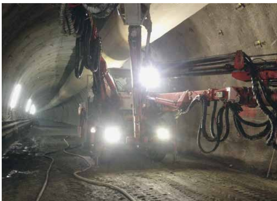
Крепление породного массива анкерами с помощью самоходной установки
