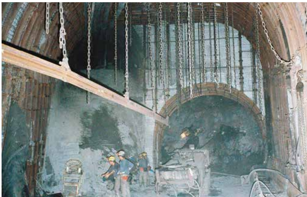
Строительство ответвления горной выработки
