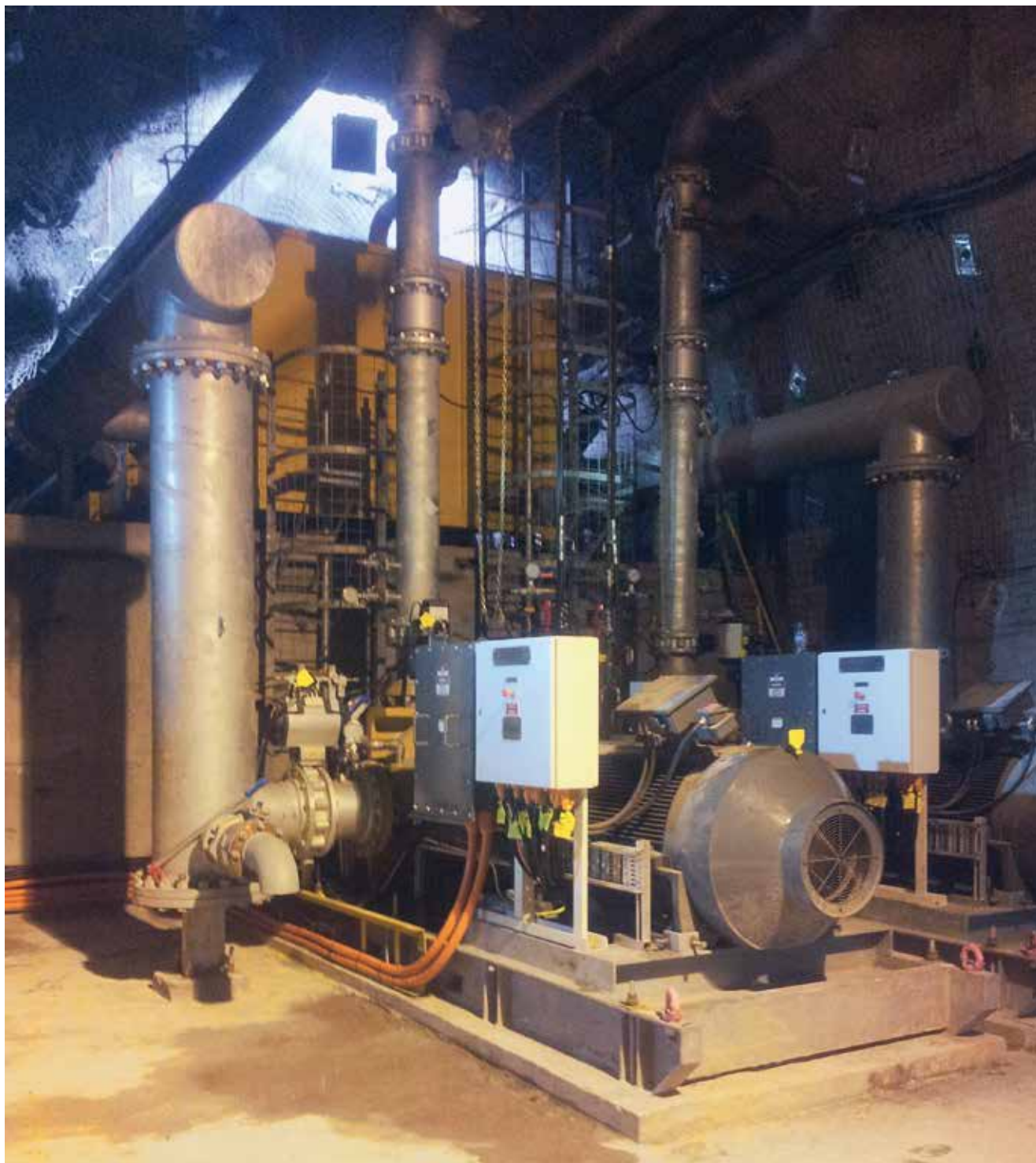
Подземная установка для отвода шахтных вод
