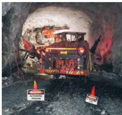
Полуавтоматическая буровая установка под землей
