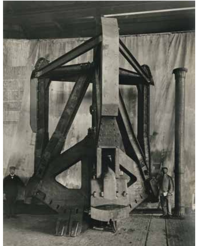
Gewerkschaft Deutscher Kaiser, shaft construction section, Friedrichsfeld system (boring bit) circa 1912
