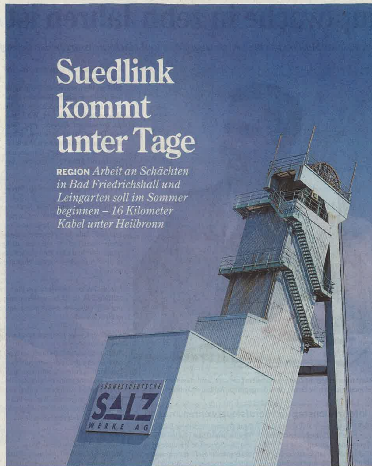
Die Arbeiten der TransnetBW im Rahmen des Energiewende-Großvorhabens Suedlink im Bergwerk der Südwestdeutsche Salzwerke AG laufen bereits. Im Sommer sollen zwei Schächte gebaut werden. Foto: dpa
