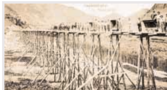
Dammschüttung hinter dem Bahnhof Bad Hofgastein. Die Baugerüste wurden nach erfolgter Schüttung im Damm belassen.
