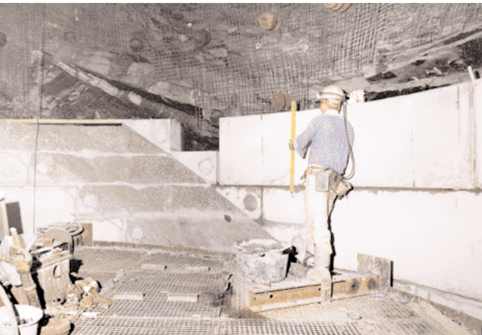
Einbau der vorgefertigten Bunkerausbausegmente
