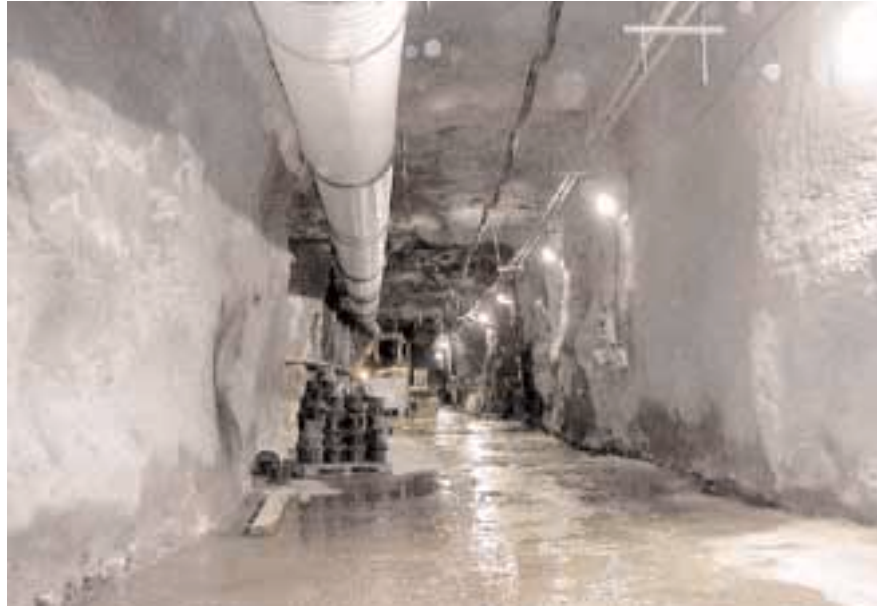
Typische Förderstrecke (vollständiger Spritzbetonausbau und betonierte Streckensohle)
