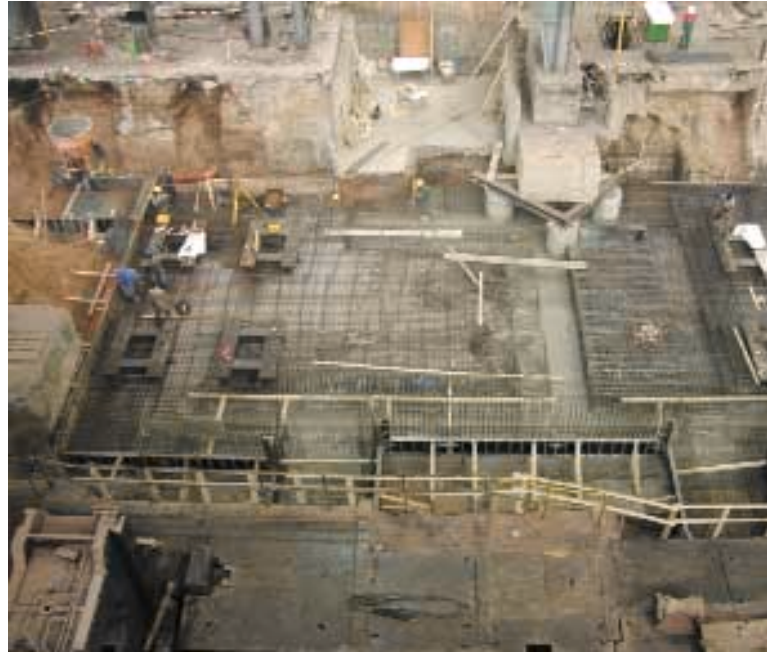
Abfangen der Fundamente und Bewehrung der Sohlplatte
