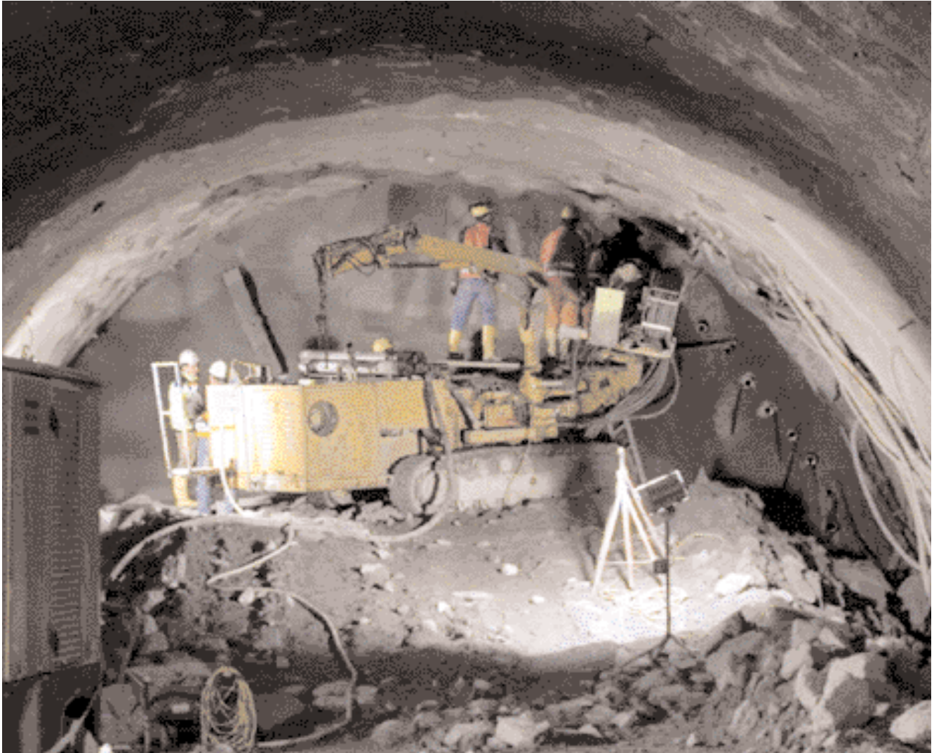
Herstellen eines Manschettenrohrschirmes
