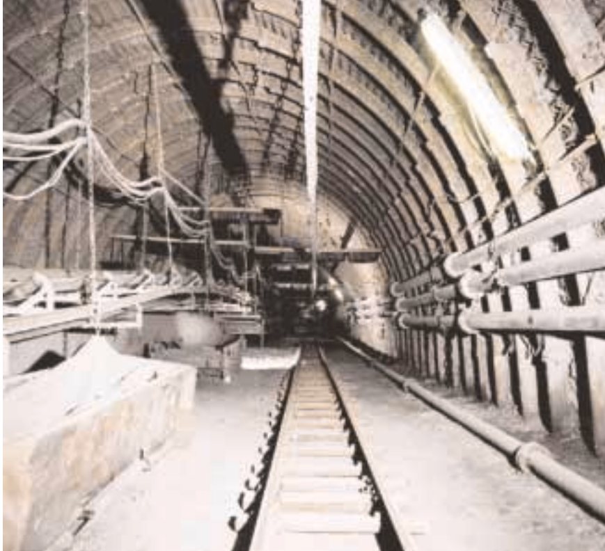
Blick in die fertig gestellte Strecke
