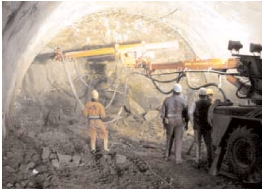
Versiegeln der Ortsbrust
