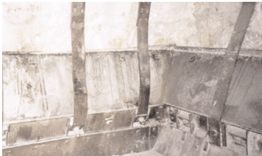
Bunker 2, saniertes Bunkerauslauftrichter
