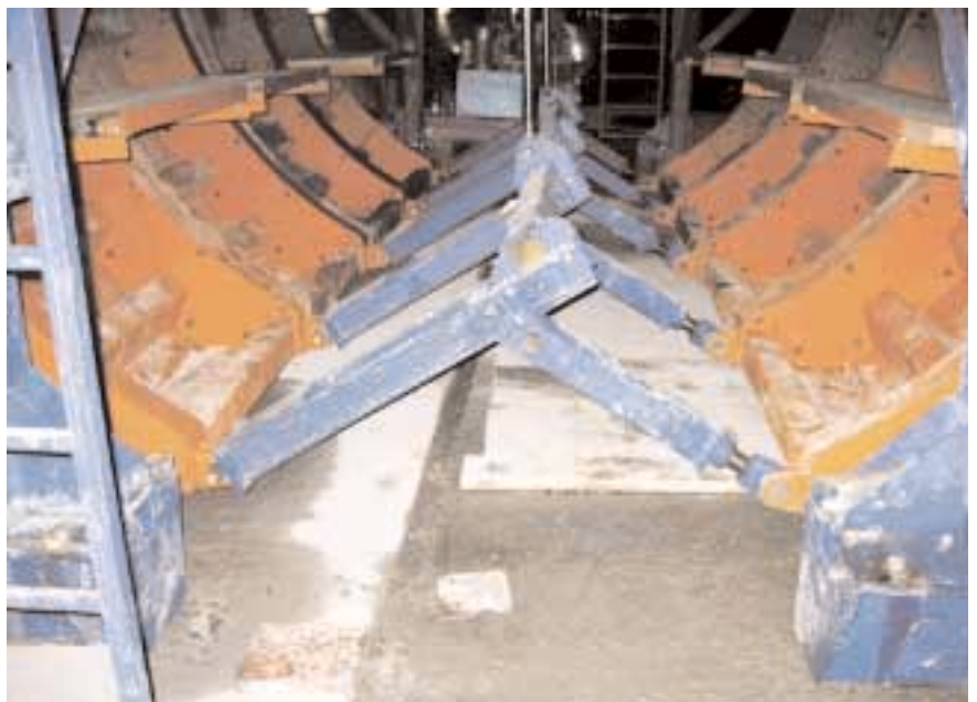
Ausschallvorgang – Gleichzeitiges hydraulisches Anheben aller Drucksprisse
