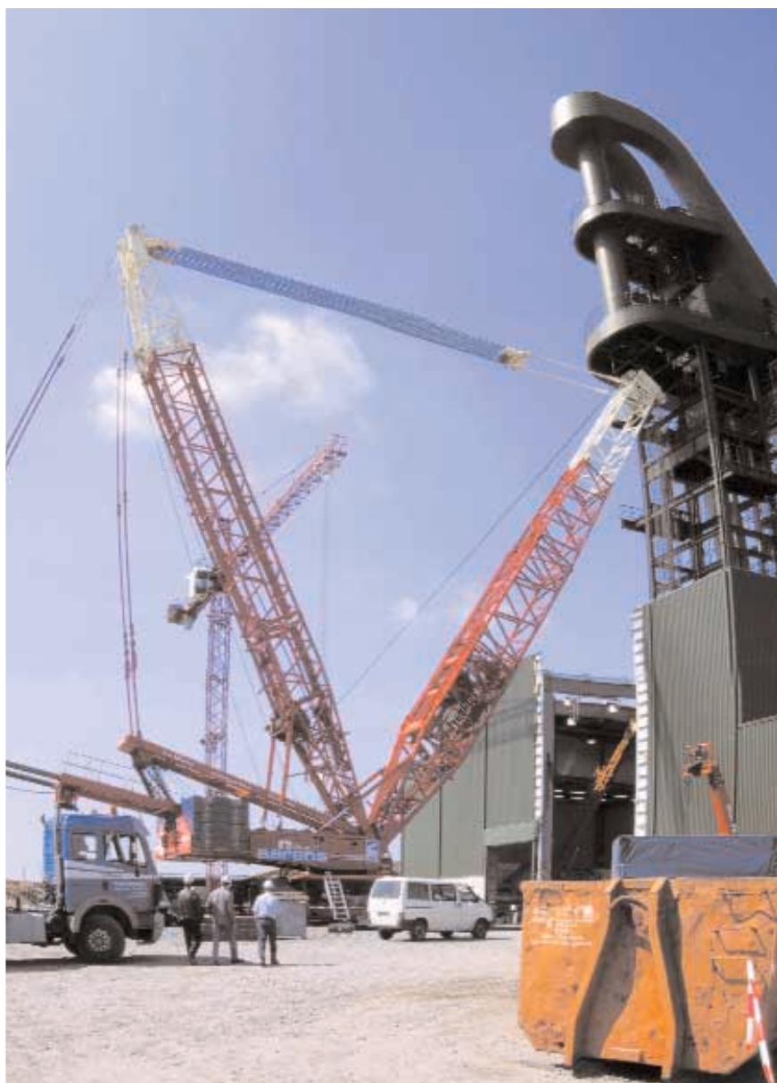
1200 t- Kran im Einsatz
