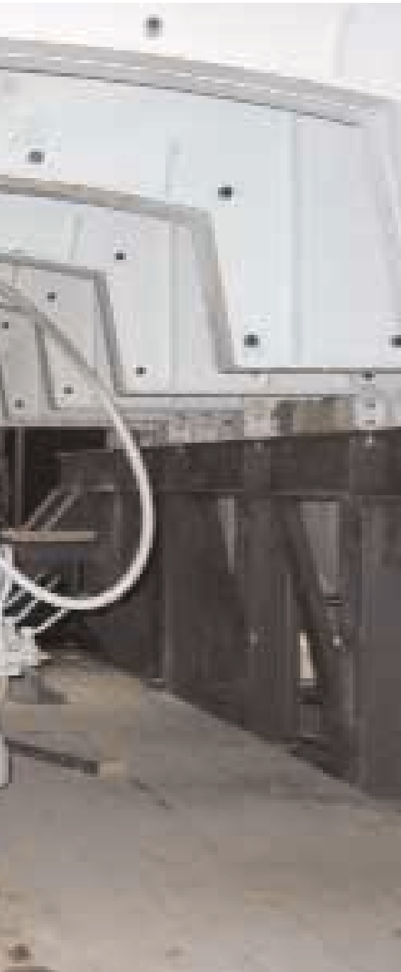
Schalwagen mit vorgelagertem Bewehrungswagen im Montagevoreinschnitt
