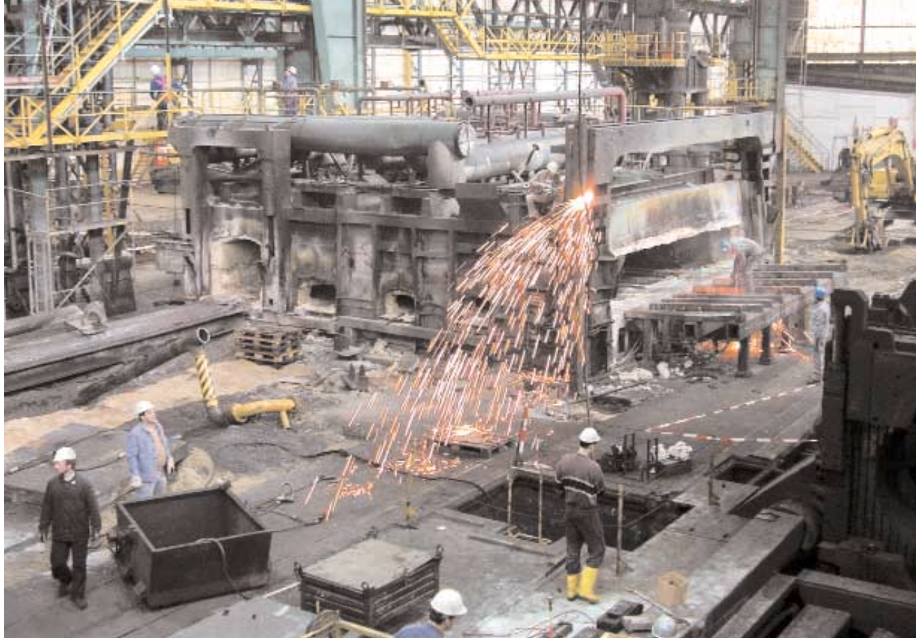
Demontage alter Rollöfen
