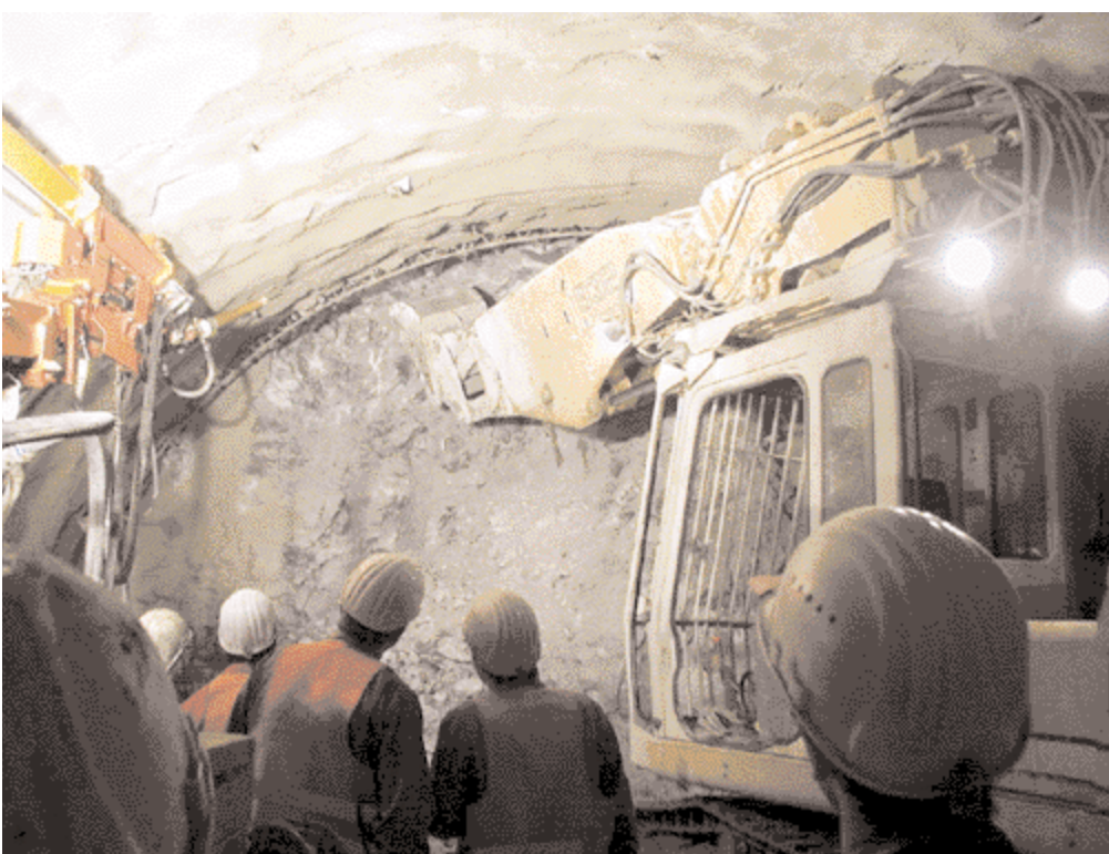
Tunnelbagger und Spritzbetonmanipulator an der Ortsbrust
