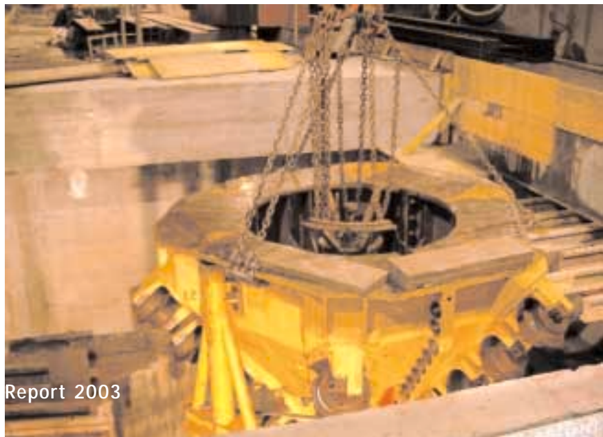
Einhängen der Schachtbohrmaschine, Bohrkopf
