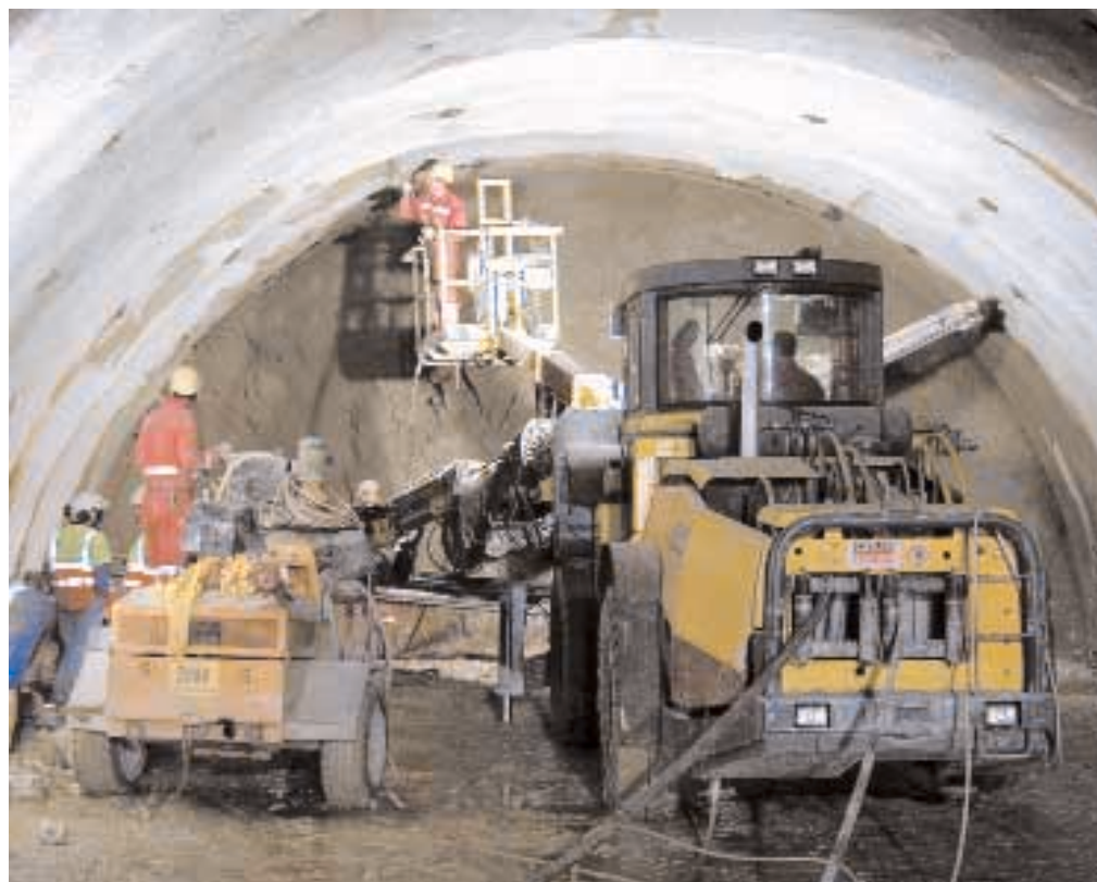
Ankerungsarbeiten in der Kalotte des Birgtunnels
