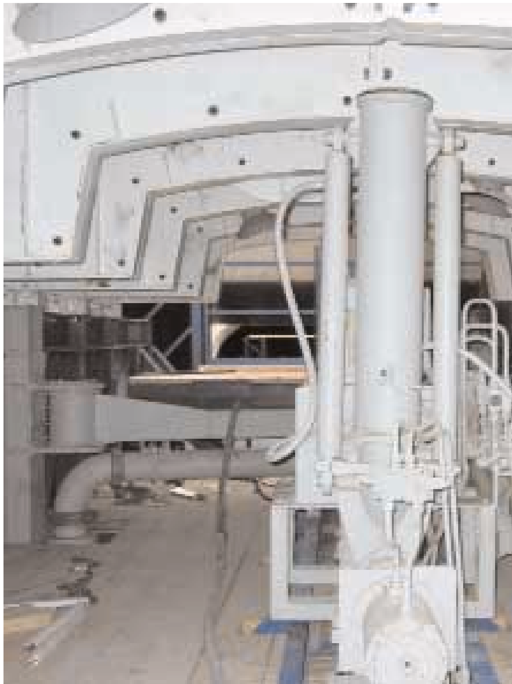
Untersicht Firststoß mit verschiebbaren Auflagerkonsolen und hydraulischem Tunnelbetoniergerät
