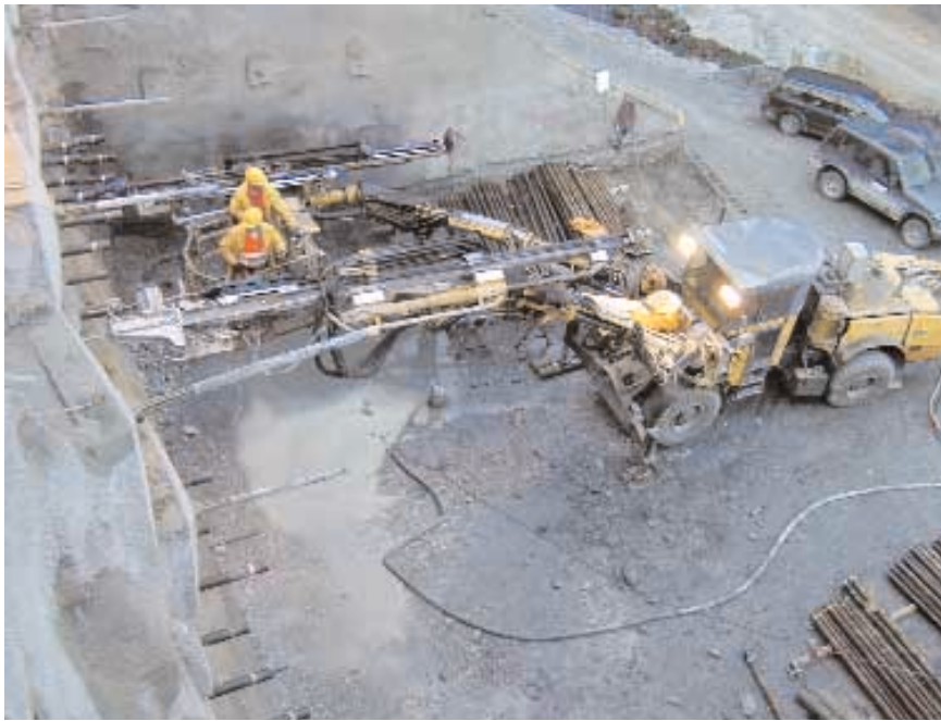
Herstellung des ersten Rohrschirmes am Westportal des Birgtunnels
