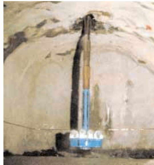
Raisebohrkopf vor dem Anschneiden
