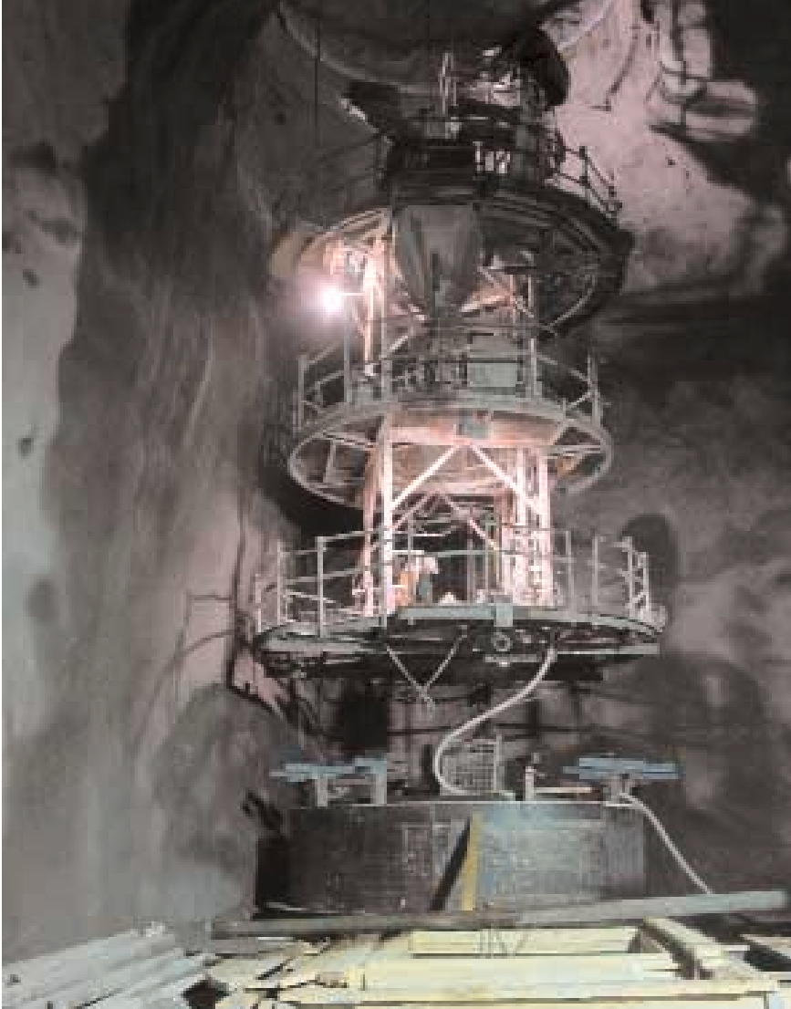
Einbau der Gleitbühne mit Schachtbühne
