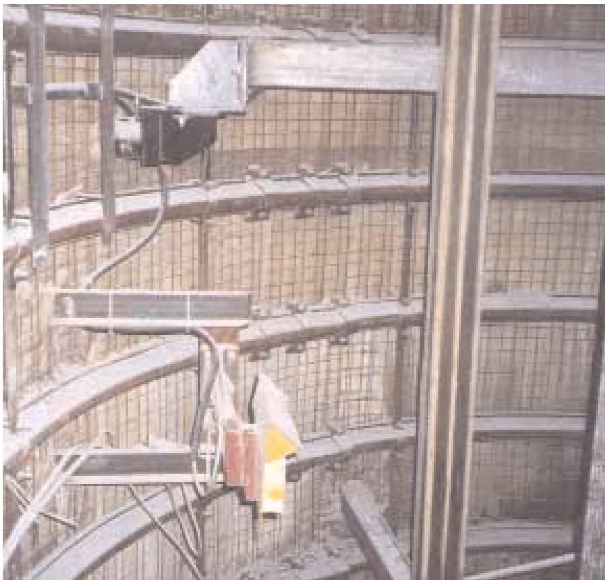
Stahlringausbau Schacht Borth II
