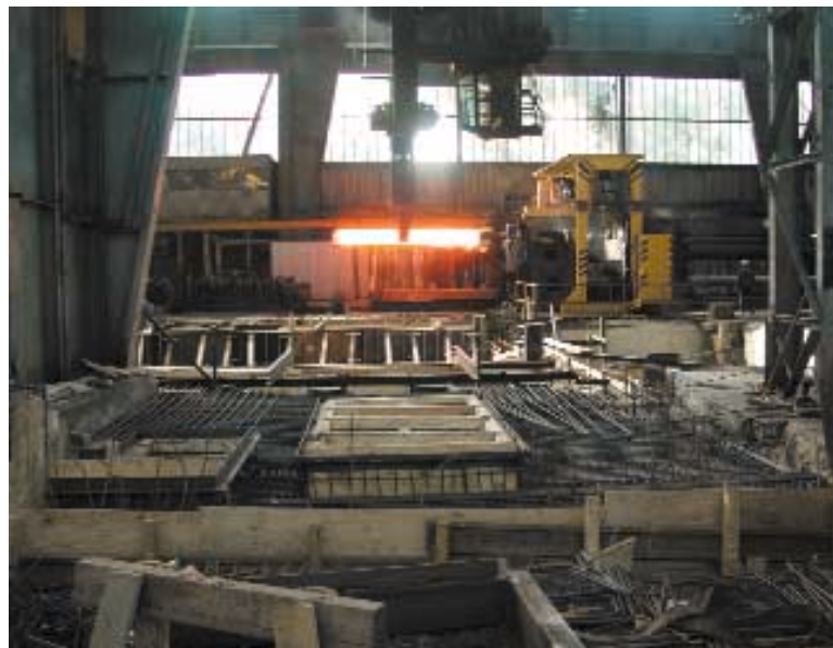
Beengte Arbeitsverhältnisse bei laufender Produktion
