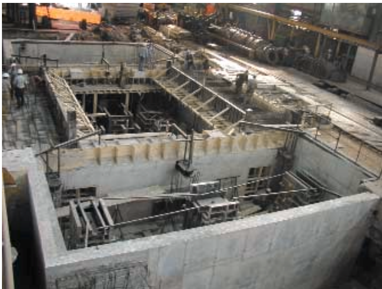
Aufwändige Schalungssysteme bei der Erstellung von Konsolen und überhängenden Wänden
