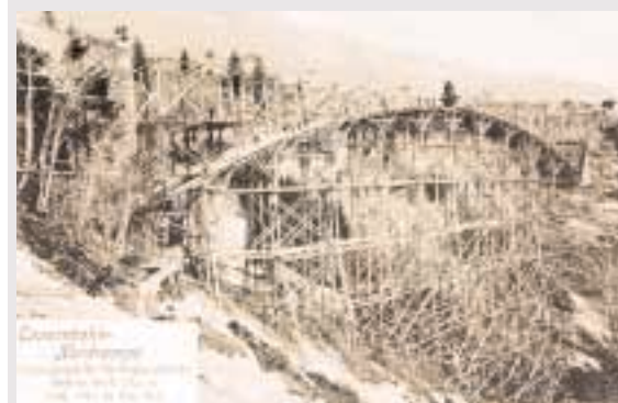
Gerüst der Brücke über die Angerschluft
