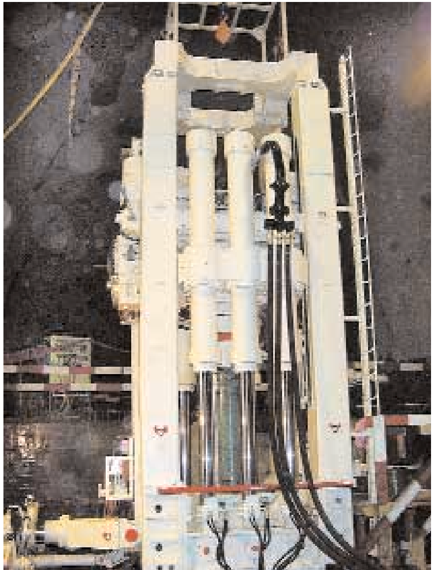
Wirth Raisebohranlage im Einsatz für die Vorbohrung
