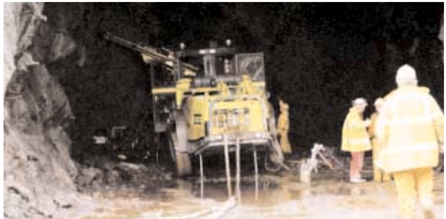
Tunnelportal mit Maschine von Atlas Copco
