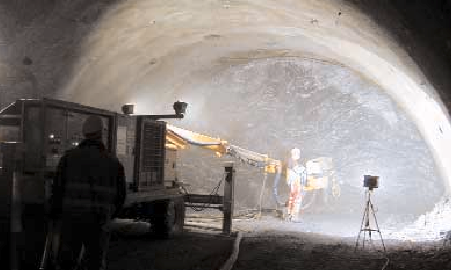
Spritzbetoneinbau in der Kalotte des Birgltunnels
