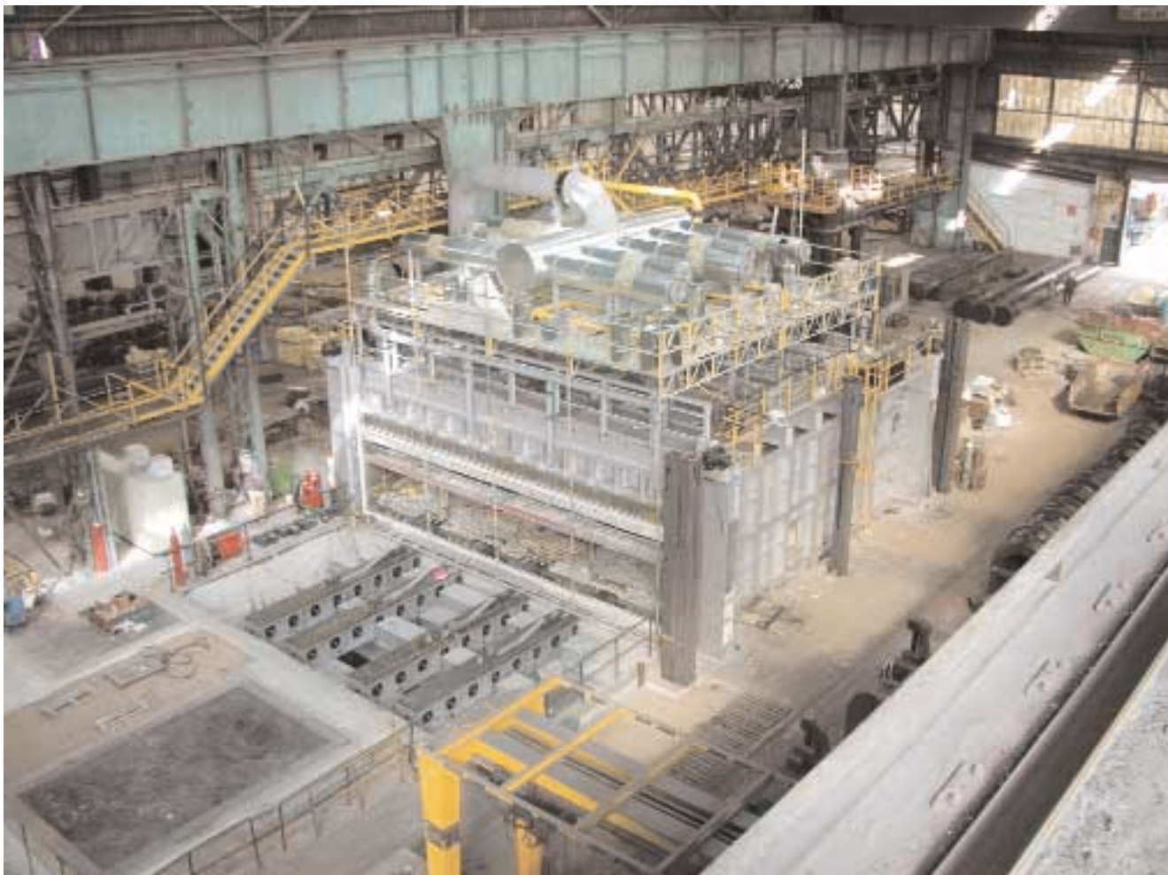
Fertig gestellter Hubherdofen mit integriertem Abwurfplatz (links unten)
