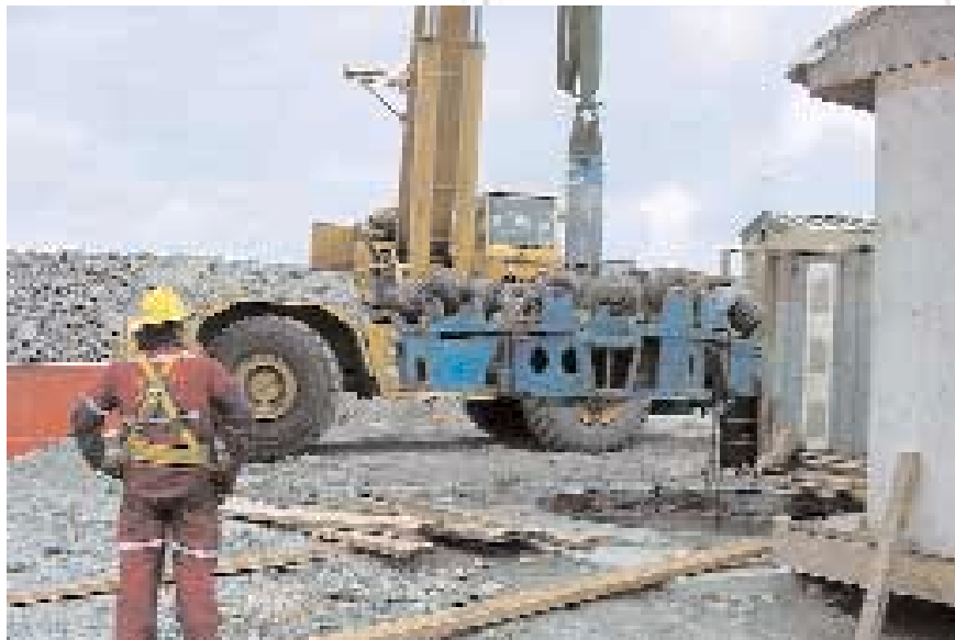
Ausbau des Sandvik-Erweiterungsbohrkopfs (Durchmesser 3,0 m) nach Fertigstellung des Wetterbohrlochs
