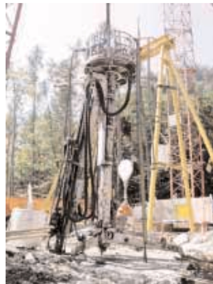
Schachtturm und Bohrgerät
