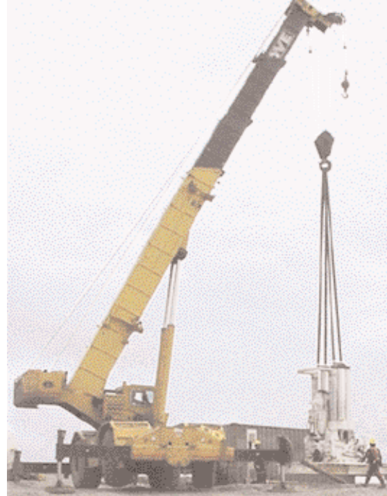
Raisebohranlage RBM7SPLH am Diamantenbergwerk EKATI (August 2002)
