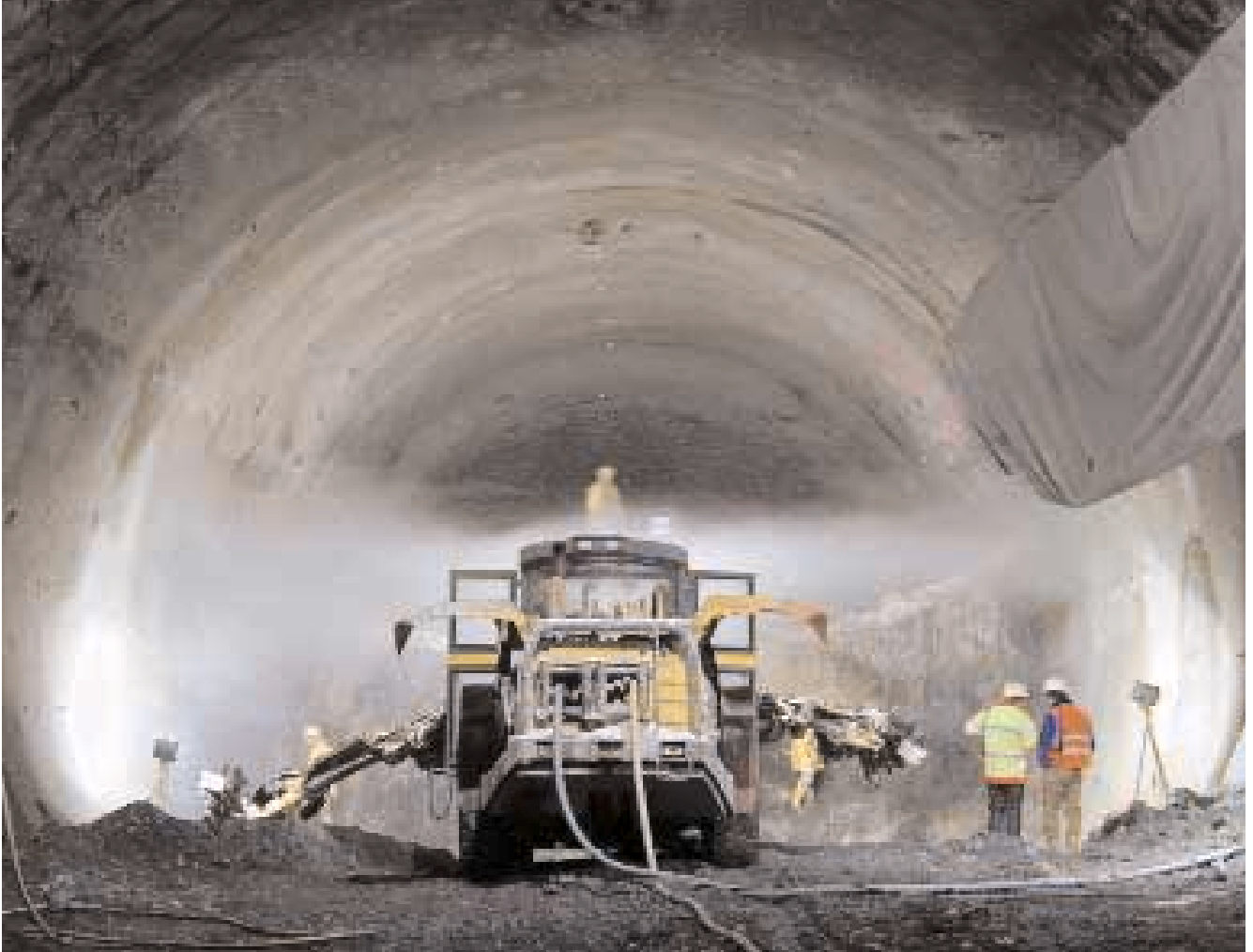
Strossenvortrieb im Birgtunnel
