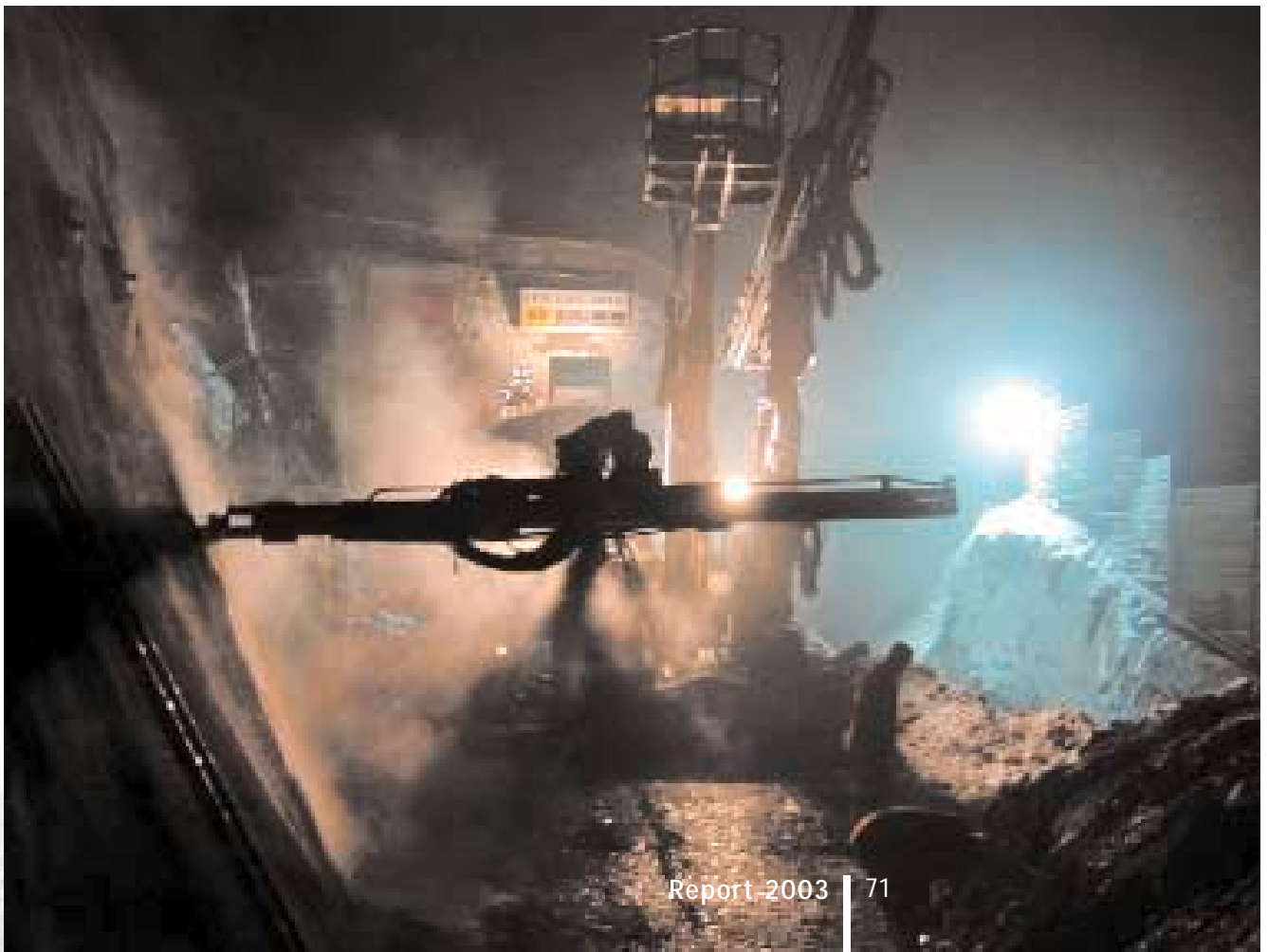
Ankerungsarbeiten beim Voreinschnitt am Kenlachtunnel, Ostportal
