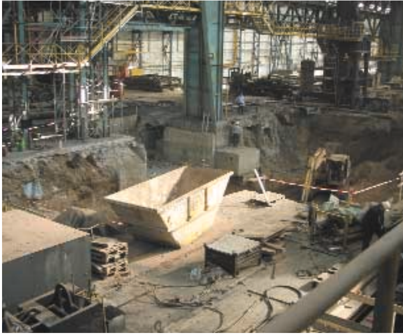
Beengte Verhältnisse bei den Aushubarbeiten
