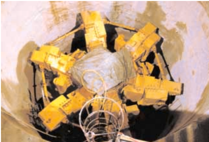
Bohrkopf im Vorschacht
