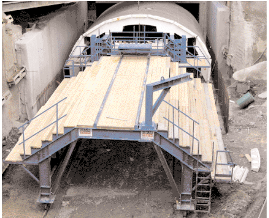
Schalwagen mit vorgelagertem Bewehrungswagen im Montagevoreinschnitt
