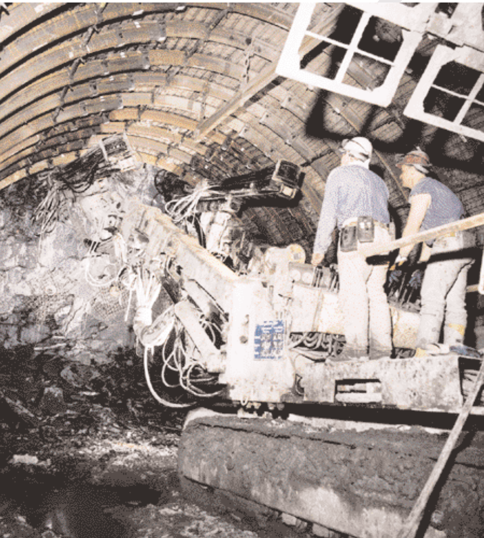
Zweiarmiger Bohrwagen im Einsatz
