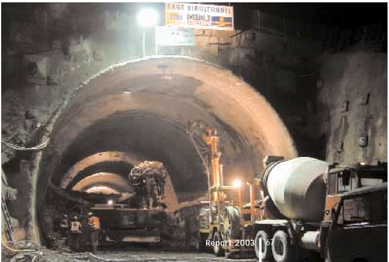
Strossenvortrieb im Westportalbereich des Birgltunnels
