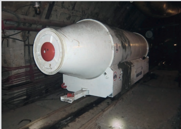
Первая установка для домешивания бетона под землей 15го августа 2013 года
