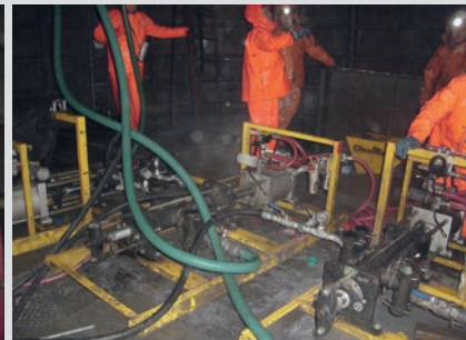
Тампонажная арматура для химического гидроизоляционного материала „NOH2O“
