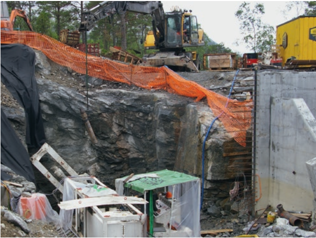
Подъем установки расширительного бурения
