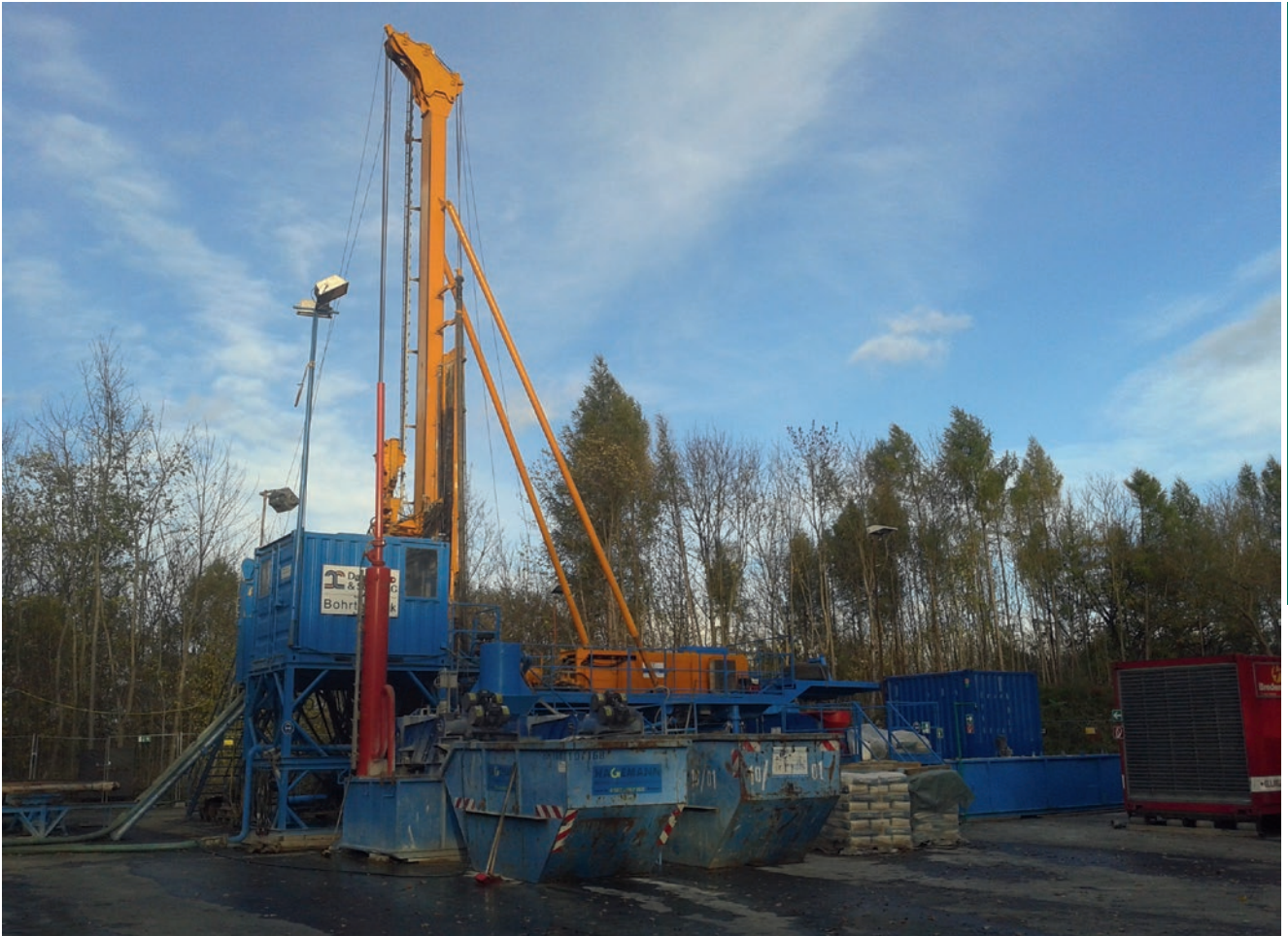
Буровая площадка «Ремлинген 15» компании Asse GmbH
