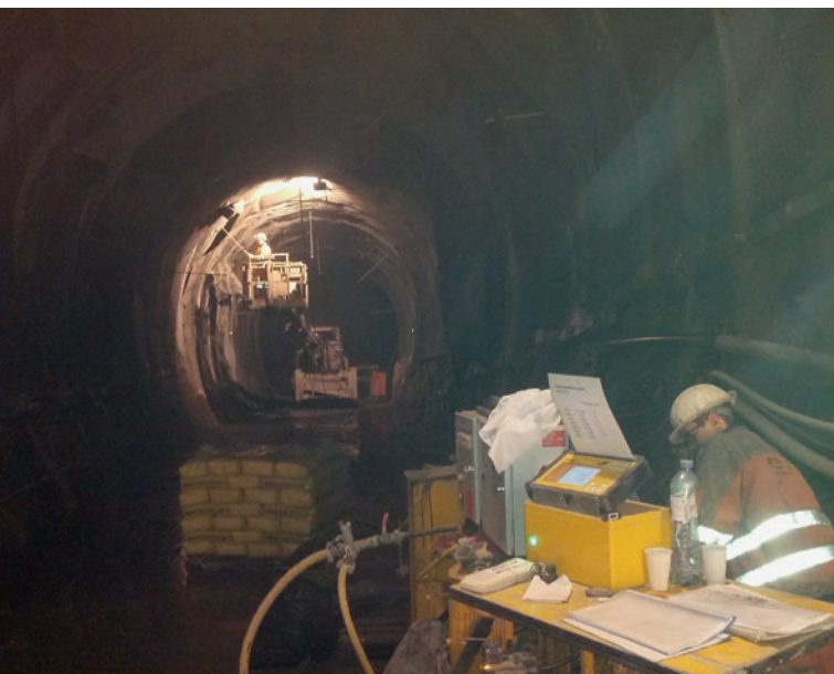
Документация тампонажа и тампотаж в гидротехническом туннеле
