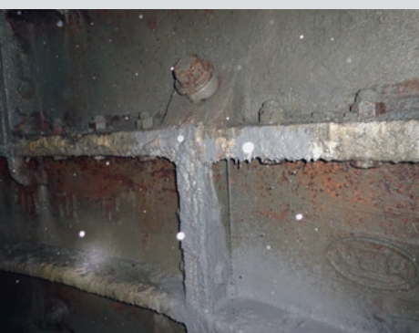
Химический инъециционный материал выходит из шва между тубингами – верный знак успешных тампонажных работ
