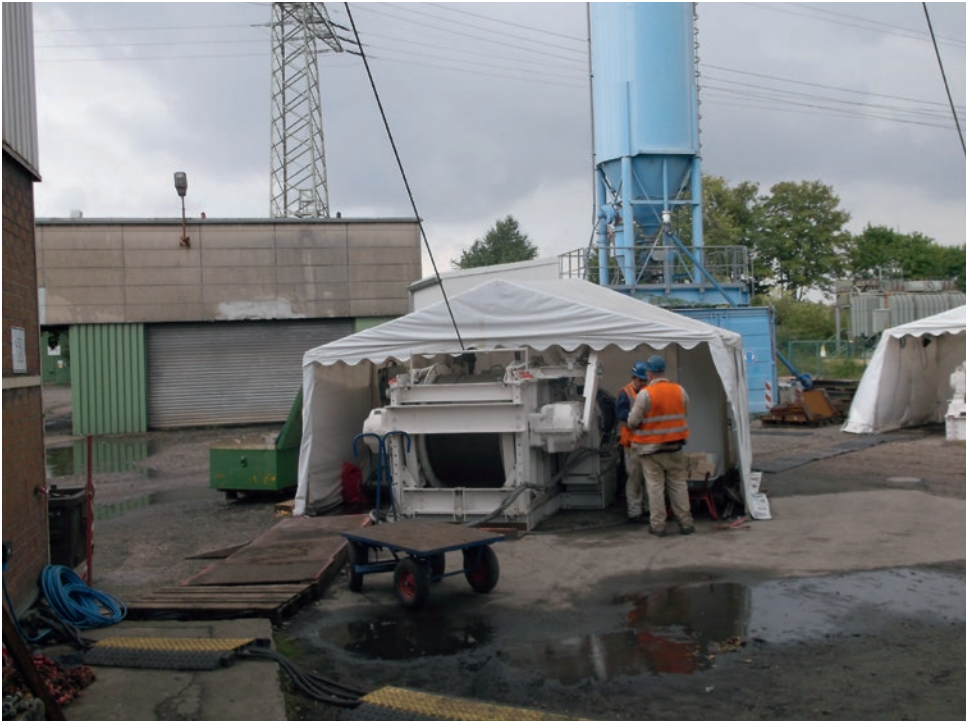
Оборудование стройплощадки – ситуация на поверхности
