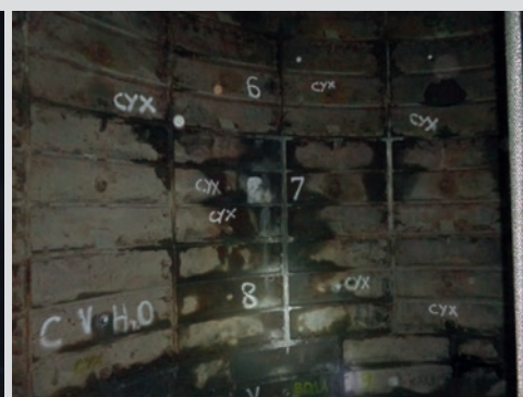
Инъециционный материал действует, поверхность тубингов высыхает
