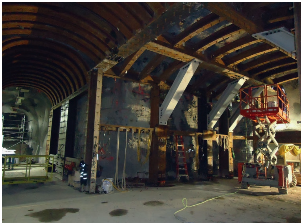
Монтаж металлоконструкций в первой стадии строительства - направление взгляда на северо-восток
