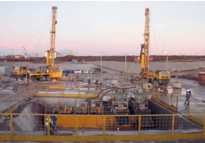
Замораживающие скважины, замораживание и искусственное оттаивание стволов в России
