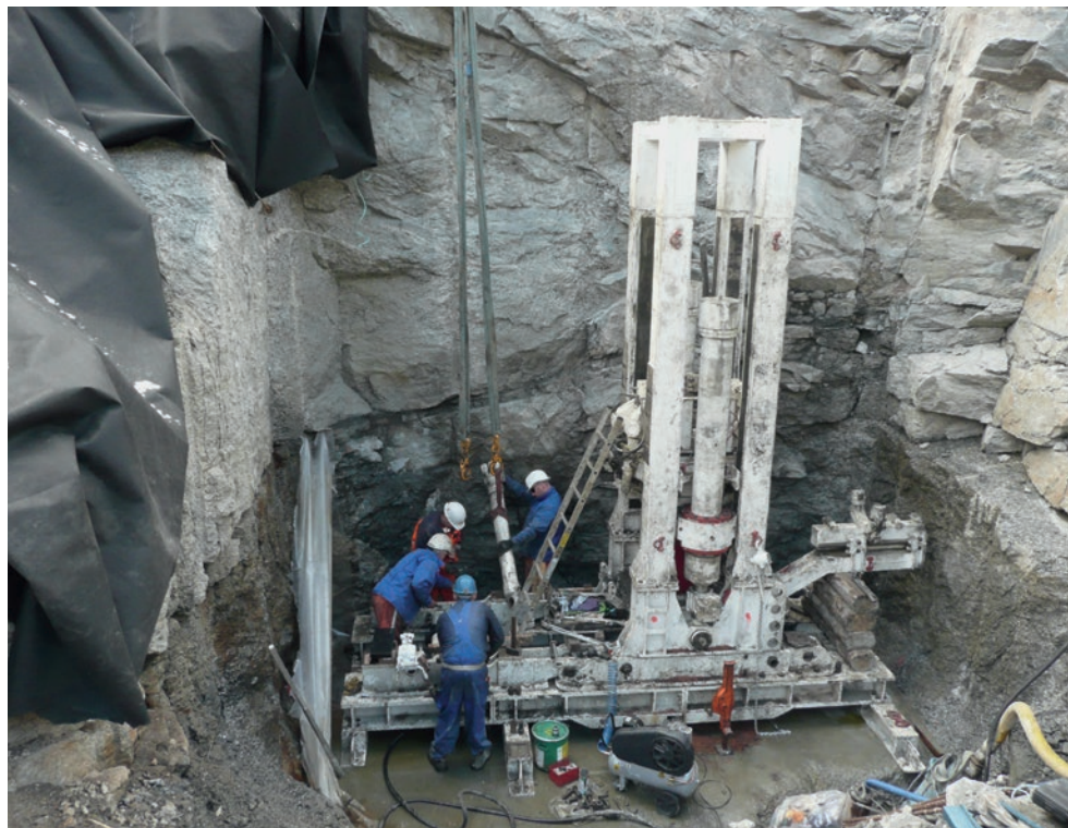
Монтаж опрокидывающего пневматического цилиндра HG 160/2
