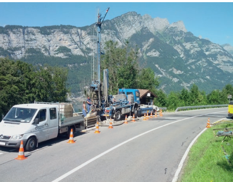
Бурение на подъездной дороге к автомагистрали
