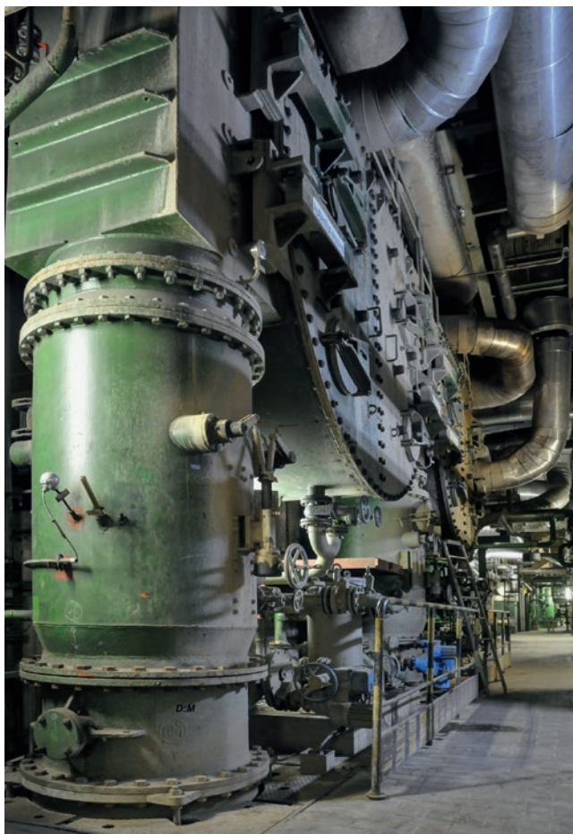
Закрытый конденсатор после осмотра, электростанция Hermann Wenzel (TKSE)
