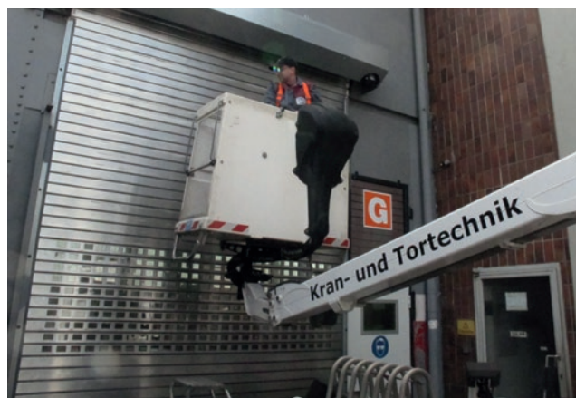
Монтаж новой установки механизированных ворот
