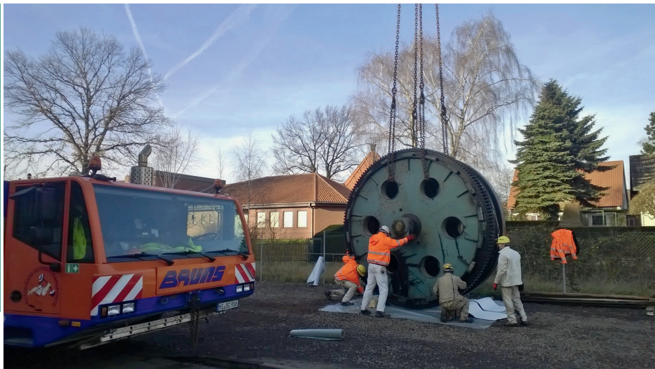
Демонтаж старых барабанов подъемной машины
