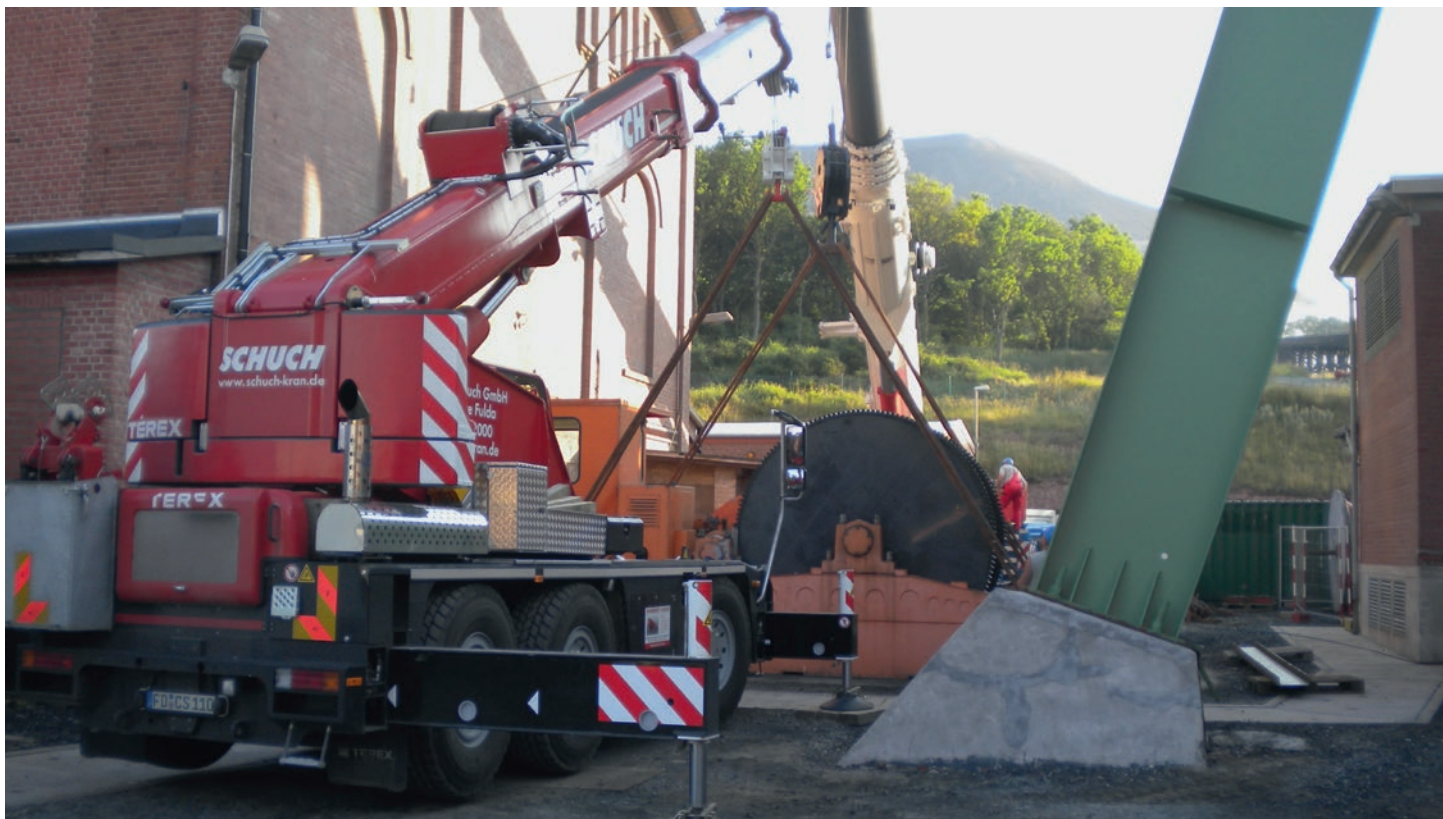
Перемещение и выверка 30-тонной лебедки с помощью пневматического подъемника, ствол «Нойхоф»
