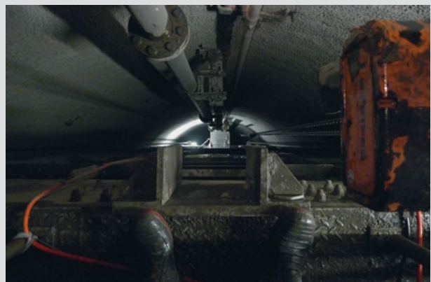
Монтаж бетоновода
