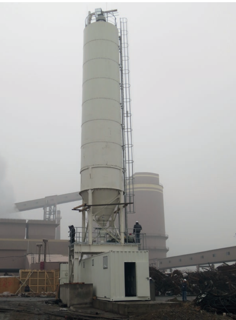
Наземный бетонный силос объемом 150 м 3
