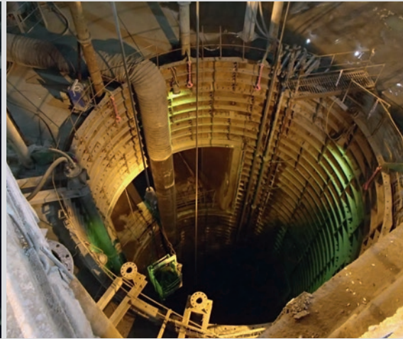
Вид сверху в технологический отход ствола СКС 1
