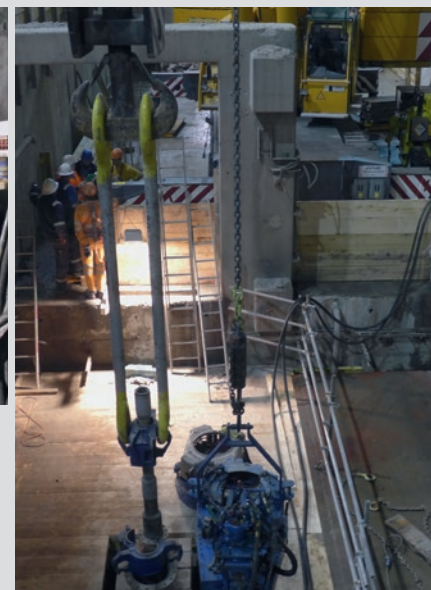
Демонтаж трубопровода API в стволе 1
