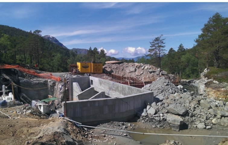
Стройплощадка Торснес, верхний бьеф и водоприемник
