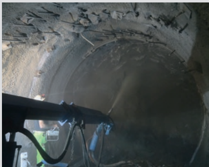
Манипулятор для нанесения набрызг-бетона MEYCO Oruga с телескопической стрелой при первичном возведении временного крепления.
