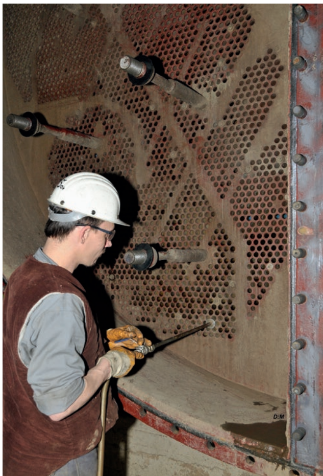
Осмотр конденсатора в электростанции Hermann Wenzel, TKSE
