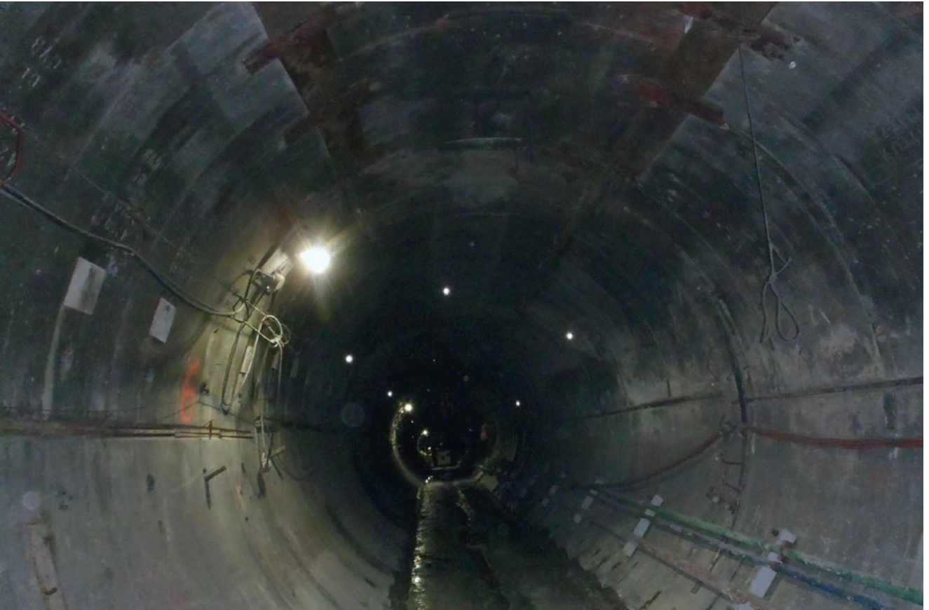
Выработка, изначально пройденная методом МДС, закрепленная железобетонными сегментами
