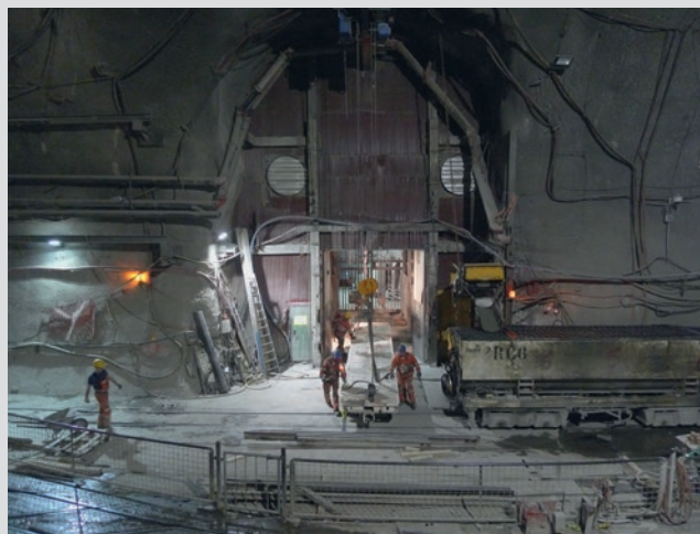
Транспорт тяжелых частей: подвешивание у оголовка ствола
