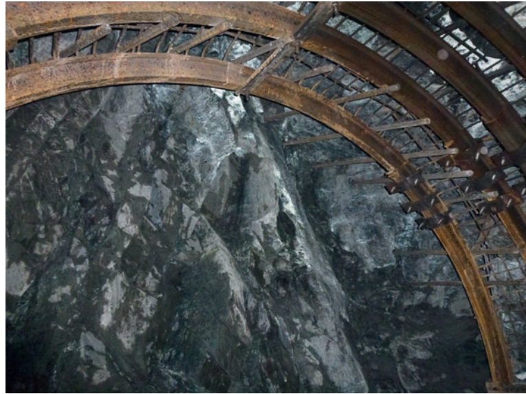
14 ноября 2012 г.: Забой северного квершлага в восточном направлении, неподвижная диагональная субпараллельная зона трещиноватости с микропустотами и тальковым налетом, ранее применяемый метод крепления
