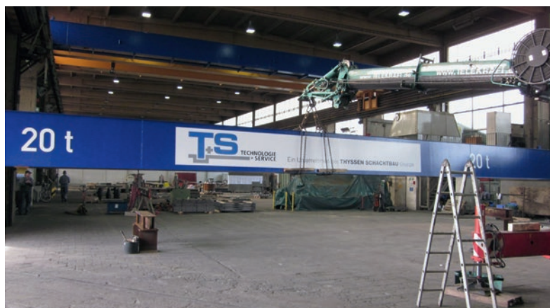
Монтаж крана весом 20 тонн после капитального ремонта
