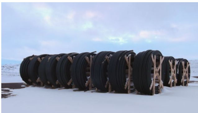
Рассолные полиэтиленовые трубы HDPE до монтажа
