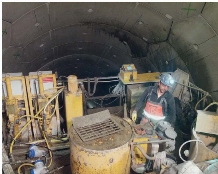
Тампотаж в наклонном стволе через железобетонные тубинги
