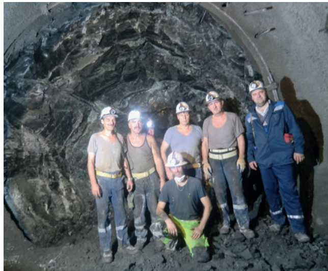
Сбойка с северной выработкой после 666 метров проходки 5го июля 2014 года
