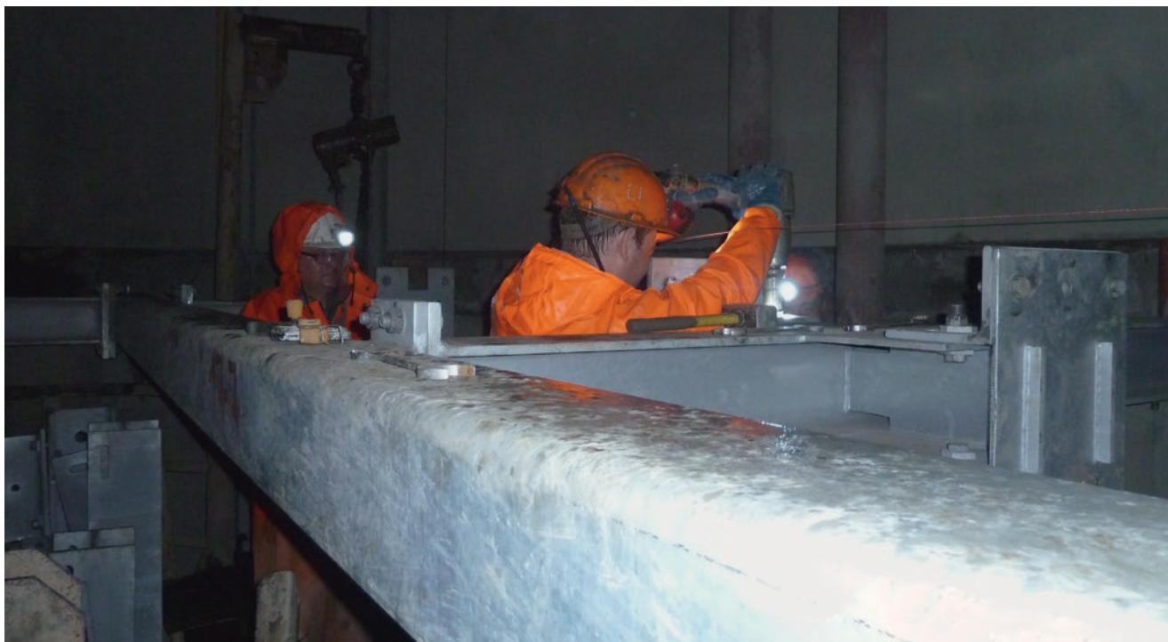
Монтаж армировки ствола одновременно с проходкой ствола ВС-10
