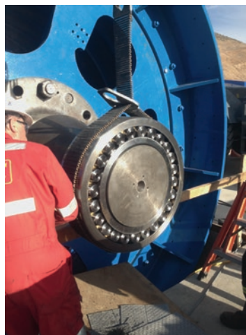
Подшипник в процессе монтажа на главный вал
