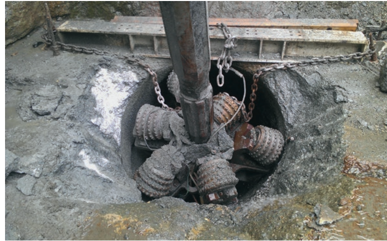
Успешная сбойка головки установки расширительного бурения
