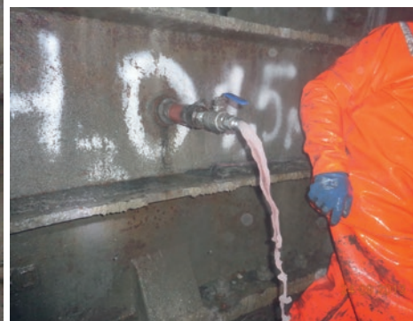
Работники во время тампонажных работ в технологическом отходе
