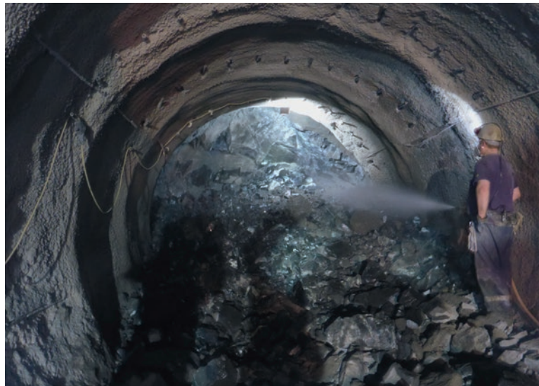
Проходка горизонтальных выработок в сложном горном массиве в г. Хромтау, Республика Казахстан
