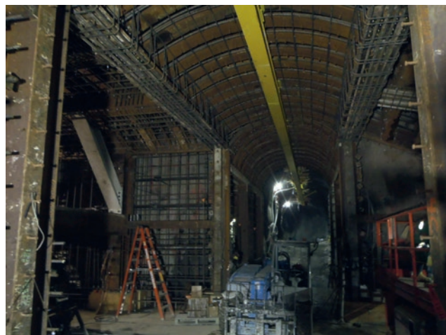
Монорельсовая подвесная железная дорога для 10-тонного грейферного крана и монтажа арматуры – направление взгляда на север
