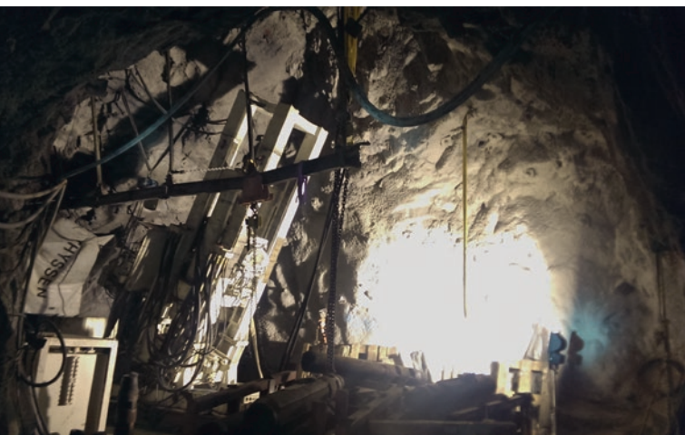
Изготовление наклонных рудоспусков в стесненных условиях
