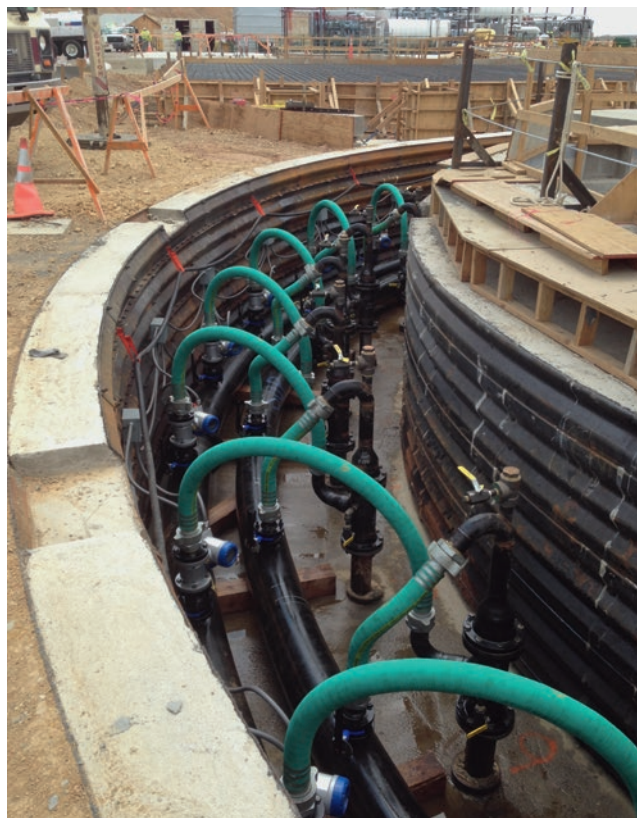
Головки замораживающих колонок, установленные в галерее рассолпроводов
