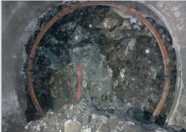
10ое сентября 2013 г.: породный массив уже не различим, проходка в АКЛ 7.1 с крепью из металлических арок
