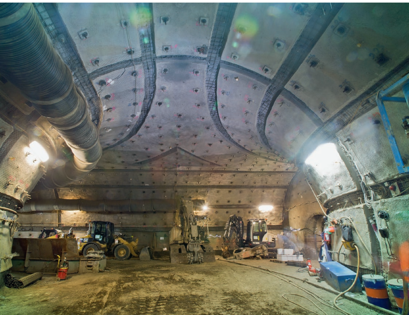
Крепь из анкеров и набрызг-бетона с оставленными шлицами в набрызг-бетоне
