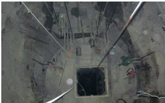
Скользящая опалубка, вид с входа на подвесной полок
