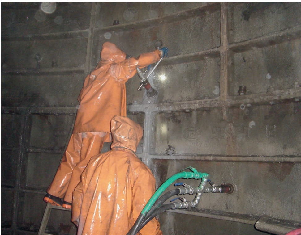
Работники во время тампонажных работ в технологическом отходе
