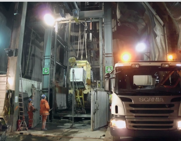
Транспорт тяжелых частей: подвешивание у оголовка ствола
