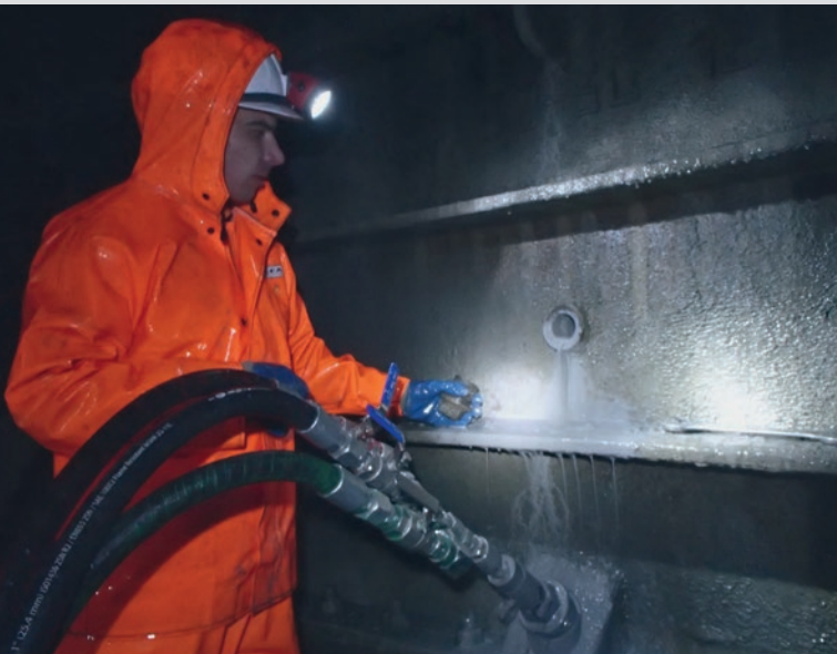
Работники контролируют ход тампонажных работ
