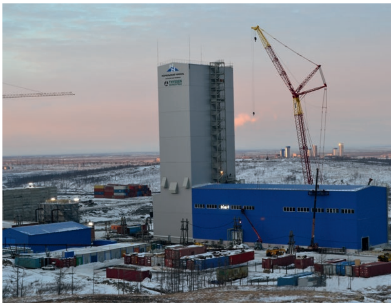
Копёр ствола ВС-10 в полярную ночь Комплекс объектов ствола СКС-1
