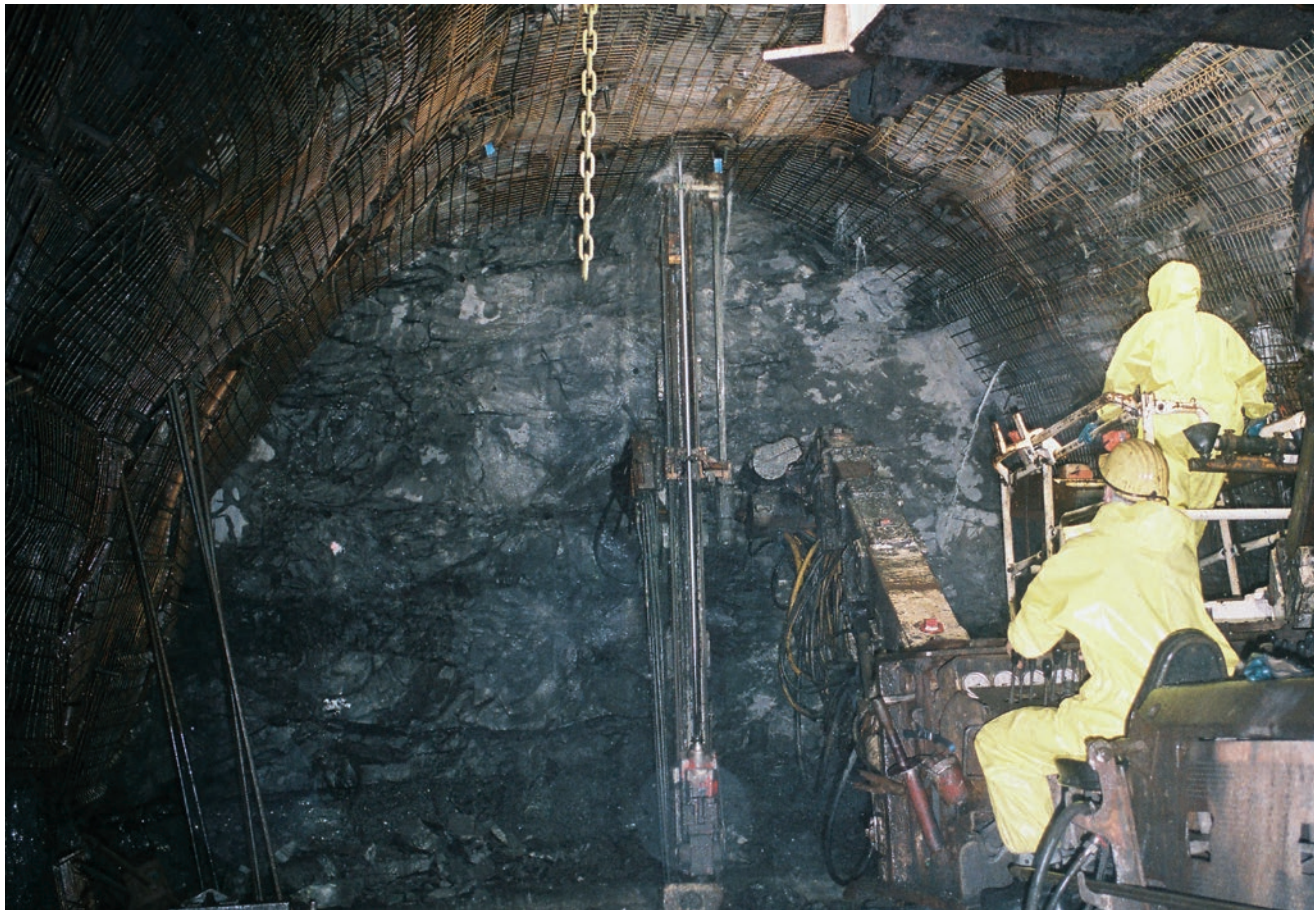
Проходка горизонтальной выработки с временной крепью
