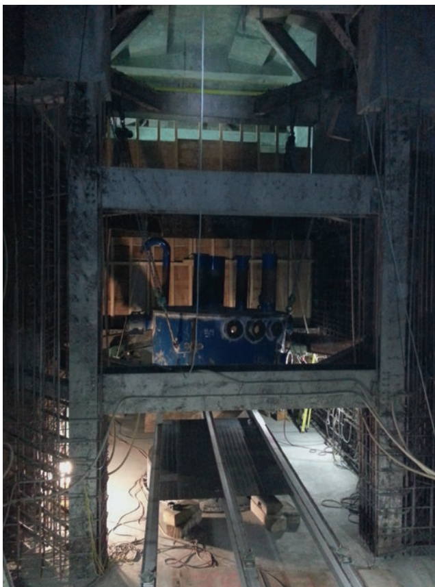
Изготовление верхнего резервуара регенерации воды, применяющее специальные подвижные балки над переходным конусом- направление взгляда на запад
