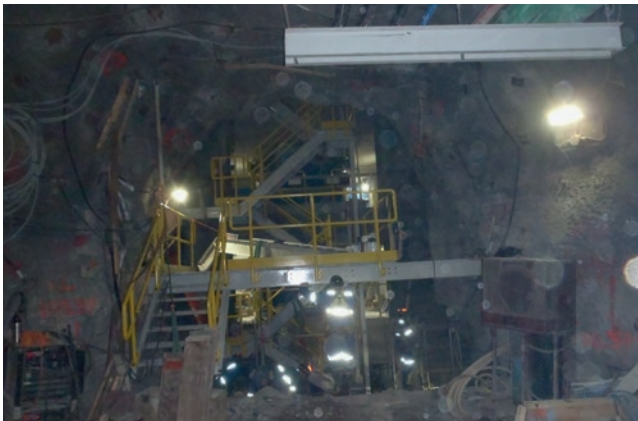
Металлоконструкция в восточном крыле- вход на почву выработки
