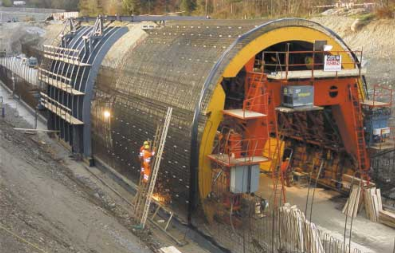
Gewölbe- und Konterschaltung für die offene Bauweise
