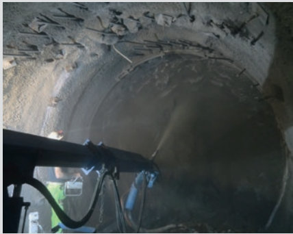
Spritzmanipulator MEYCO Oruga mit Teleskoparm bei der Erstsicherung
