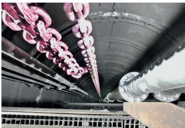
Montage der Knicksicherungen
