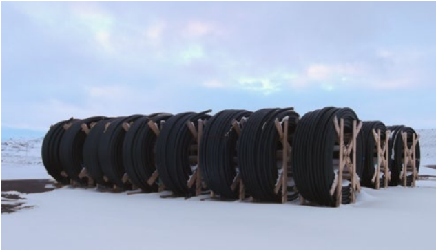
HDPE Solerohre vor dem Einbau
