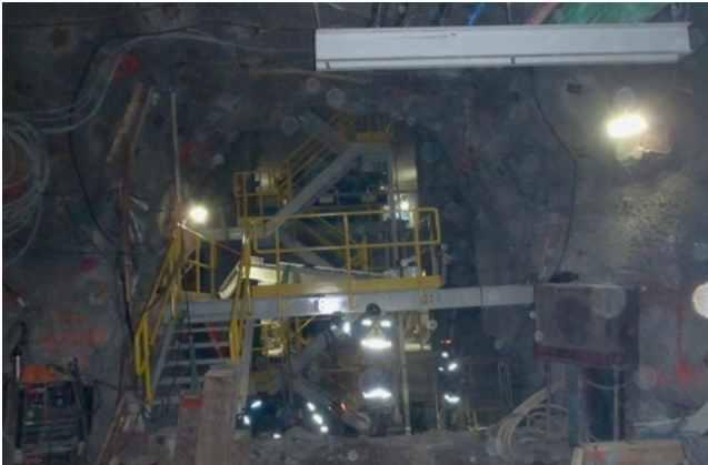
Stahlkonstruktion im Ostfeld – Sohlenzugang
