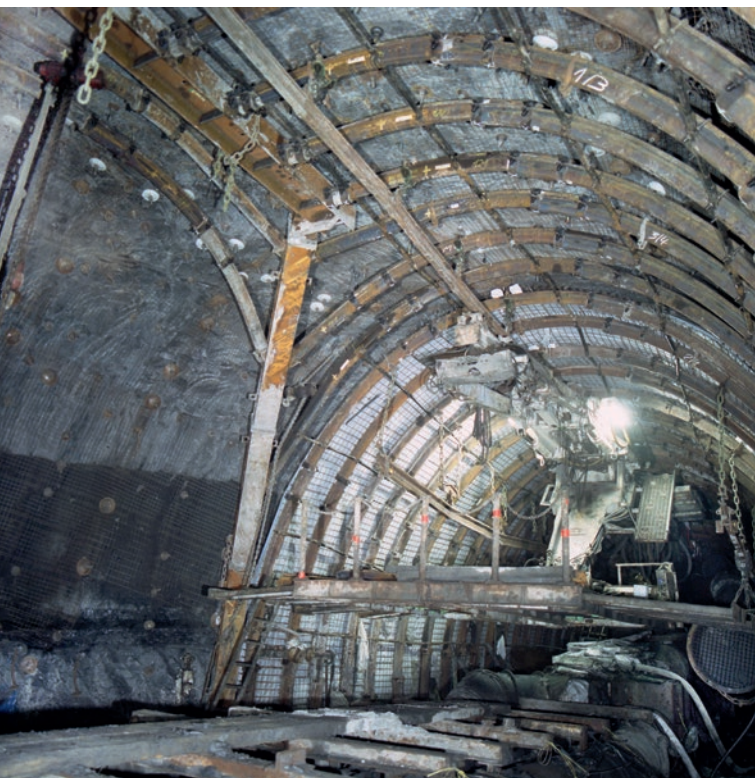
Abzweig-Polygonträger mit Ausbaubögen
