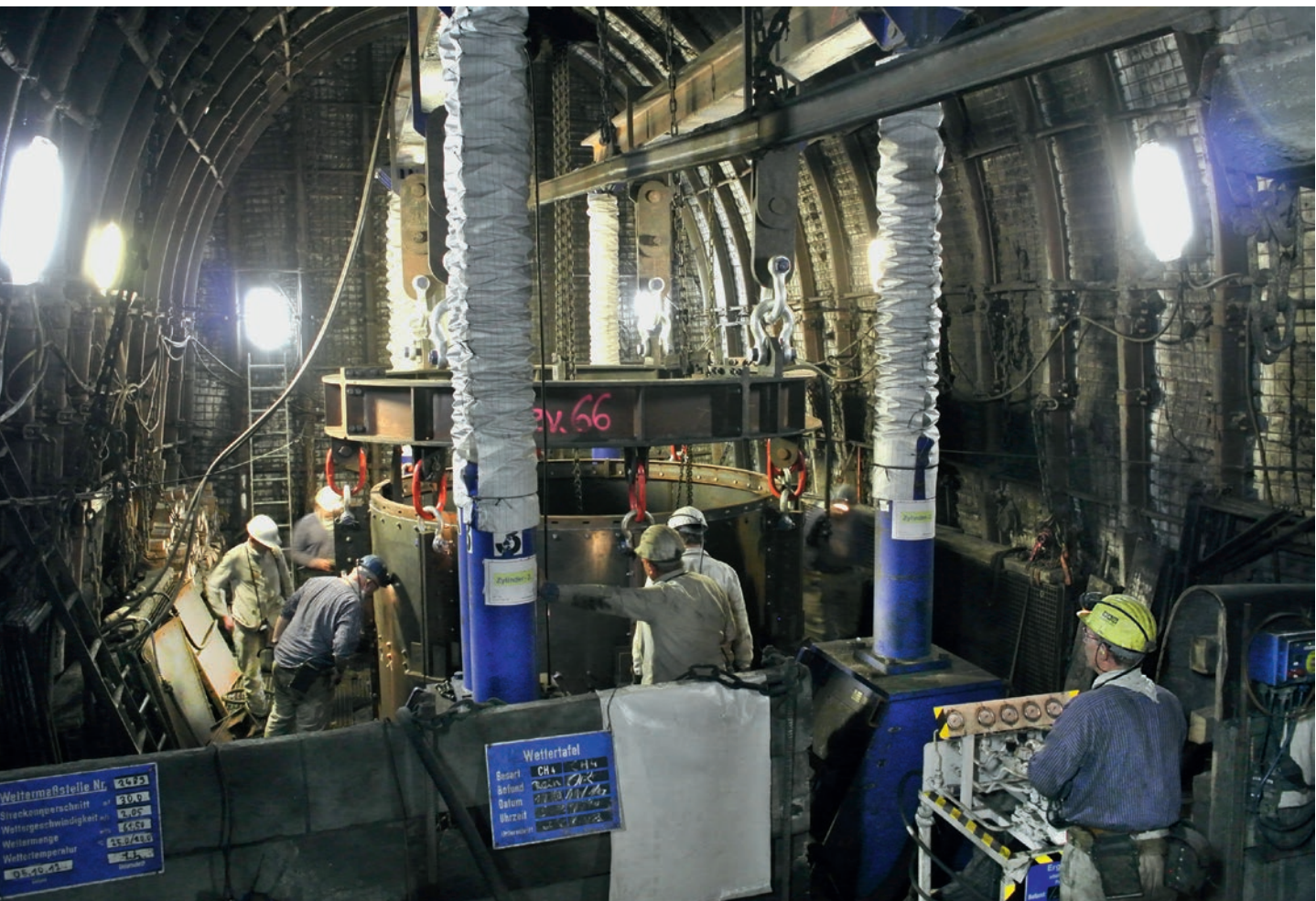
Einbau der Verrohrung mit der ringförmigen Montagetraverse
