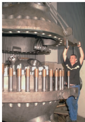
Abb. oben: Revisionsarbeiten am Kondensator im Kraftwerk Hermann Wenzel, TKSE
