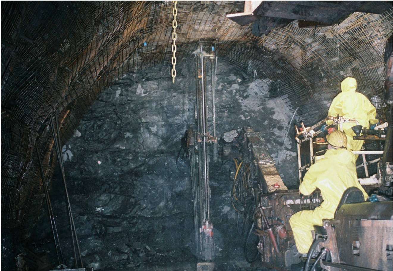
Streckenvortrieb mit vorläufigem Ausbau
