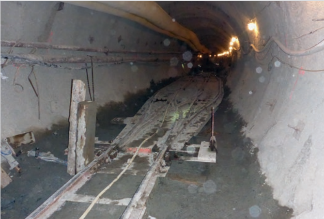
Die 3-Wege-Weiche im Querschnitt von 15 m 2
