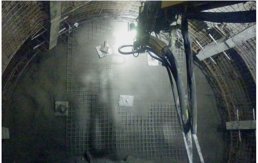
Erste Spritzbetonschicht auf der Ortsbrust; Anfang des Tunnels 765, schlechte Gebirgsverhältnisse
