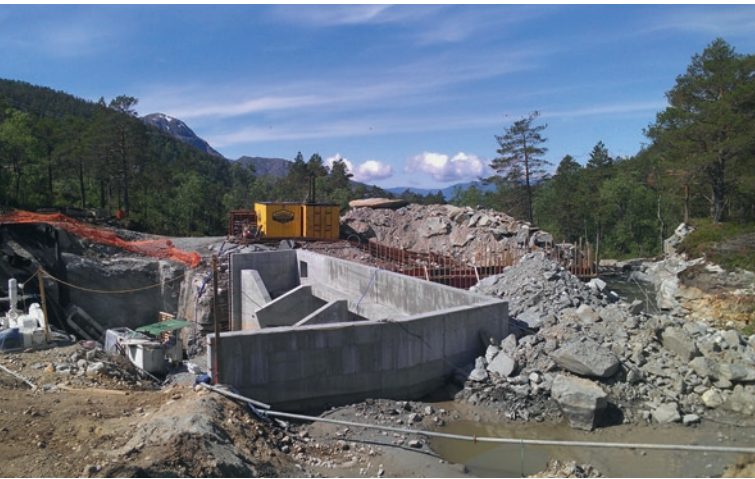
Baustelle Torsnes, Oberbecken und Einlaufbauwerk
