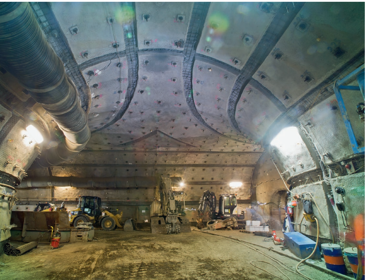
Geschlitzter Spritzbetonausbau mit Systemankerung
