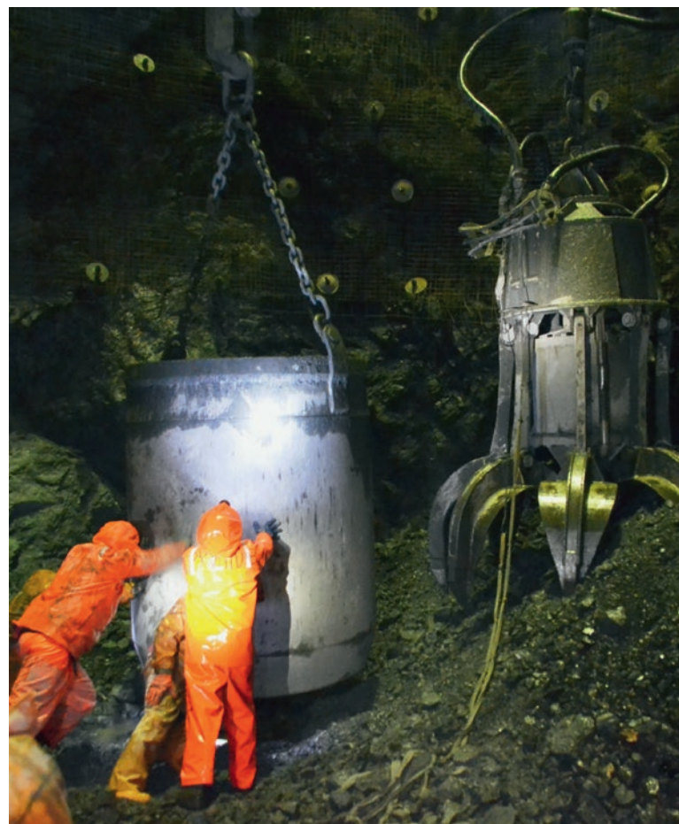
Berge laden mit dem 1,2 m 3 Greifer und 5 m 3 Kübel
