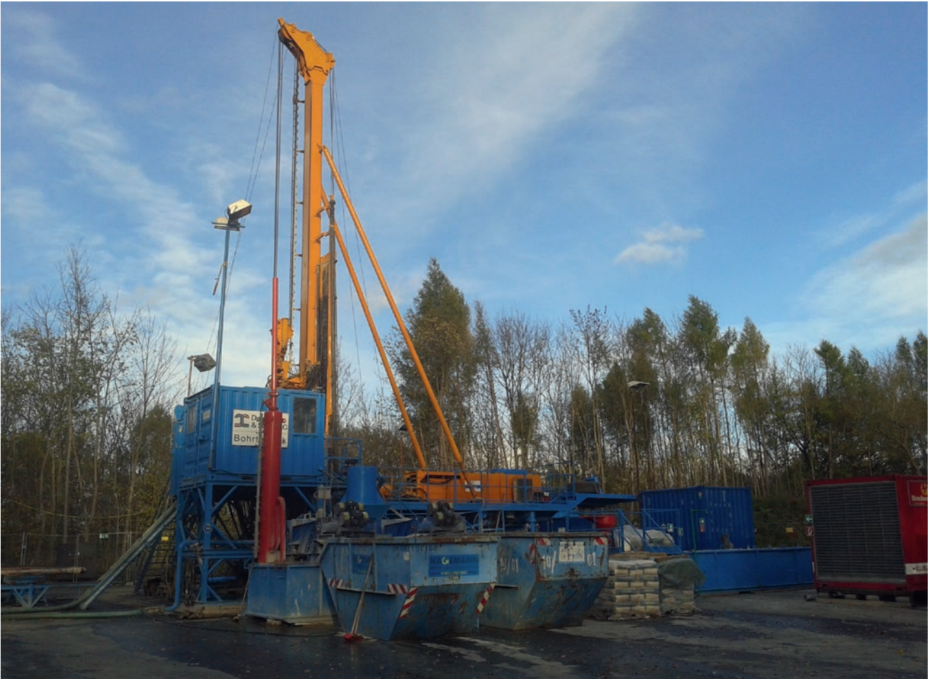
Bohrplatz REMLINGEN 15 der Asse GmbH
