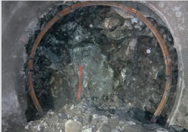
10. September 2013: Ein Gebirgsverbund ist nicht mehr erkennbar, Vortrieb in AKL 7.1 mit Stahlbogen
