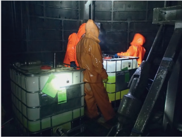
Chemisches Injektionsmittel zur Entnahme
