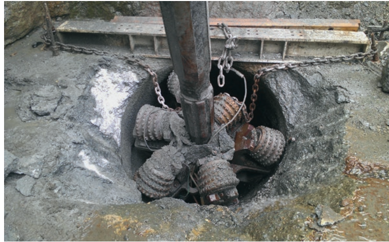
Erfolgreicher Durchschlag des Raisebohrkopfes
