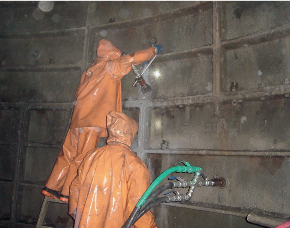
Abb. links: Mitarbeiter bei Verpressarbeiten im Vorschacht
