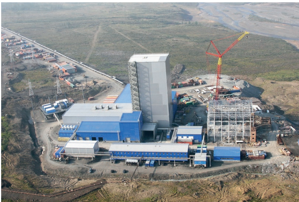
Errichtung von zwei schlüsselfertigen Bergwerken in Norilsk, Sibirien
