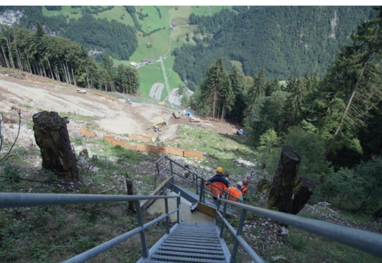
Baustellenbegehung der anderen Art
