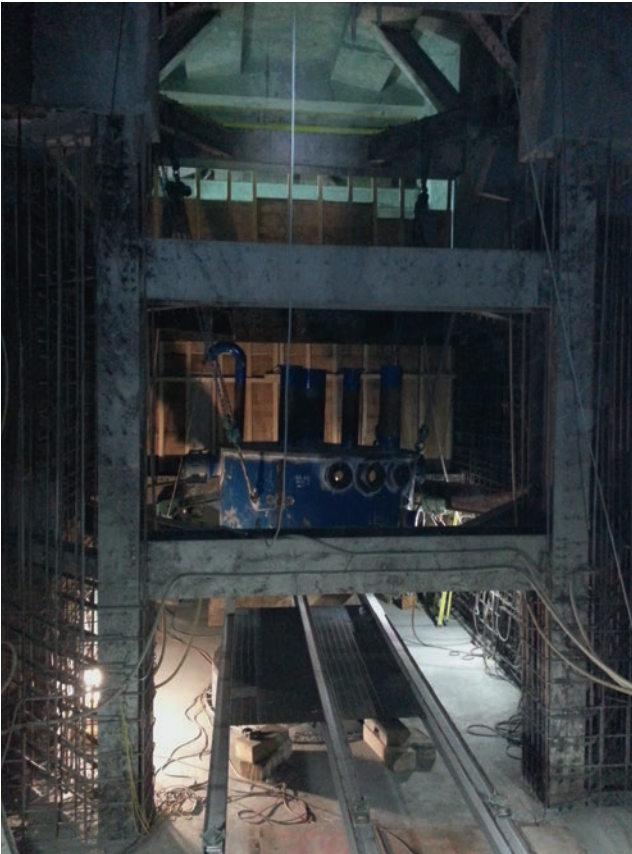
Erstellung des oberen Wasserrückgewinnungstanks unter Verwendung angepasster Verlagerungsträger über dem Auslauftrichter
