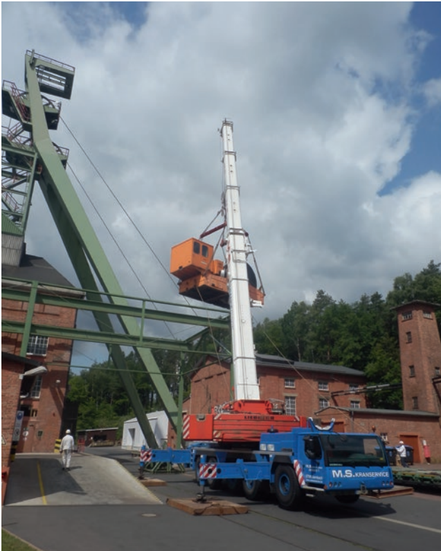
Umsetzen der 30 t-Winde an Schacht Ellers
