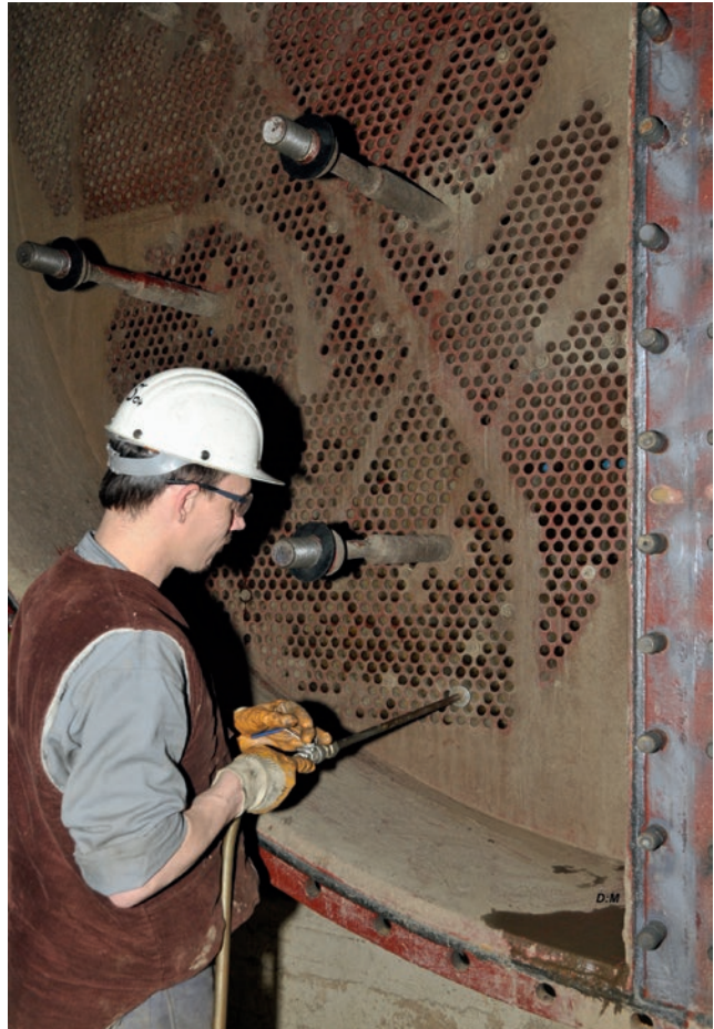
Abb. oben: Revisionsarbeiten am Kondensator im Kraftwerk Hermann Wenzel, TKSE
