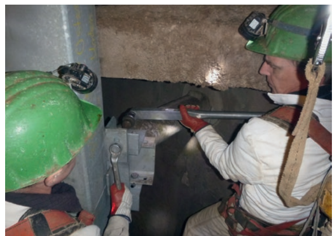
Abb. unten: Modernisierung Schachtförderanlage Konrad 1 – Spurlatteneinbau Alle Abbildungen: Jörg Scheibe, Hermannstr. 1, 38114 Braunschweig – Pressefotografie/ Fotodesign im Auftrag der ASK 1
