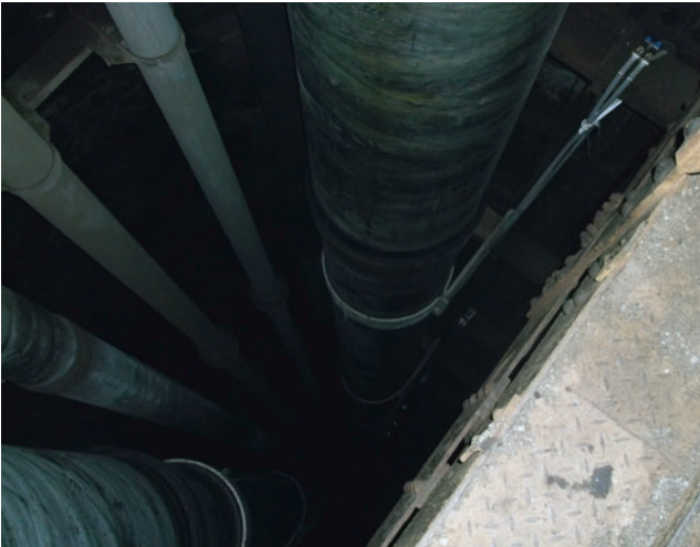
Fertig eingebaute Hüllrohre mit Halterung
