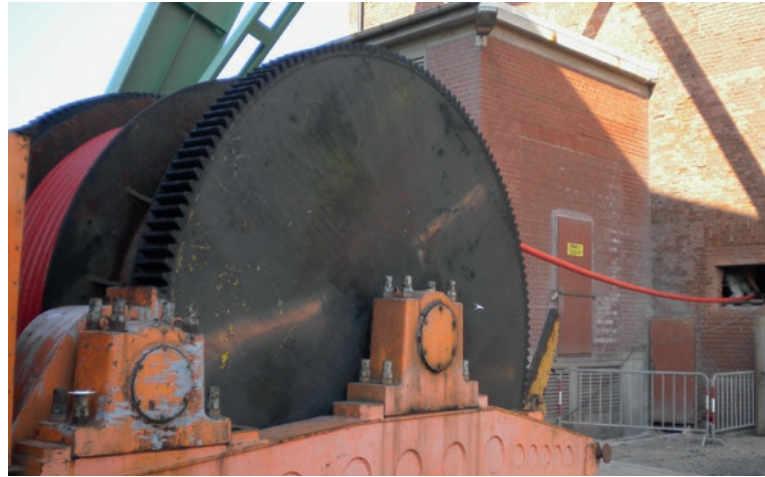
Einbau des 20-kV-Kabels, Schacht Neuhof
