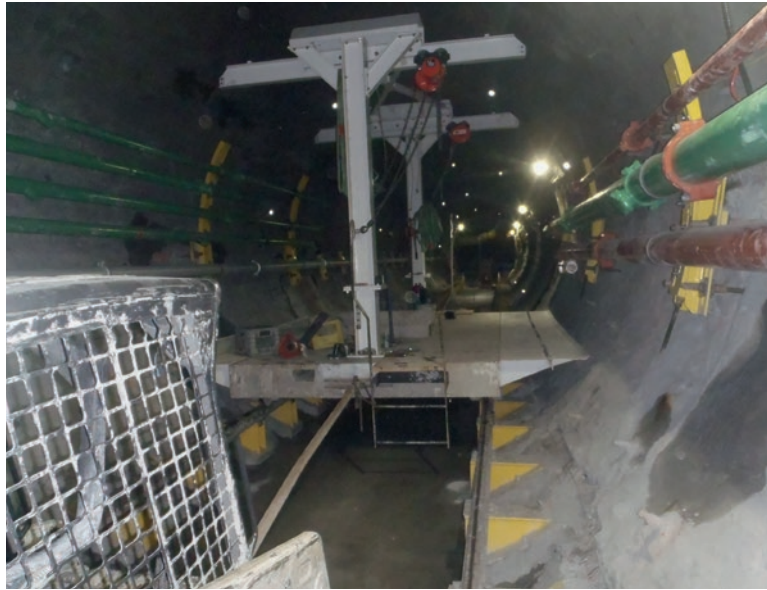
Rohrwagen für den Einbau der Ausrüstungen im Förderstollen
