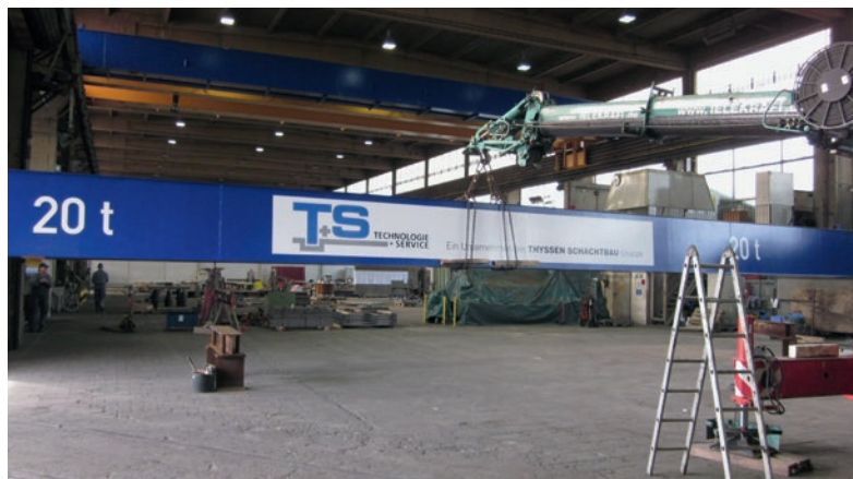
Neumontage des 20 t Krans nach Komplettanierung
