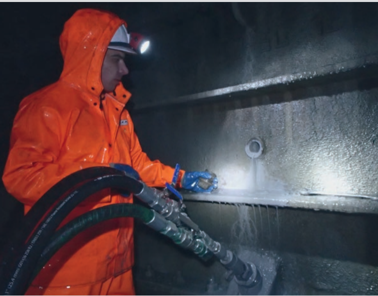
Abb. links: Mitarbeiter bei der Kontrolle des Verpressvorganges
