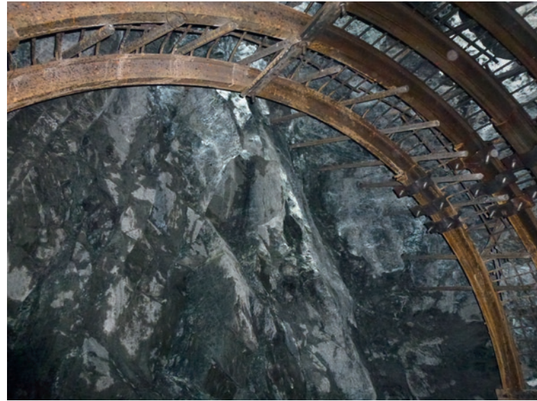
14. November 2012: Ortsbrust nördlicher Querschlag nach Westen, steilstehende diagonale, subparallele Großklüftung mit Harnischen und Talk-Belag, bisherige Ausbaumethode
