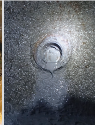
Das Injektionsmittel tritt an offener Entspannungsöffnung aus
