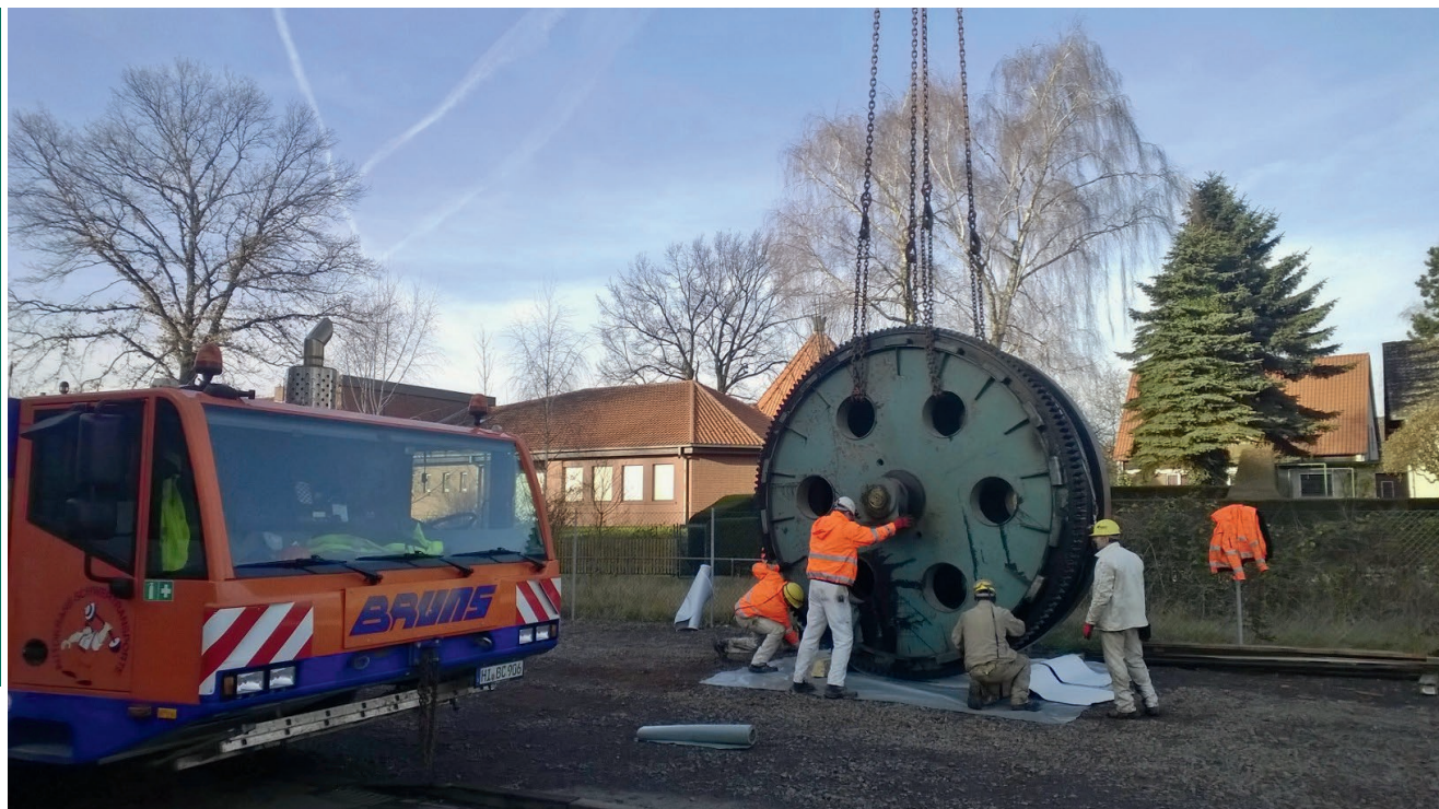
Demontage der alten Fördermaschinentrommel
