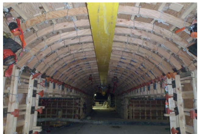
Aufwendige Schalung, bestehend aus Stahlbögen in Ausbaustufe 1 – Bereit zur Betonhinterfüllung
