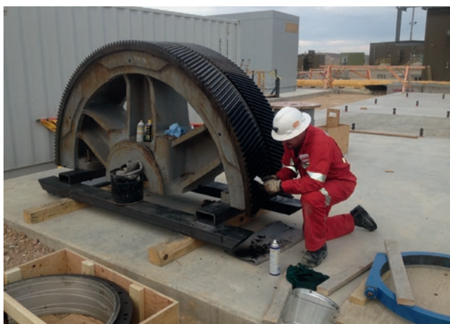
Eine Förderradhälfte wird für den Einbau vorbereitet
