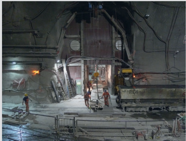
Abb. links: Schwerlasttransport: Einhängen am Schachtkopf Abb. oben: Entladung von überlangen Plattenwagen am Schachtfuß
