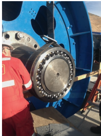
Endlager beim Einbau auf der Hauptwelle
