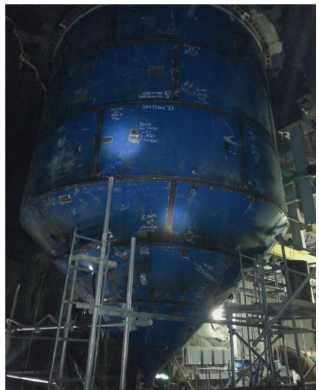
Bau des unteren Wasserrückgewinnungstanks
