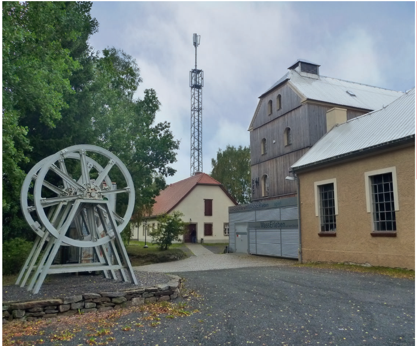
Drei-Brüder-Schacht mit Scheidebank, Schachthaus und Maschinengebäude
