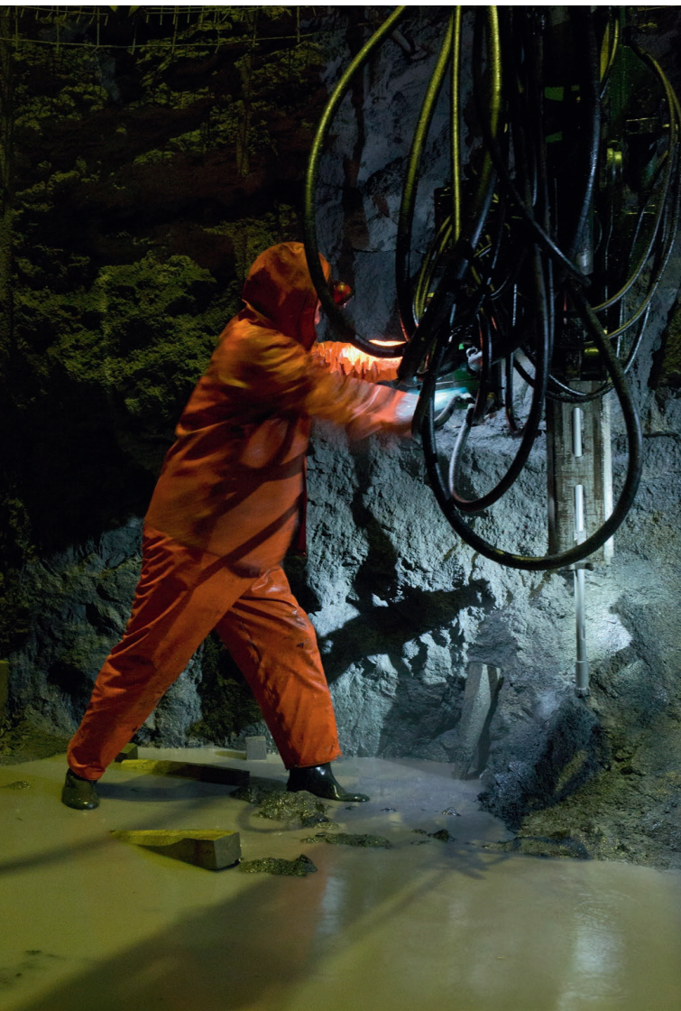
Einsatz eines sechsarmigen Schachtbohrgeräts
