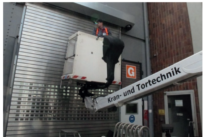
Montage einer neuen Toranlage
