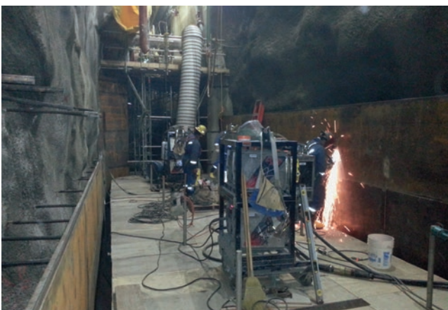
Stahlauskleidung des Erzlagertanks Süd – Blickrichtung Nord
