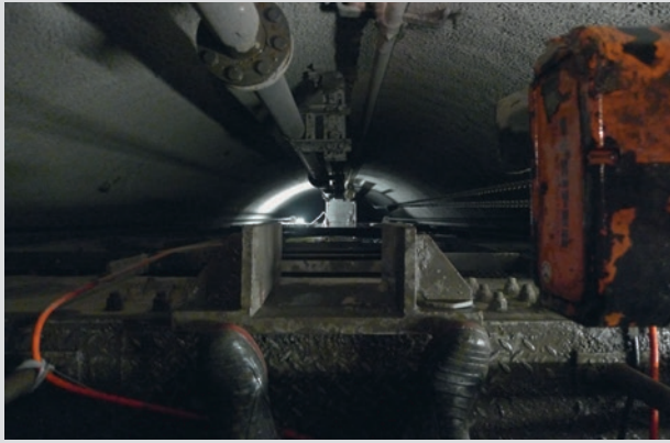
Abb. oben links: Montage der Betonfalleitung
