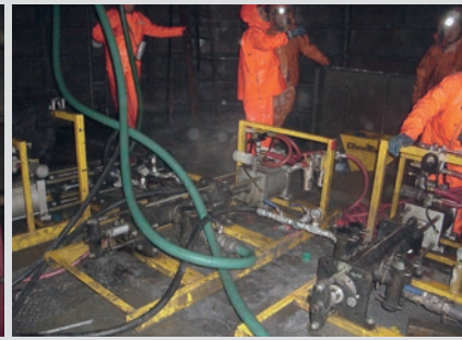
Abb. Mitte: Verpressarmatur für chemisches Abdichtungsmittel „NOH20“
