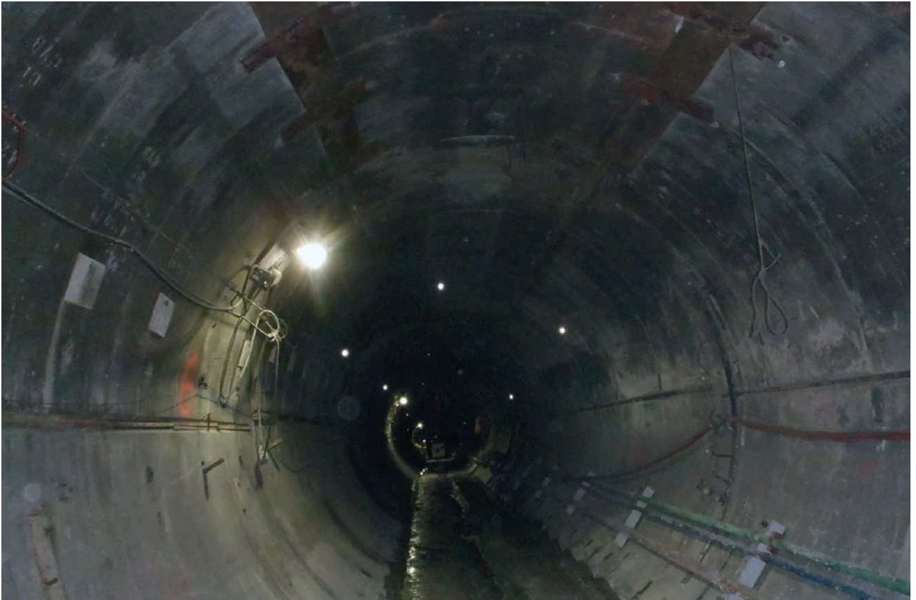
Der ursprüngliche, mit Betonfertigteil-Segmenten ausgekleidete MDS-Stollen
