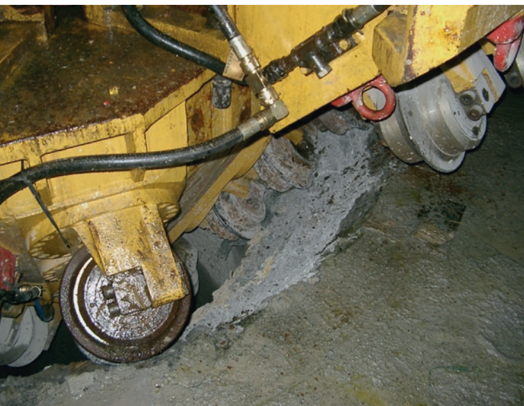
Anschneiden der Schachtbohrung mit der Schachtbohrmaschine VSB VI
