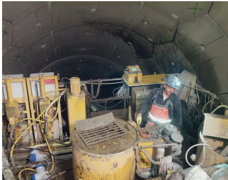
Injektion im Schrägschacht durch die Beton-Tübbinge
