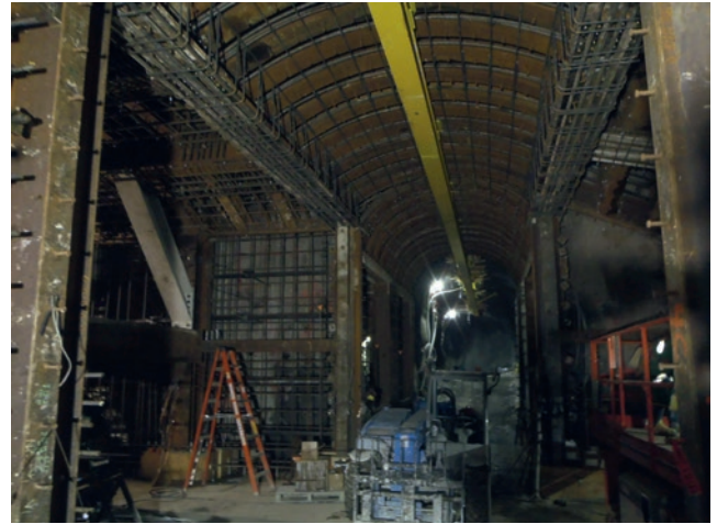
Einschienenhängebahn für 10-t-Greiferkran & Bewehrungseinbau – Blickrichtung Süd
