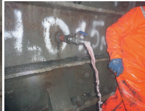
Abb. links: Mitarbeiter bei Verpressarbeiten im Vorschacht
