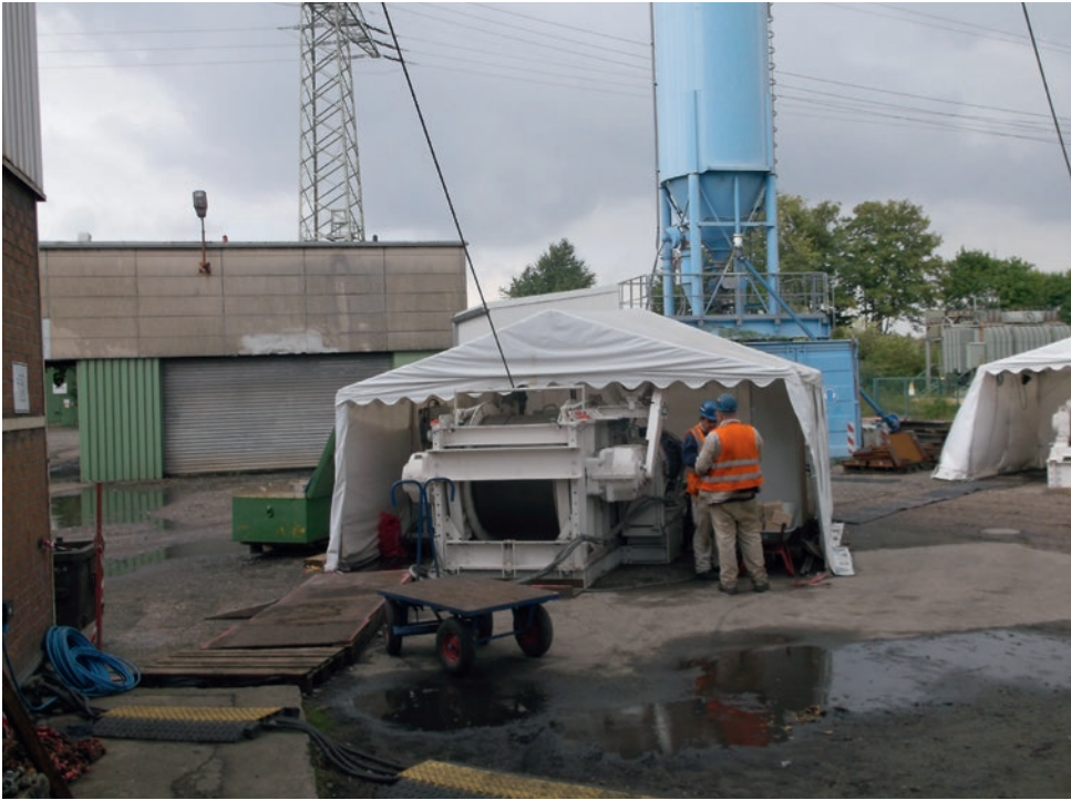
Einrichten der Baustelle – Situation über Tage
