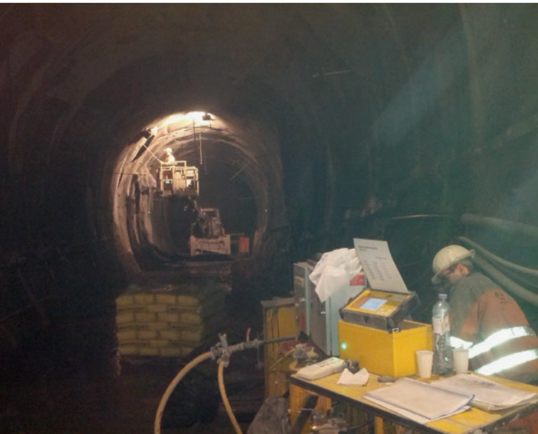
Injektionsaufzeichnung und Injektion in einem Triebwasserstollen
