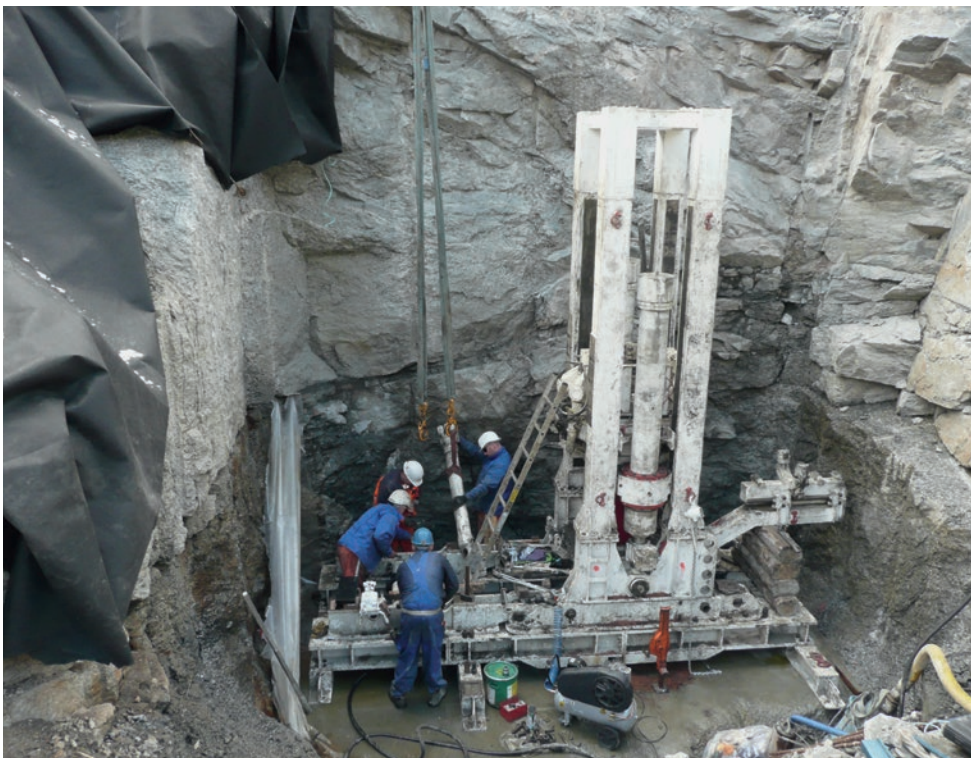
Montage der Kippzylinder, HG 160/2
