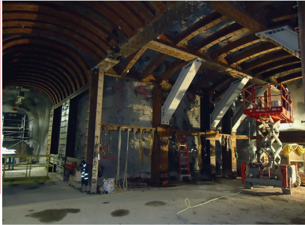
Stahlbaumontage in der Ausbaustufe 1 – Blickrichtung Nordost
