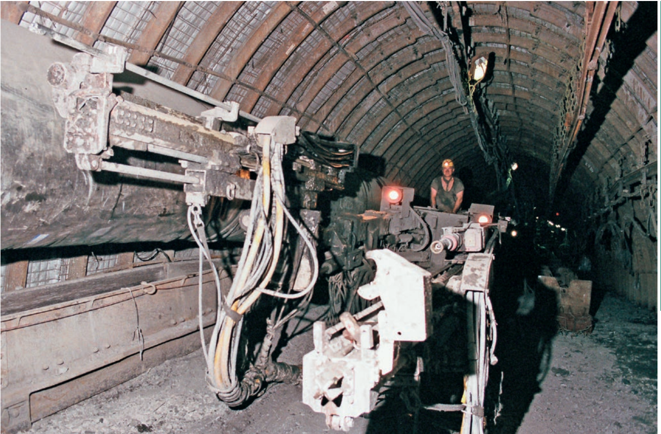
Bohrwagen BTRK – 2 erstellt Spreng- und Ankerbohrlöcher
