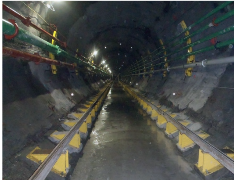
Förderstollen 765 nach der Ausstattung mit Schienensystem und Versorgungseinrichtungen
