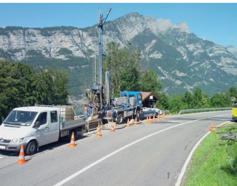
Bohrung auf der Zufahrtsstraße zur Autobahn
