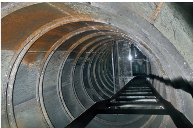
Fahrschacht mit eingebauter Verrohrung
