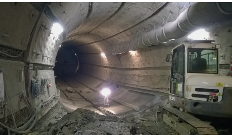
Einlagerungstransportstrecke Nord, Sohlenausbruch mit Vortriebsbagger
