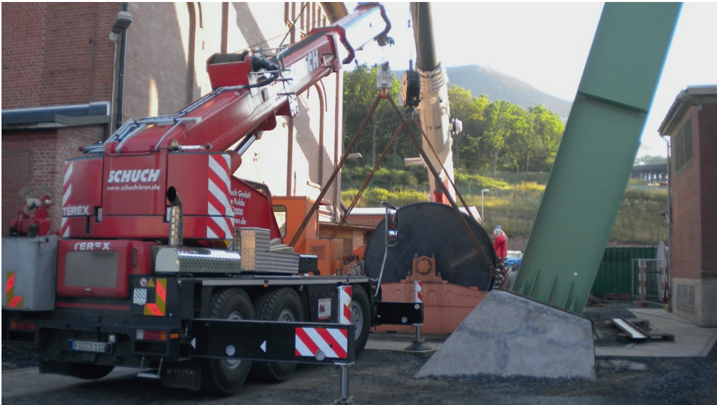
Umsetzen und Ausrichten der 30-t-Winde mittels Tandemhub, Schacht Neuhof
