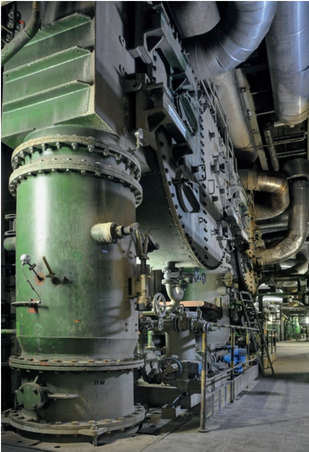
Kondensator geschlossen nach der Revision, Kraftwerk Hermann Wenzel, TKSE
