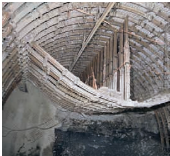
Auffahrung Abschnitt 2a und 2b
