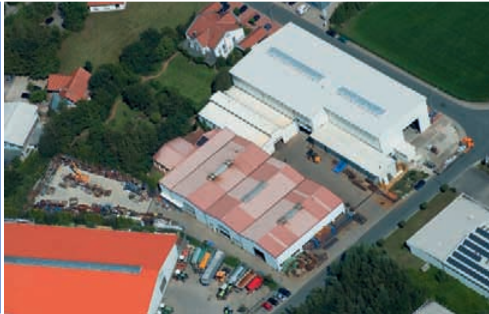
Luftaufnahme OLKO-Maschinenteknik GmbH
