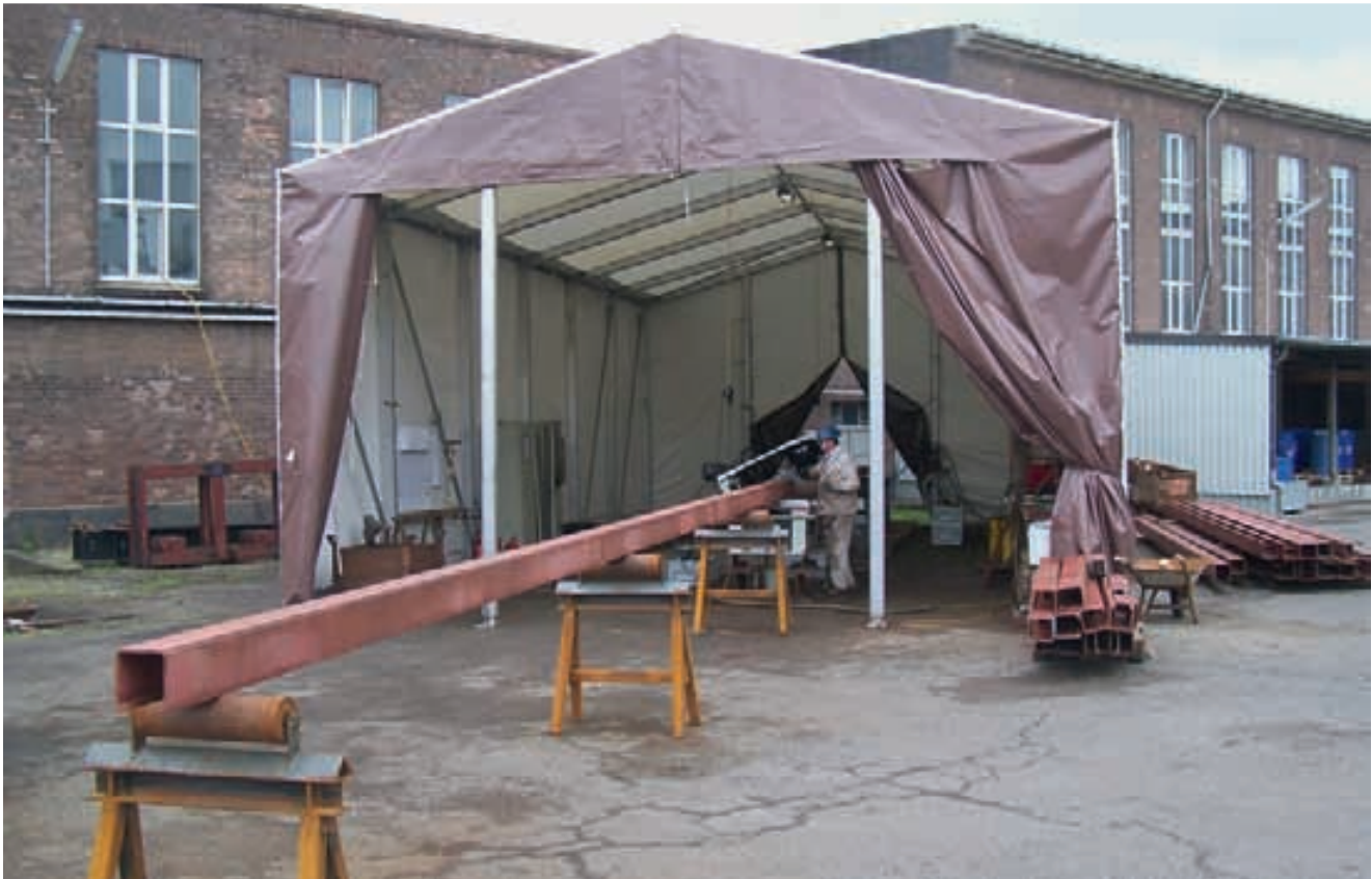
Richtstraße zum Vorbereiten der Spurlatten
