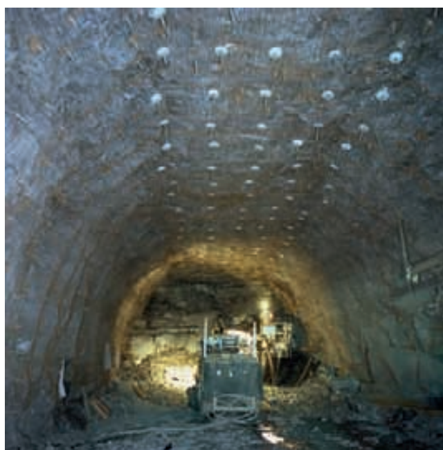
Auffahrung C432 im kombinierten Ausbau Typ A
