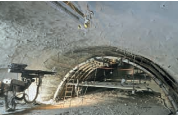
Beginn des Stahlausbaus im Firstbereich
