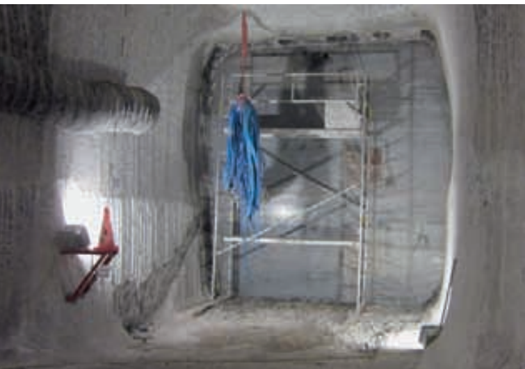
„Luftseite“ des fertig erstellten Dammbauwerkes
