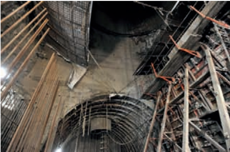
Erstellen der Wände für die Trichterverlagerung, Schutzdächer zur Verhinderung der Verschmutzung der Bewehrung
