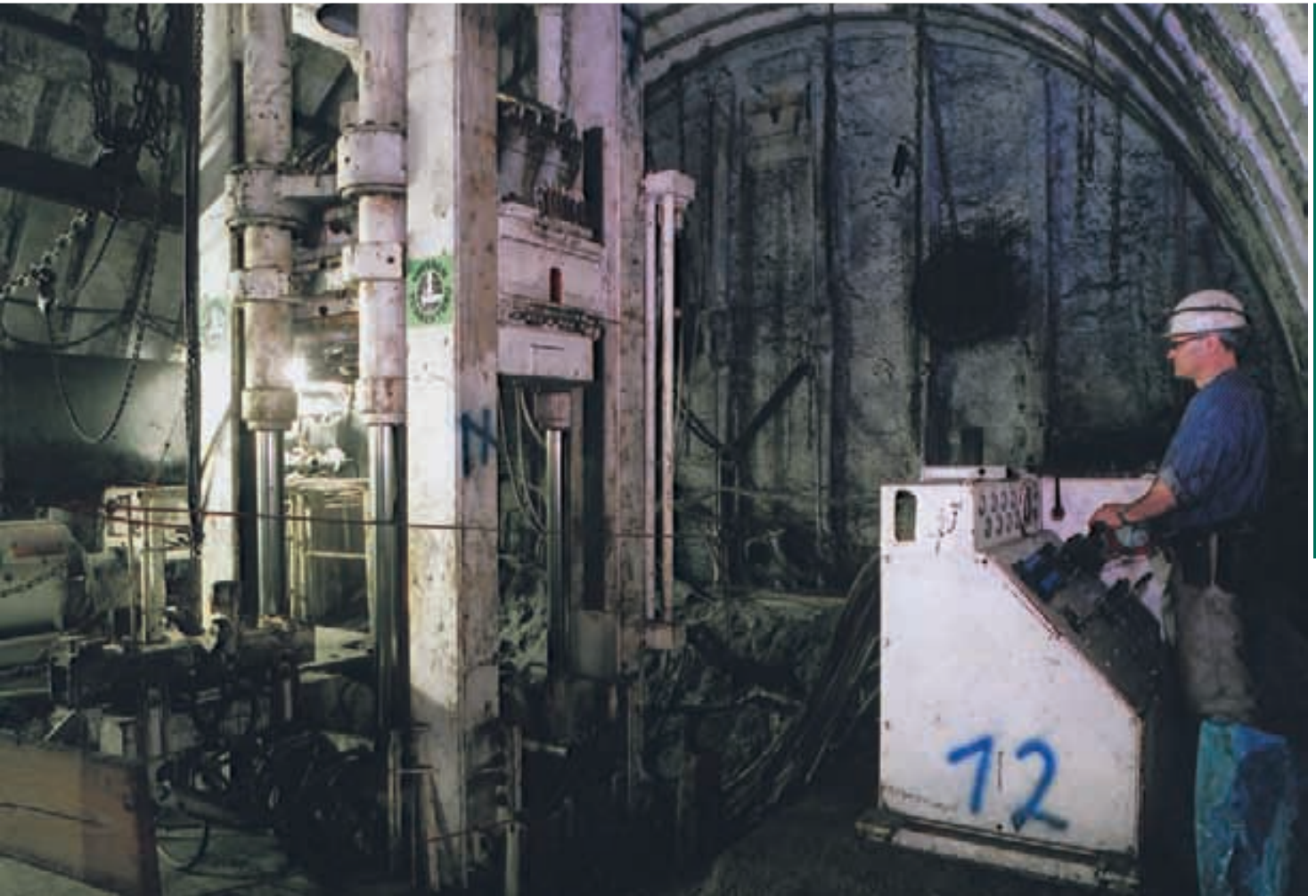
Raisebohrgerät HG250 im Einsatz
