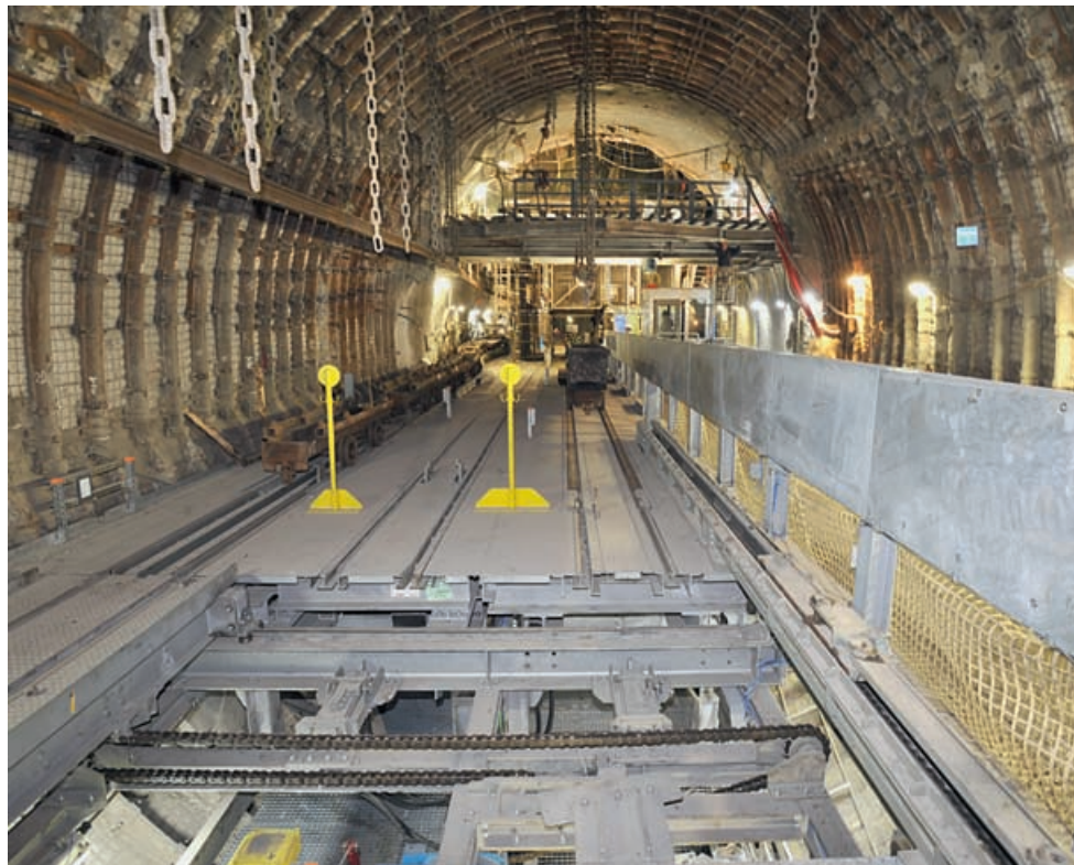
Südliches Füllort mit Gleisanlage
