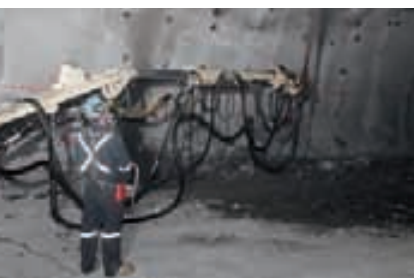
Spritzbetonfahrzeug beim Aufbringen einer Betonschale
