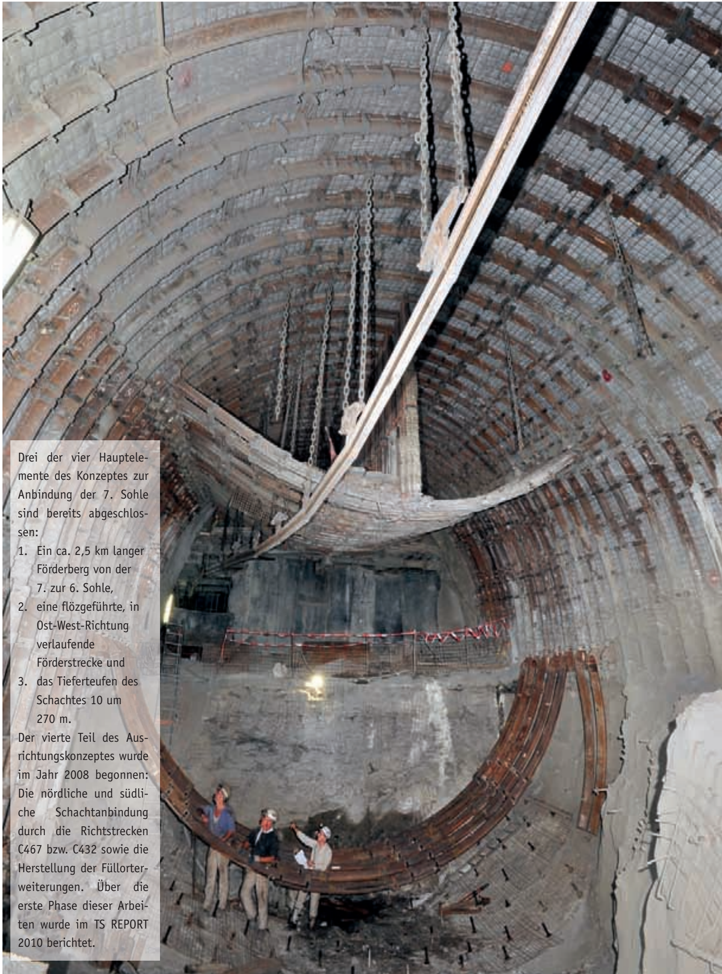
Montage der Sohlschlüsse mit Systemankerung
