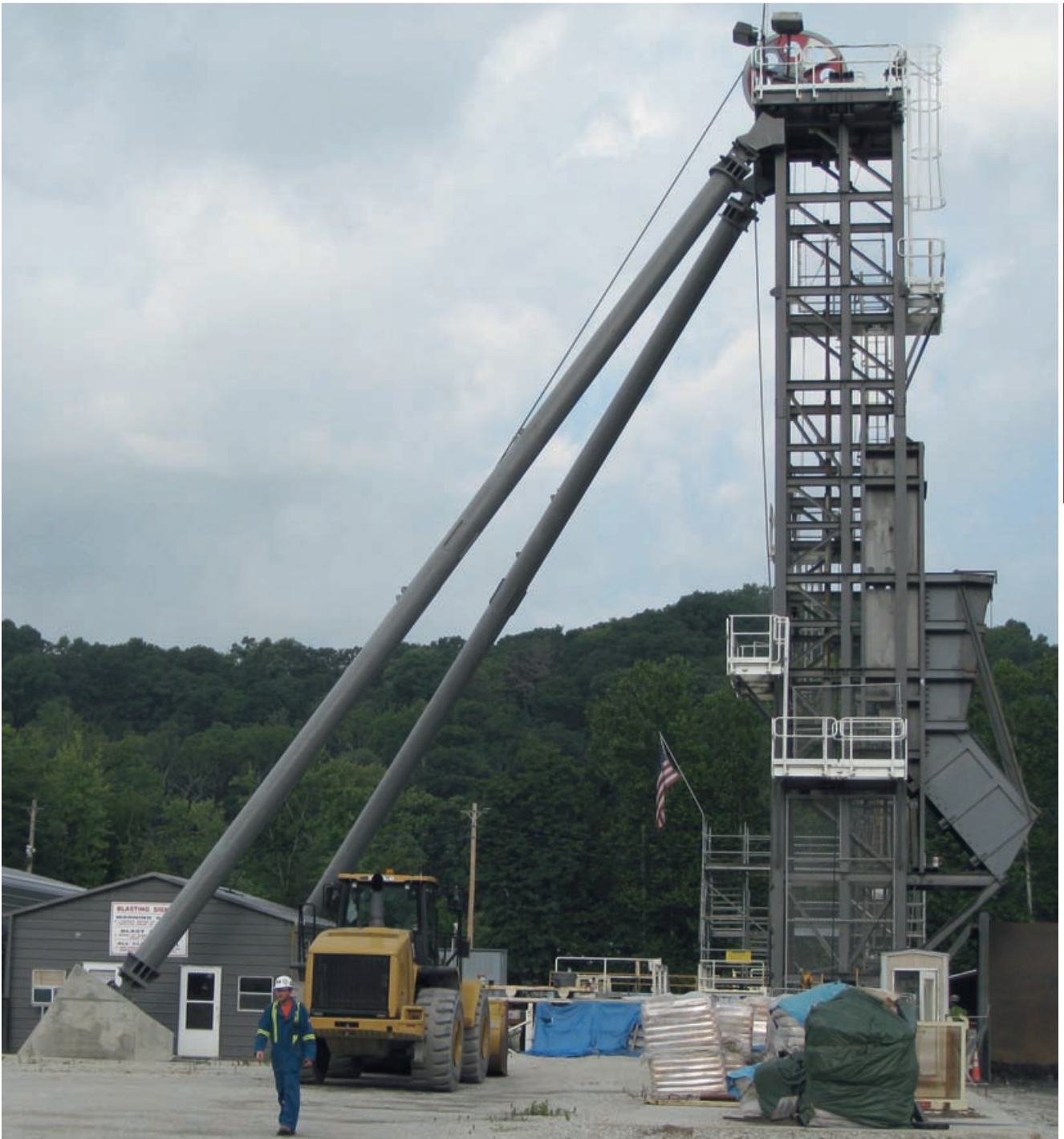
Das Schachtgerüst für den Zugang zu der Kaverne
