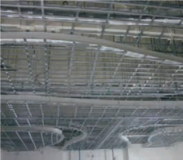
Ballsaaldecke Hotel Hilton in der Bauphase
