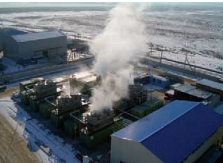
Blick auf den Schachtplatz Gremjatschinskij
