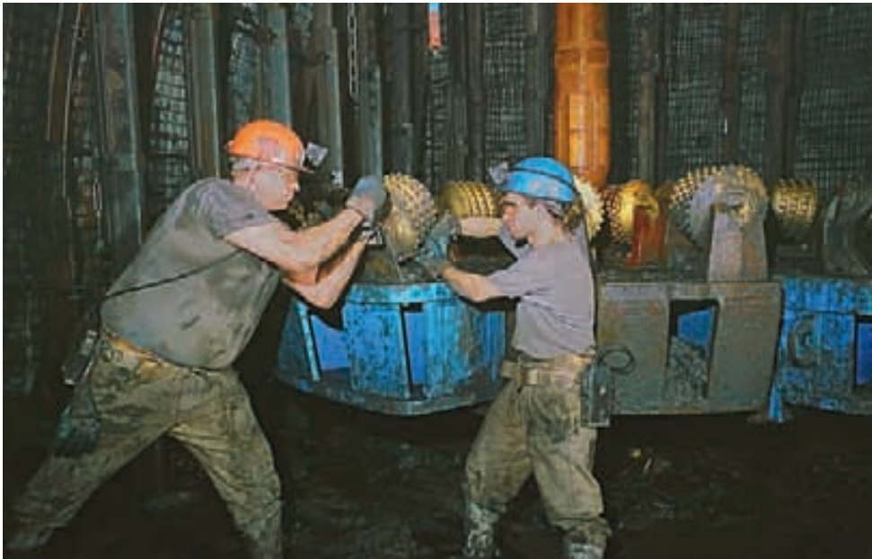
Montage des Raisebohrkopfes am Fuß des Blindschachtes
