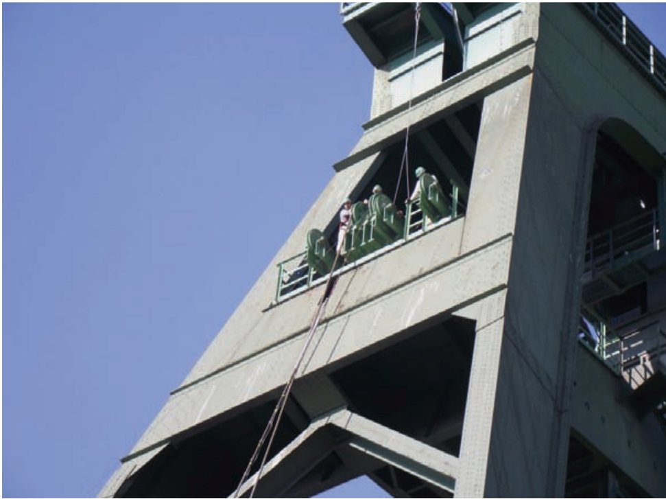
Seilauflegen Schacht K1
