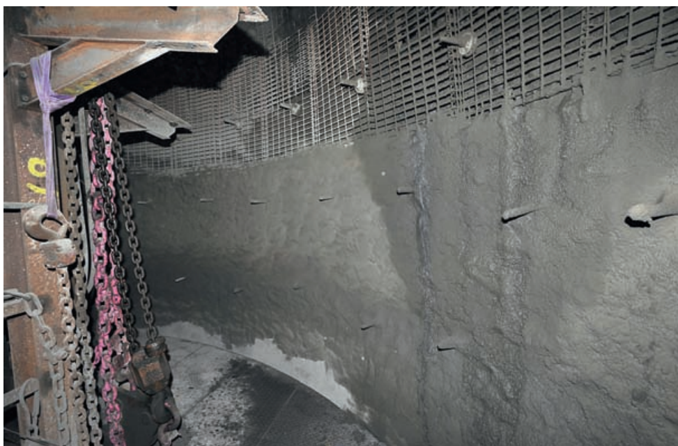
Anspritzarbeiten bei der ersten Bühnenfahrt von unten nach oben
