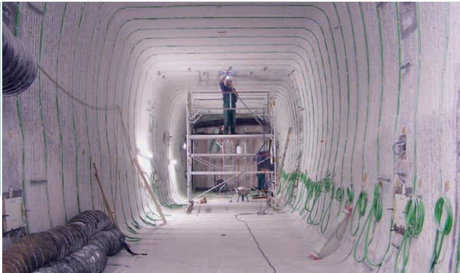
Einbau der Mess- und Injektionstechnik
