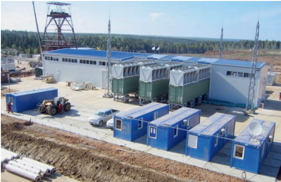
Blick auf die Gefrieranlage und auf das Teufgerüst von Schacht 1
