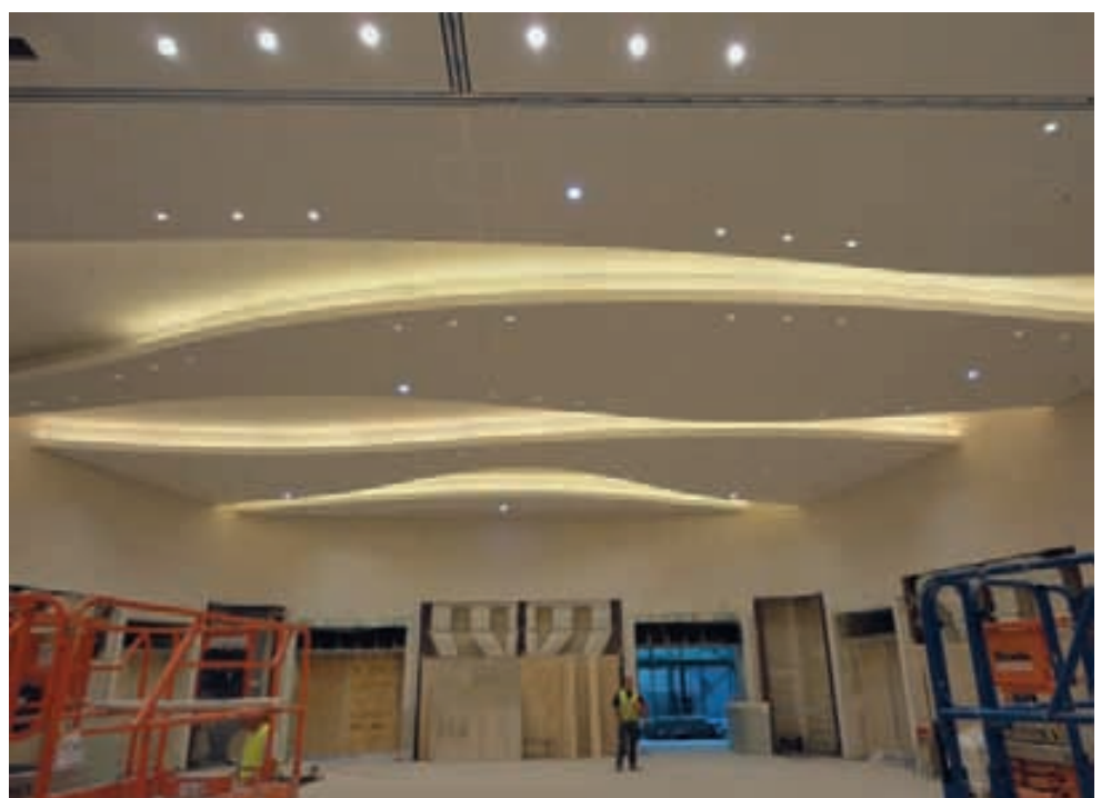
Fertiggestellte Ballsaaldecke im Hotel Hilton
