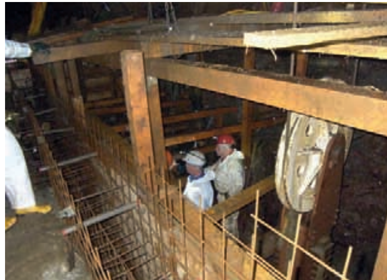
Schal- und Bewehrungsarbeiten im Schacht unterhalb des Flutungsniveaus
