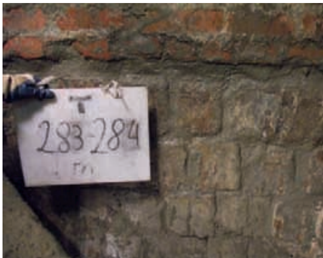
Gereinigtes und verfugtes Schachtmauerwerk
