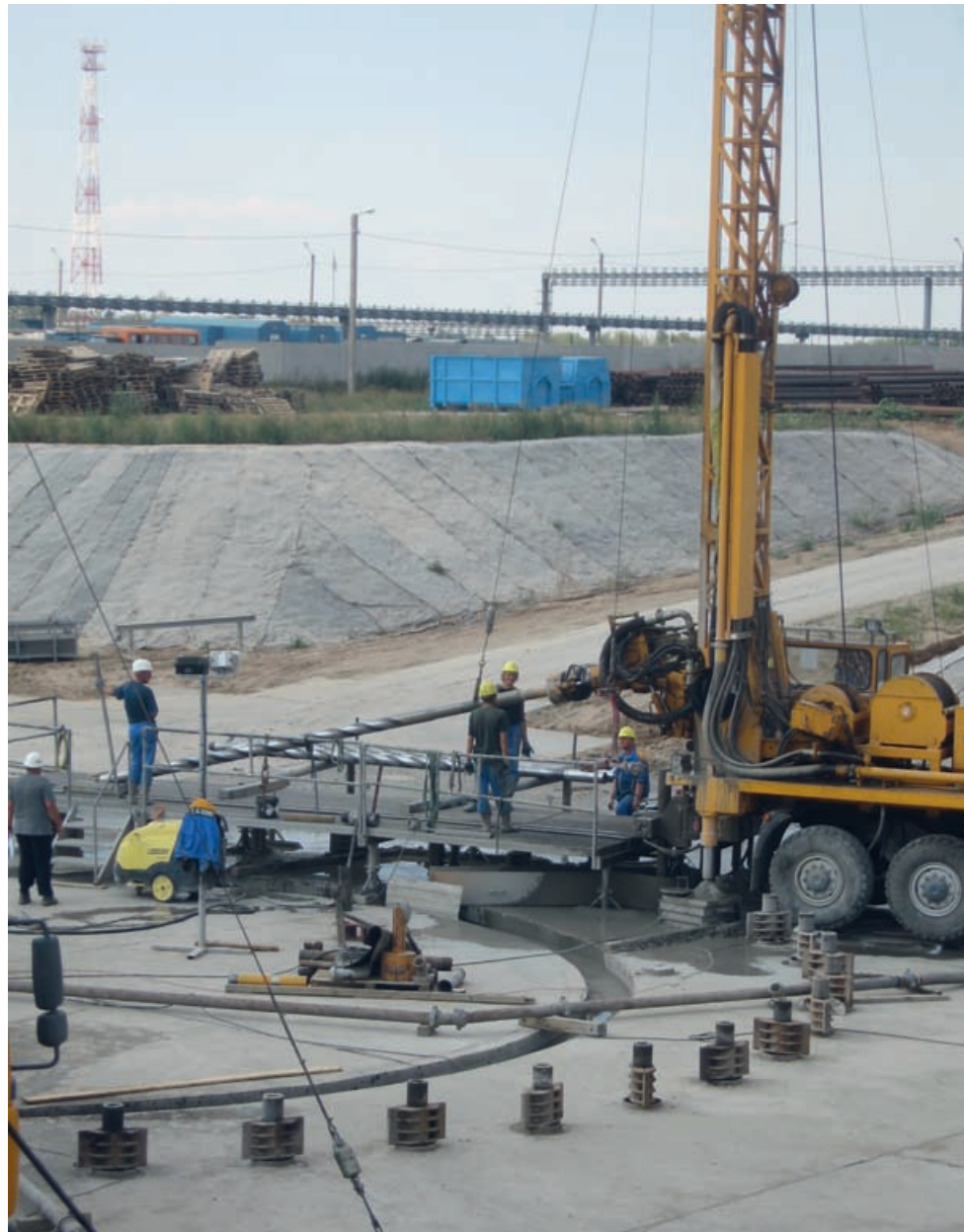
Herstellen der Gefrierbohrungen
