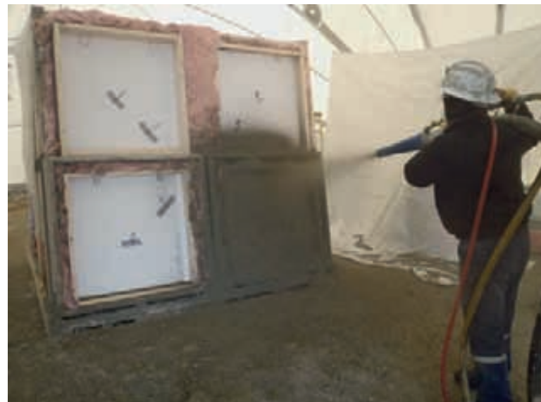
Testplatten zur Aufbringung von Spritzbeton
