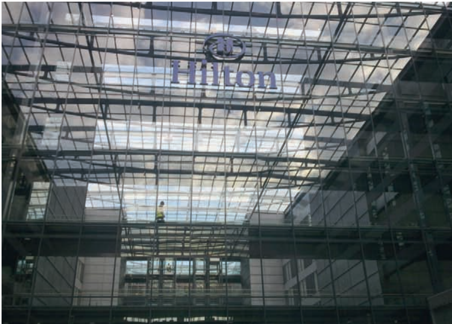
Eingangsbereich Hotel Hilton
