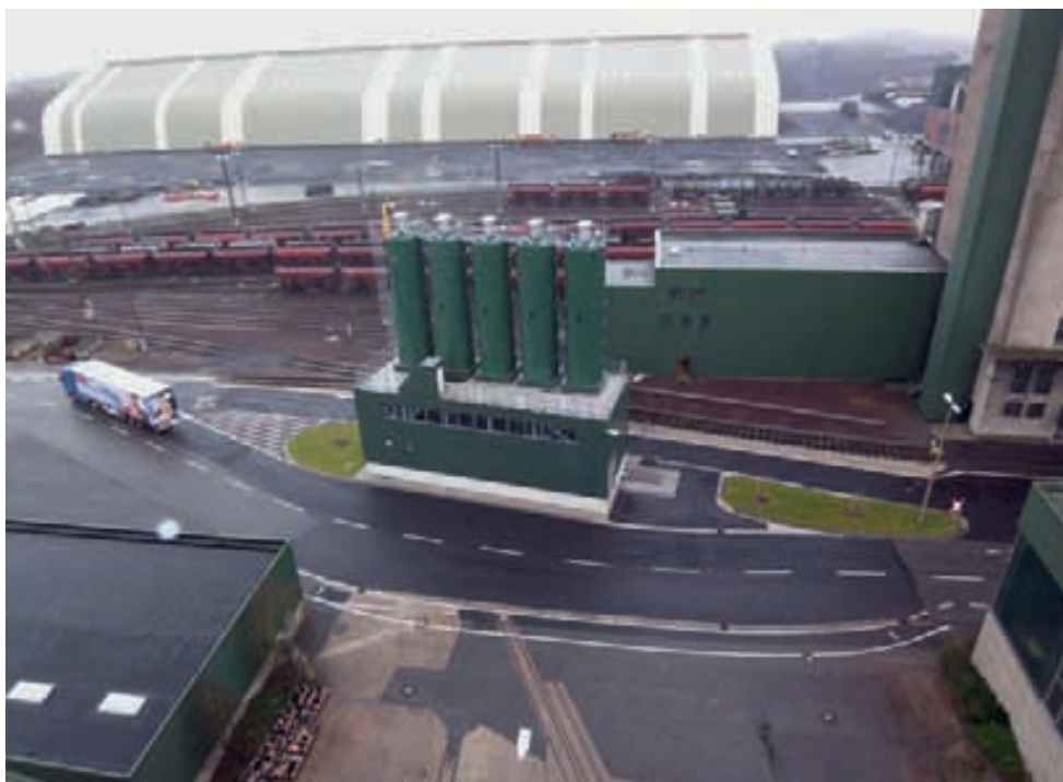
Baustoffanlage RAG Anthrazit Ibbenbüren GmbH
