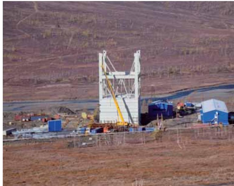
Der Schachtplatz im September 2009; von links nach rechts: Trägerstruktur für die 110 kV-Station, Teil des endgültigen Förderturms mit 45 m von 66 m endgültiger Höhe, 6 kV-Station, vorläufige Lüfterhalle, vorläufiges Sozialgebäude
