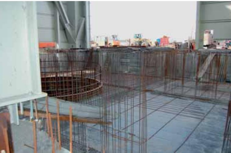
Vorbereitung von Betonierarbeiten für den Schachtkeller mit etwa 2.800 m<sup>3</sup> Beton parallel zur Errichtung des endgültigen Fördergerüsts
