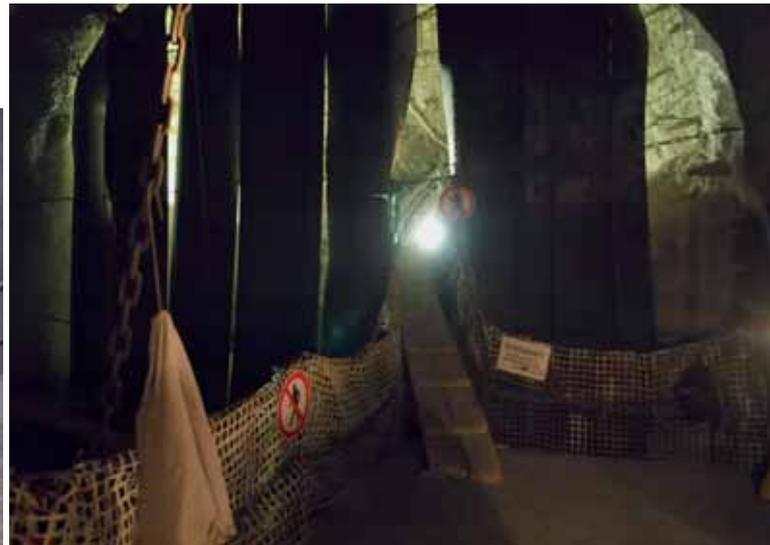
üblichen 30 m zurückgelassen werden. Mehrmals musste der Stahlbogenausbau mit Betonhinterfüllung, bedingt durch die Annäherung des Flözes Zollverein 4, bis zur Ortsbrust vorgeholt werden. Ebenfalls wurde die Anzahl der vor Ort einzubringenden Anker mehrmals erhöht und teilweise bis zu 4 m lange Anker eingebracht.
