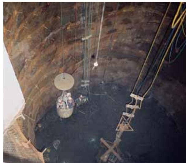
Oben: Teufarbeit im Bunker mit Reuse, Schrapperwinde und Befahrungskübel
