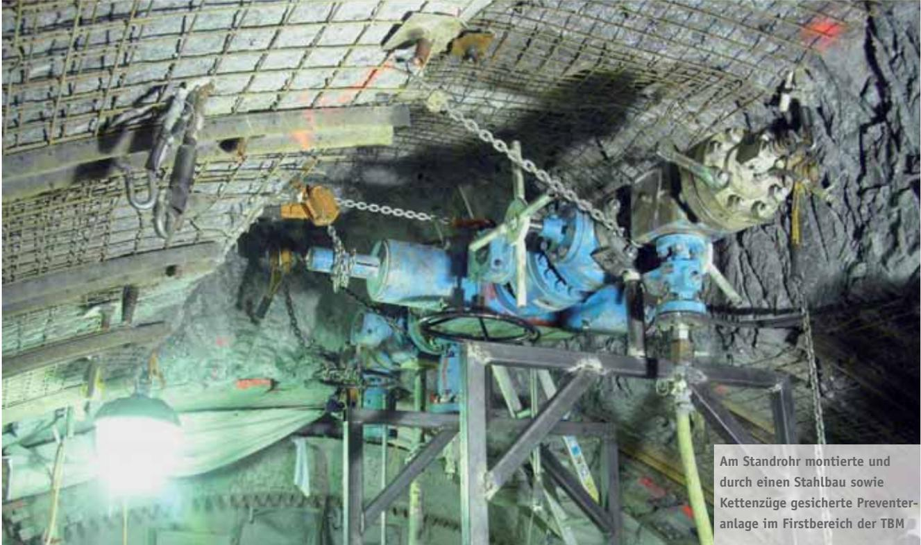
Am Standrohr montierte und durch einen Stahlbau sowie Kettenzüge gesicherte Preventeranlage im Firstbereich der TBM
