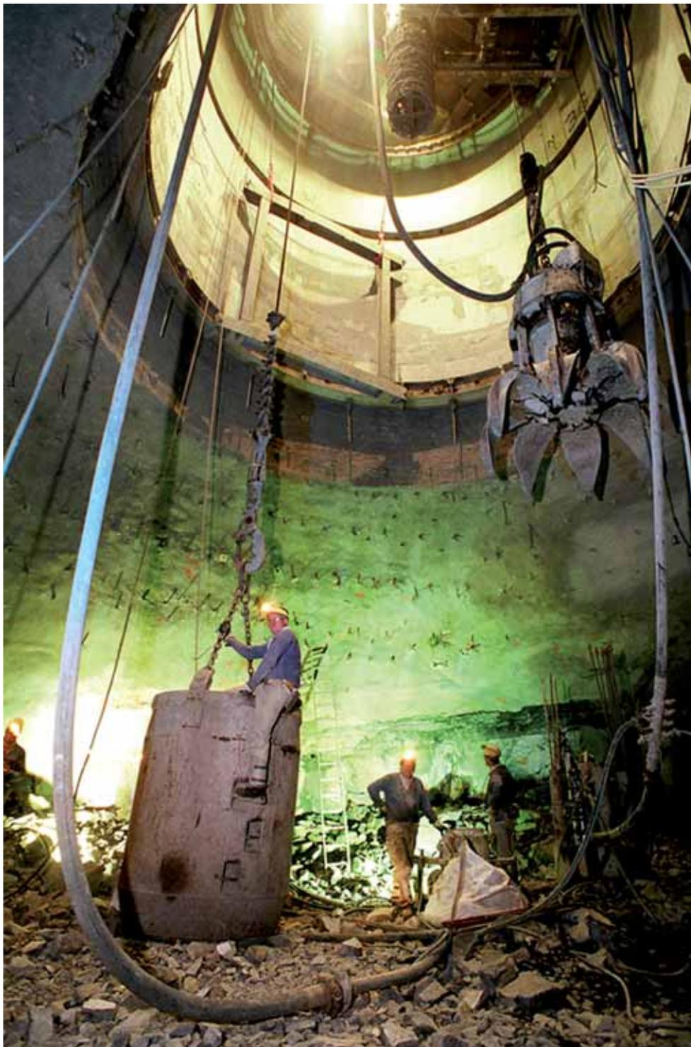
Vertikalübersicht im Bereich der 7. Sohle mit vorläufigem Ausbau und Blick in den Schacht
