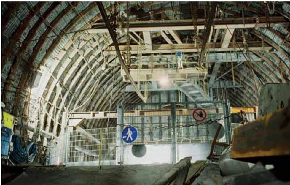
Teufeinrichtung am Bunkerkopf mit Seilscheibenverlagerung, Kübelwinde und Absturzsicherung
