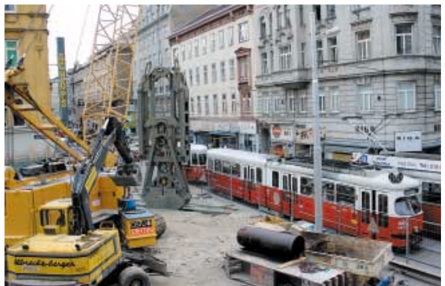
Abb. 2: SW-Herstellung Schacht Taborstraße
