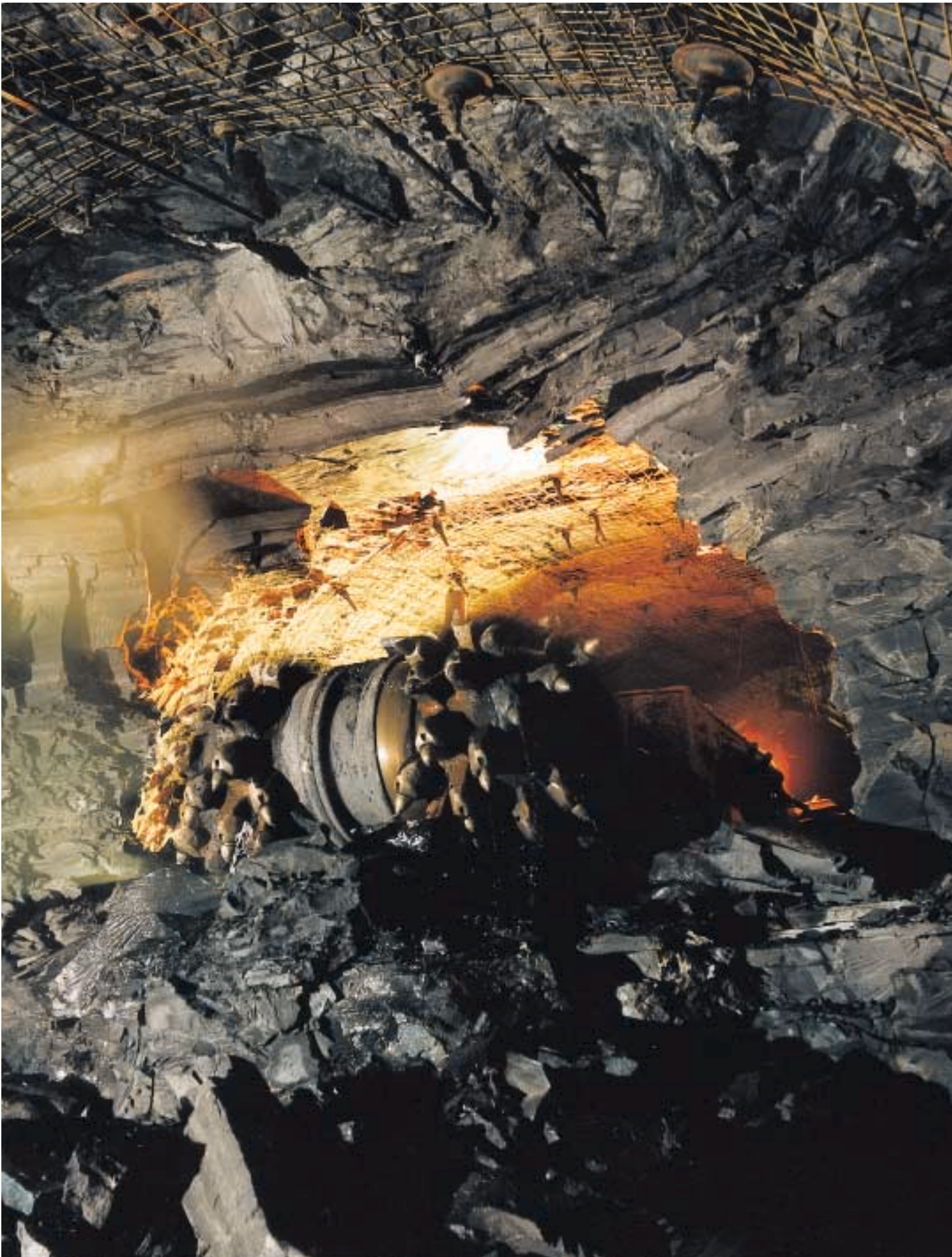
Durchschlag einer Teilschnittmaschine AM 85
