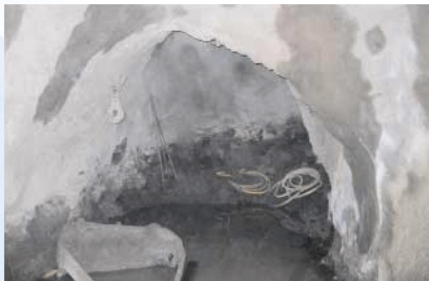
Herstellen des Füllortes, 175 m-Sohle
