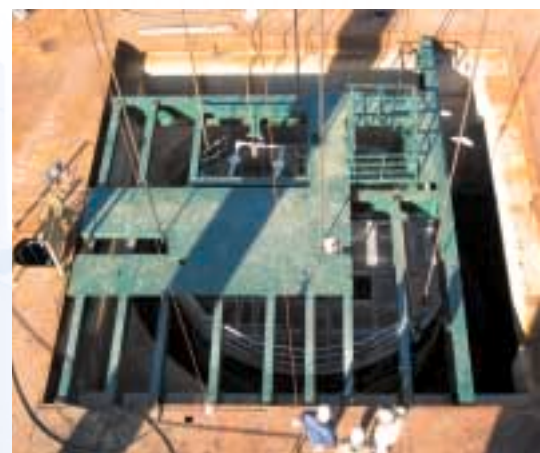
Montage der neuen Schachtabdeckung vom Kopf- schutzdach der 1-etagigen Arbeitsbühne
