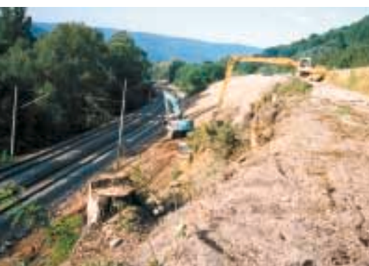
Maschinelle Böschungsarbeiten
