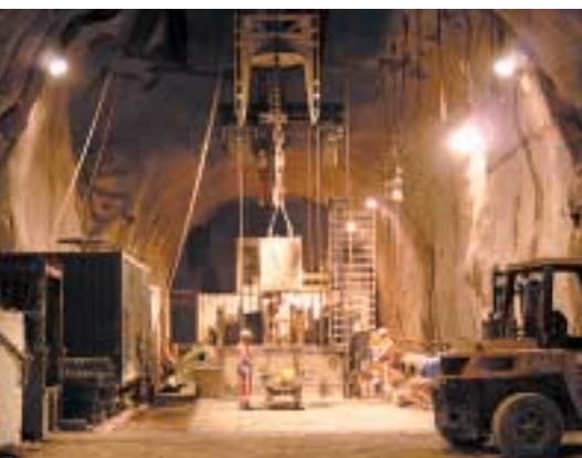
Sedrun Schacht II, Schachtkopf
