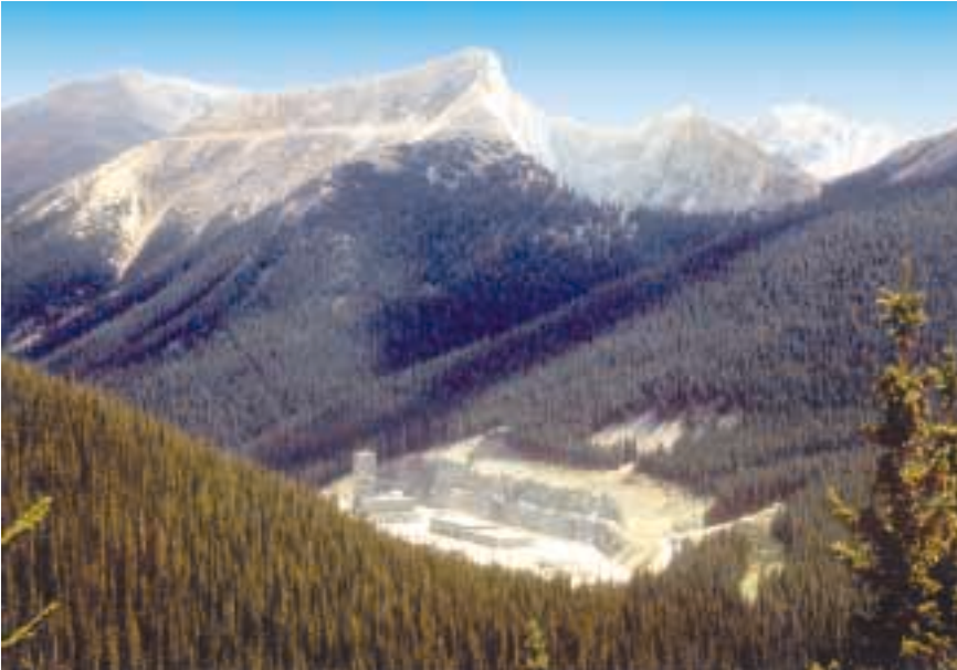
Luftaufnahme des Abbaus mit dem im Hintergrund sichtbaren, sich ausweitenden Bruchbau
