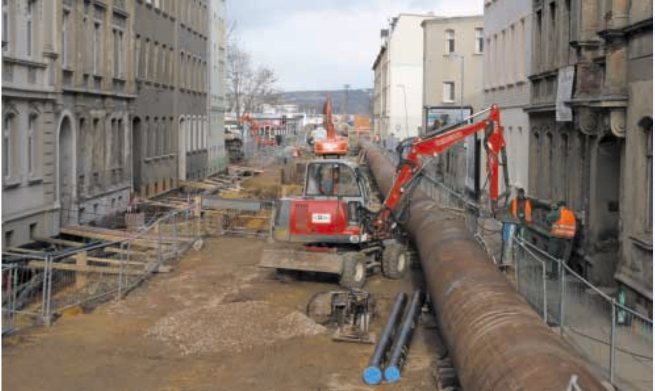
Vorbereitung für das Einbringen der Reliningrohre
