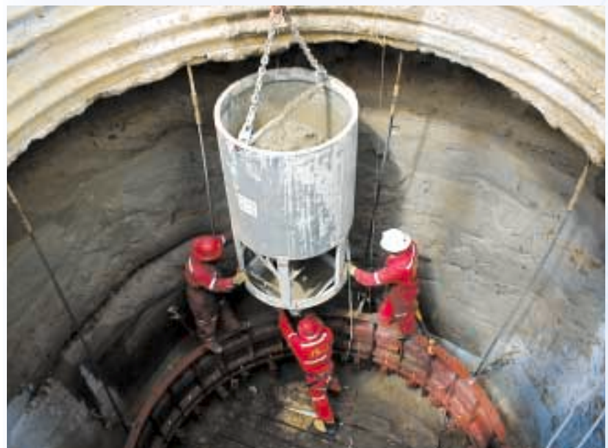
Betonieren des Schachtkragens
