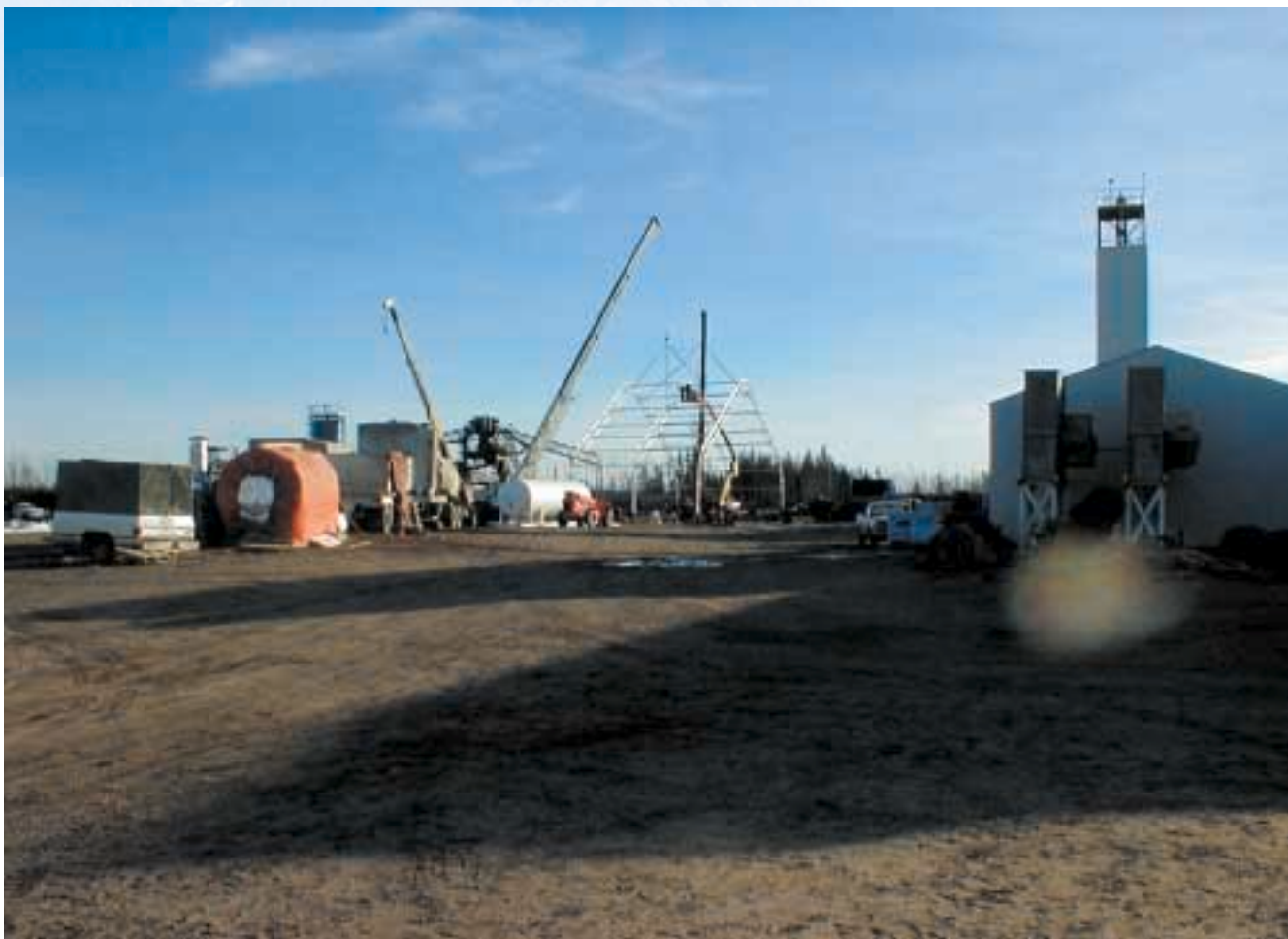
Ansicht der Einhäusung der gesamten DMS-Anlage
