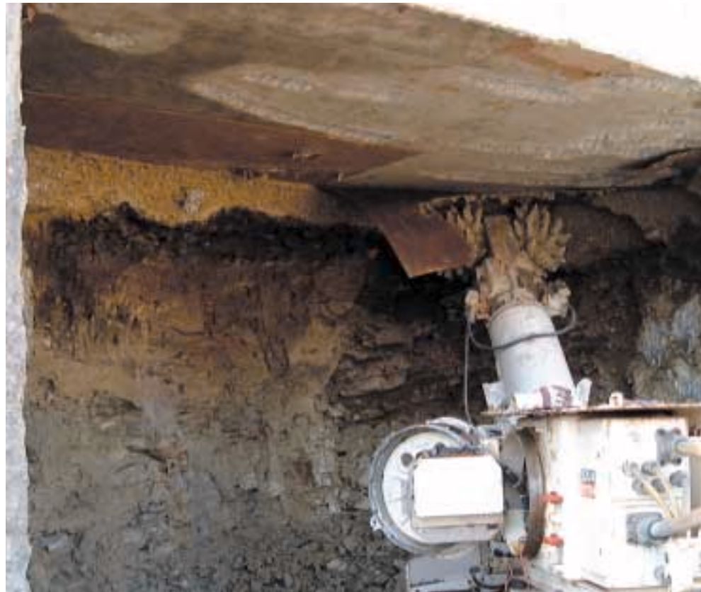
Der erste Tunnel Klosterneuburgs
