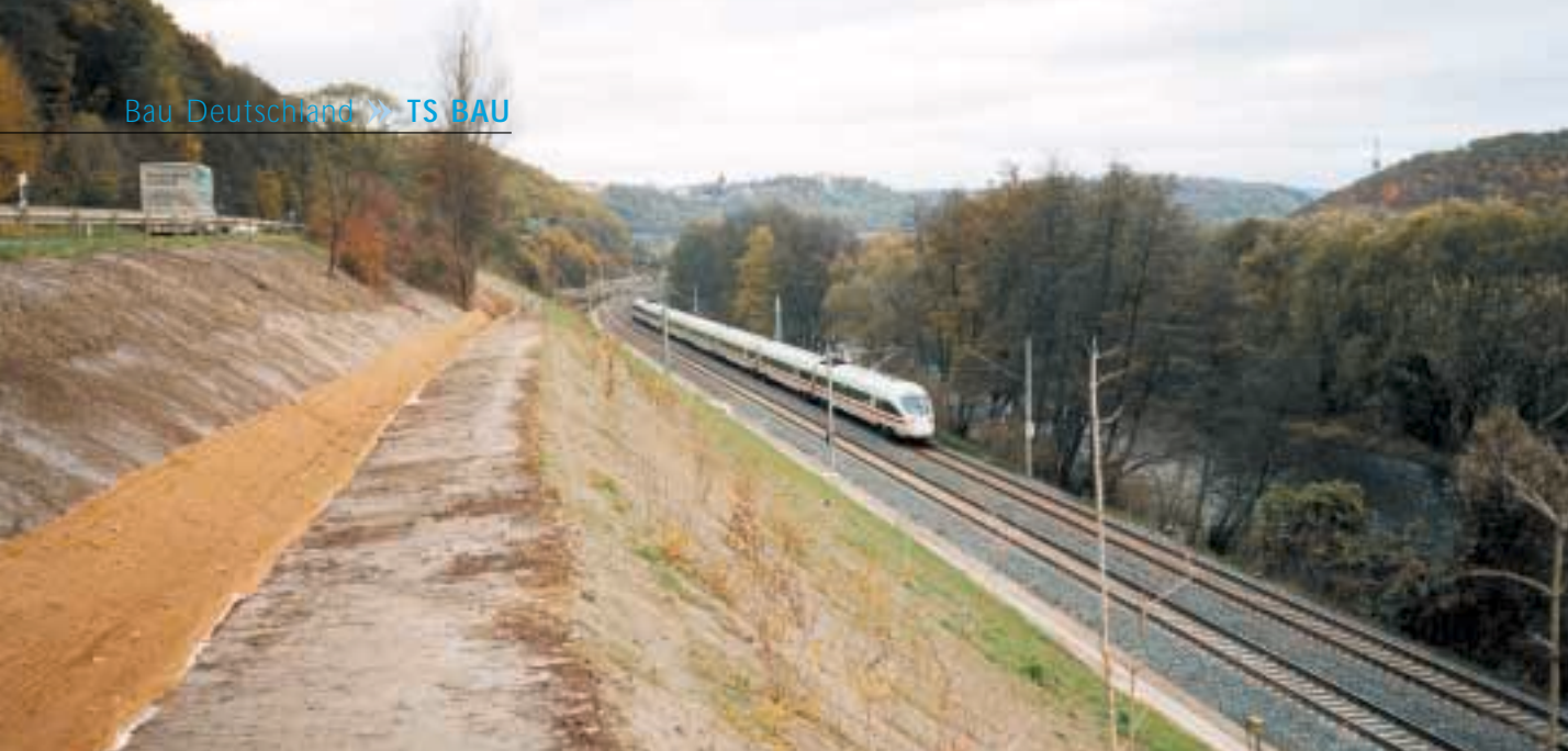
Fertiggestellte Böschung mit Bepflanzung
