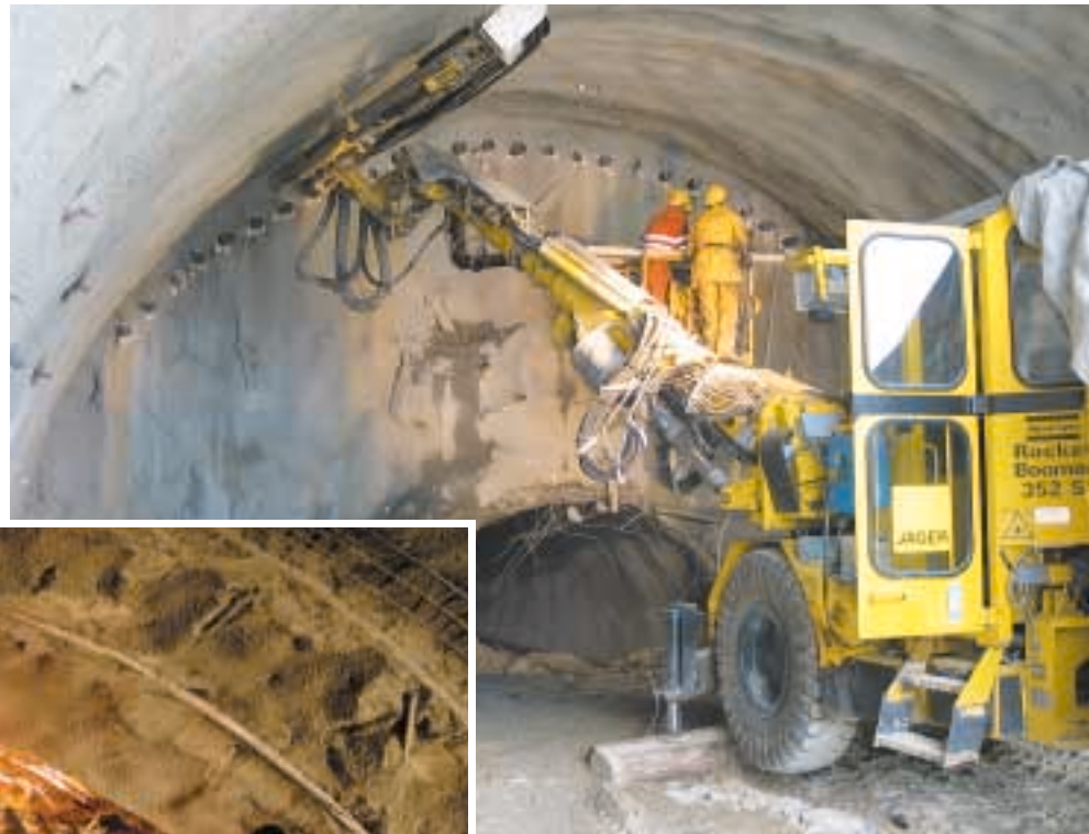
Bild oben: Bohren des Rohrschirms (Hangschuttstrecke)
