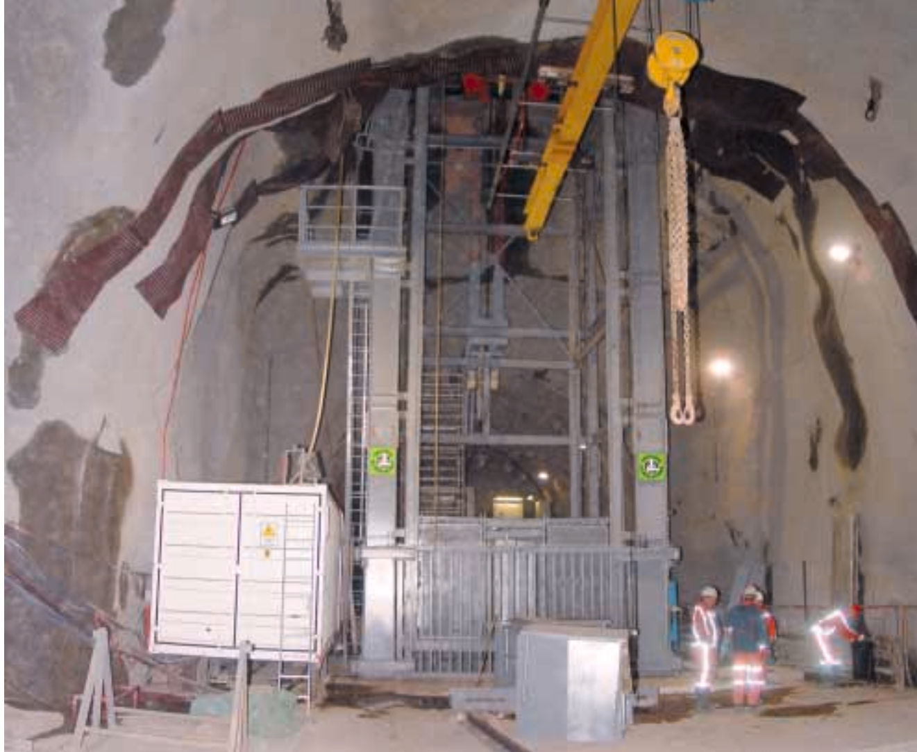
Führungsgerüst in der Kaverne
