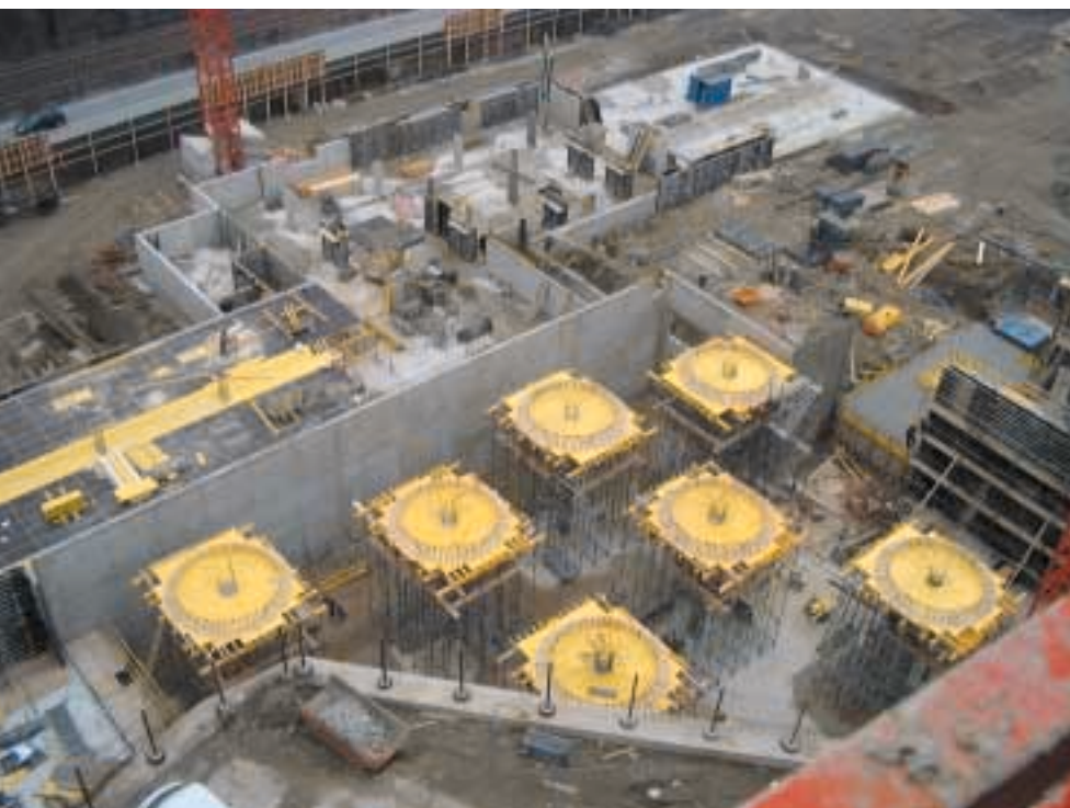
Deckenpilze im Heizlager
