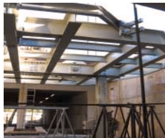
Bild unten: Montage des Kopf- schutzes der 1-etagigen Arbeitsbühne am Schachtkragen
