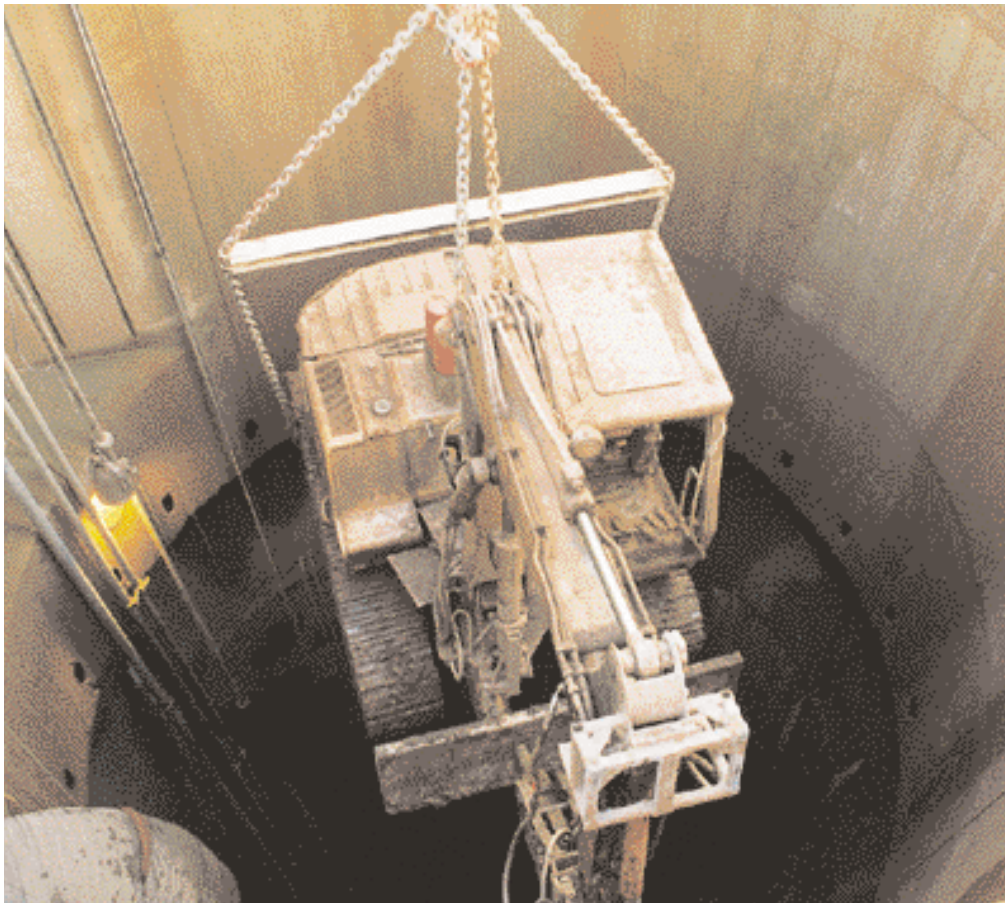
Der Bagger ist auf dem Weg zur Schachtsohle
