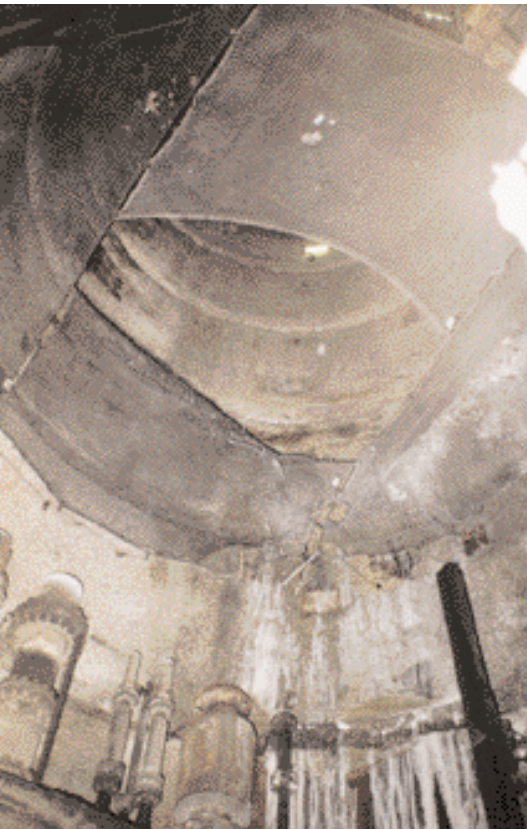
Mit dem Kopfschutznetz gesicherte Arbeitsstelle
