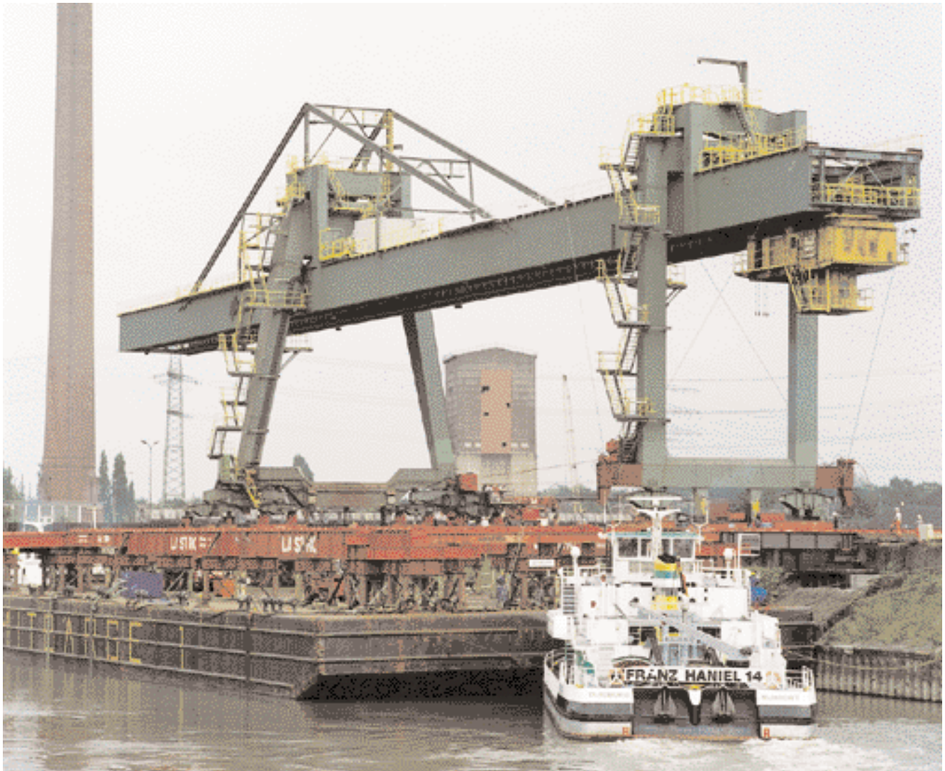
„Verschiffung“ der Verladebrücke
