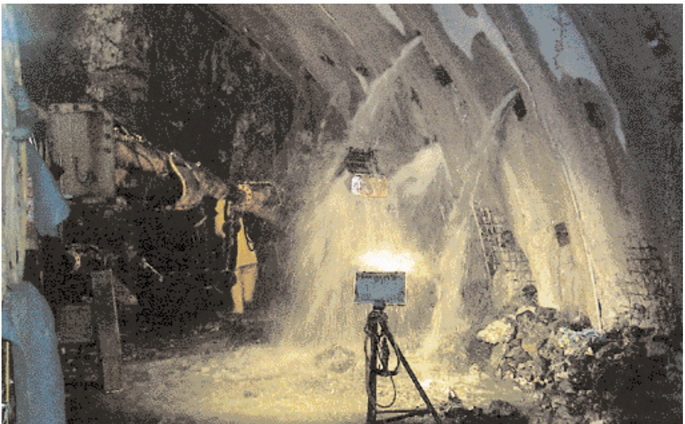
Wasseranfall im Kalottenvortrieb
