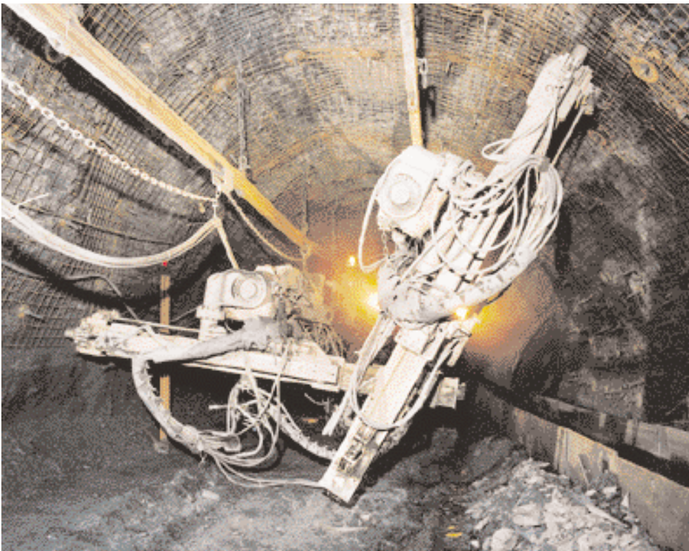
Zweiarmiger Bohrwagen für drehendes Bohren in Ankerstellung
