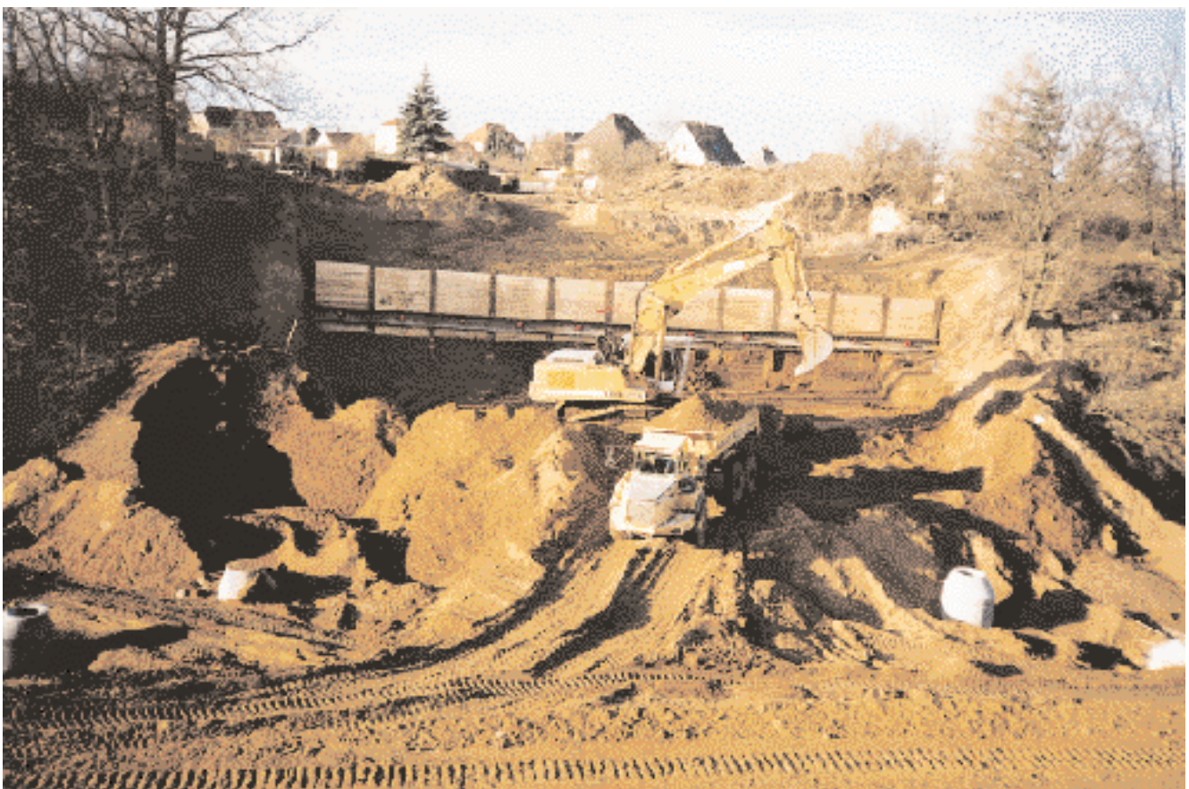
Erdarbeiten für Brückenbauwerk
