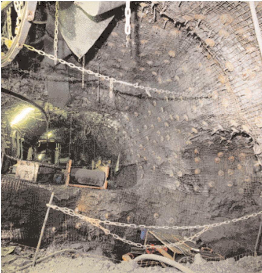
Bandgräben wurden erstellt, um ausreichende Höhe für die Bandübergaben zu schaffen
