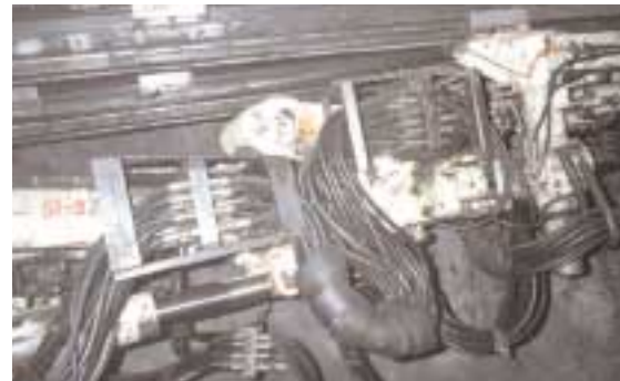
Schlauchanschlüsse an einem Jumbo
