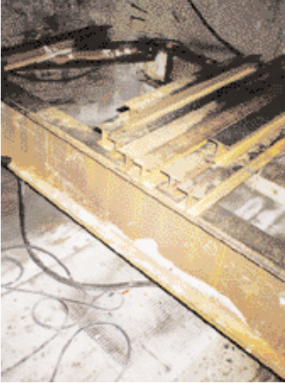
Trägerlage Schalungsbühne mit darunterliegender Arbeitsbühne
