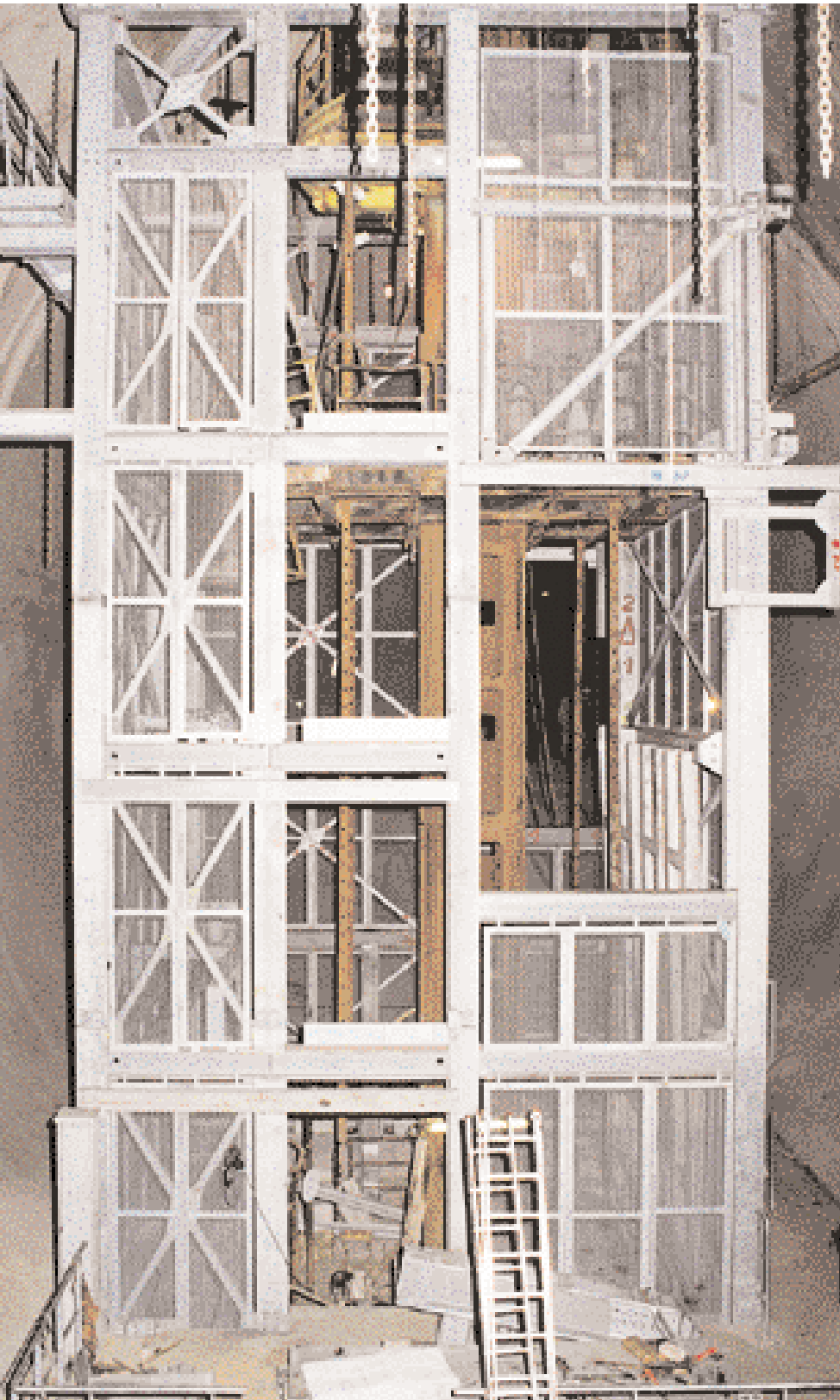
Der etwa 160 t schwere Schachtstuhl wird von der „Mega-Bühne“ aus montiert
