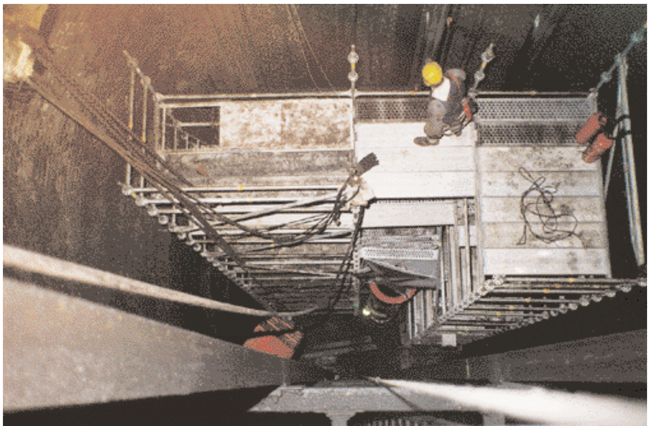
Aufgebautes Baugerüst
