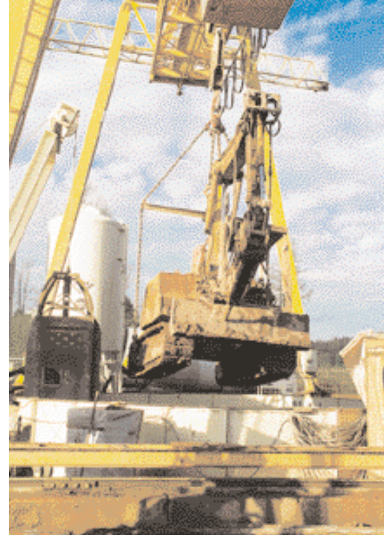
Der 10 t schwere Bagger kann beliebig in den Vorschacht und heraus gefördert werden
