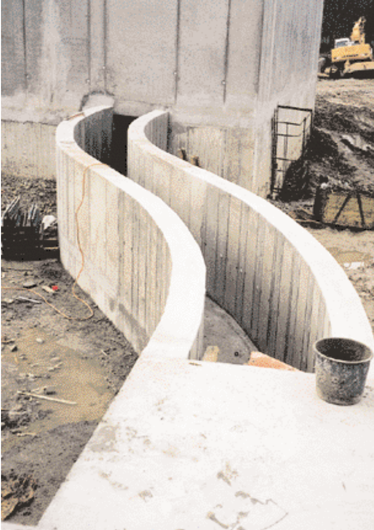
Ausleitung aus dem Rechenhaus
