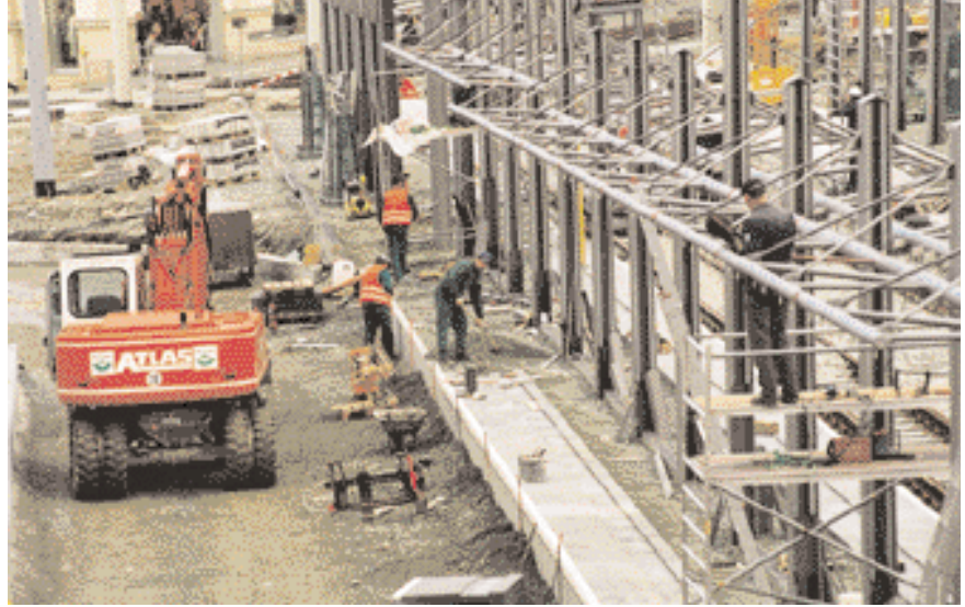
Haltestellenbereich mit teilfertiger Überdachungskonstruktion
