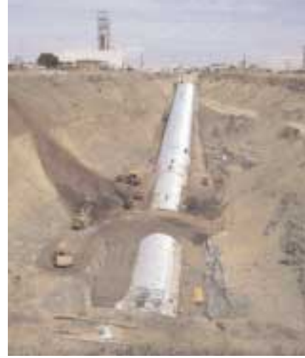
Offene Bauweise im nicht standfesten Teil des Deckgebirges
