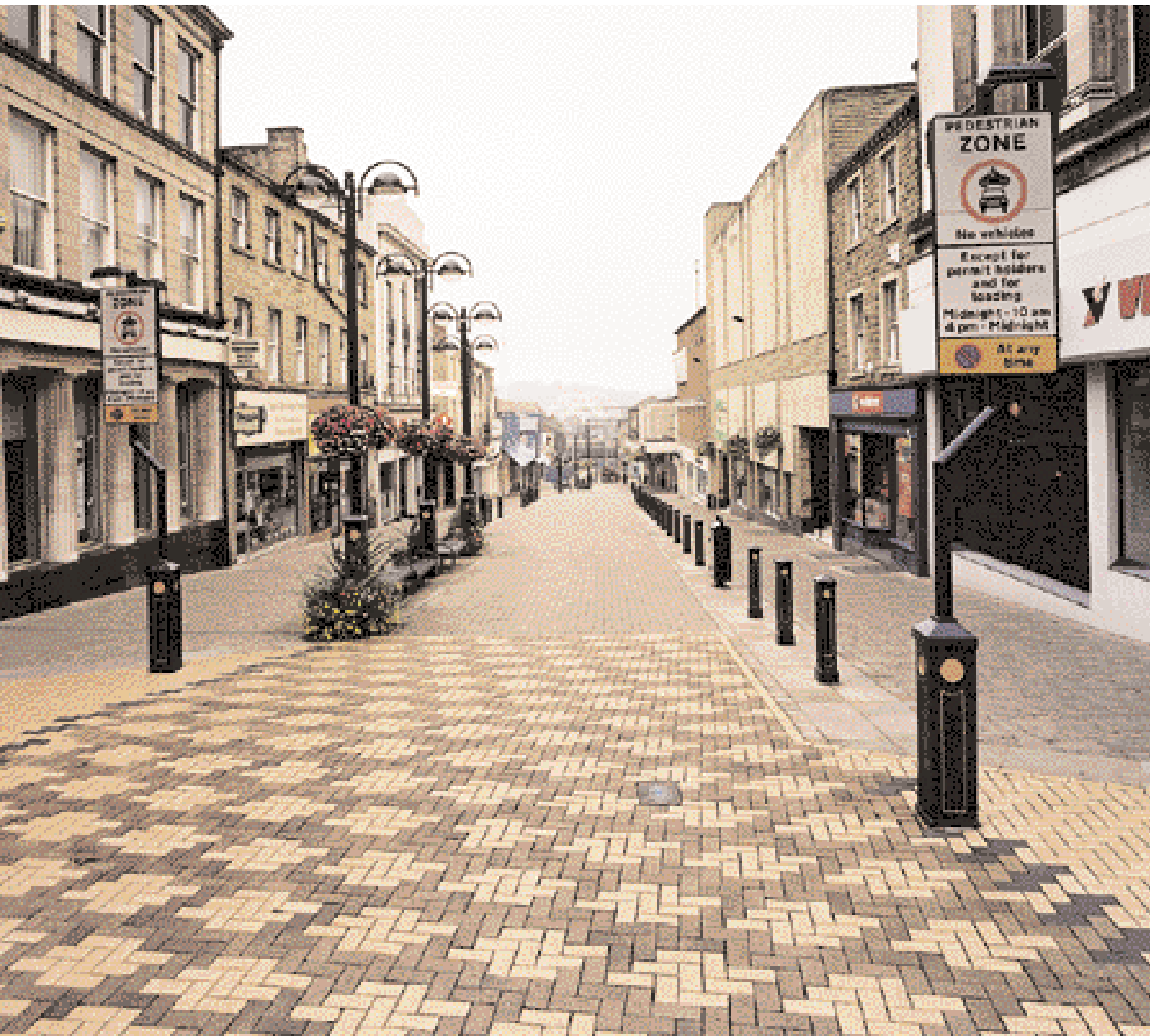
Steinpflasterung und Themenbeleuchtung in der Fußgängerzone
