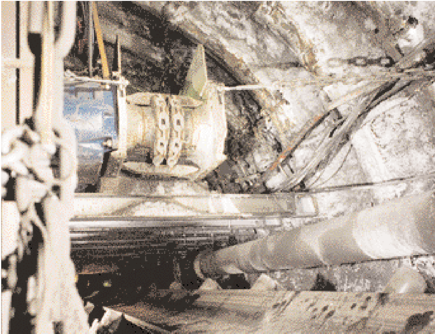
Auf der 5. Sohle werden die Ausbruchberge von einem Kettenkratzförderer auf die Großbandanlage aufgegeben
