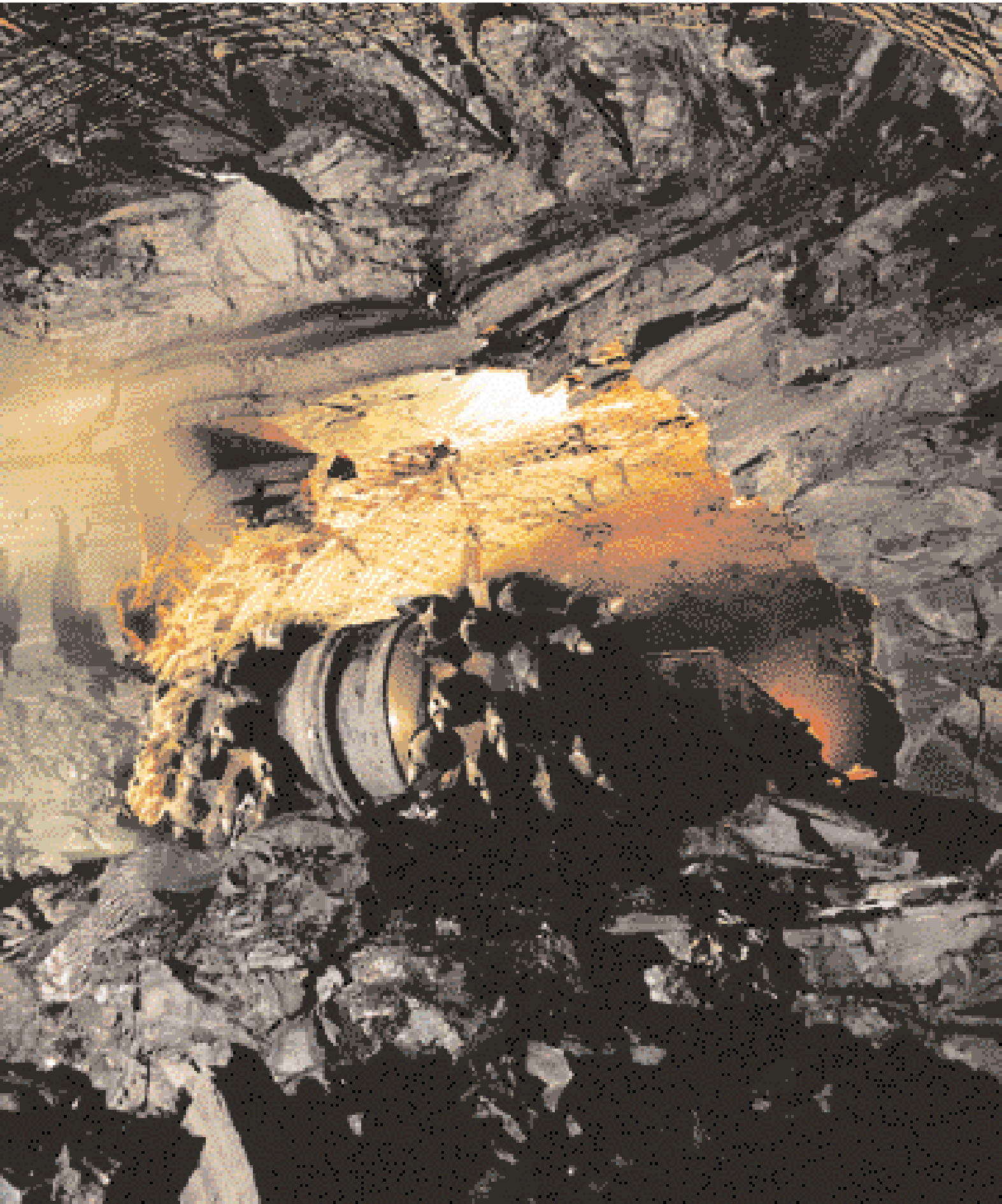
Durchschlag der TSM AM 85 in der Kopfstrecke 4641
