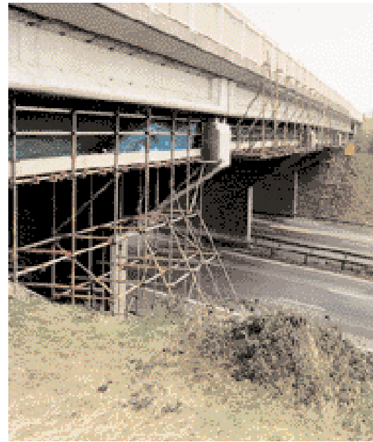
Einrüstung zur Ausführung der Brückenverstärkungs- und Brüstungsarbeiten
