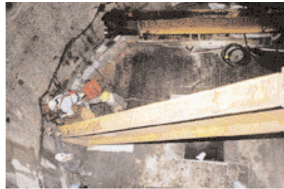
Einbau der Hauptträger der Schalungsbühne
