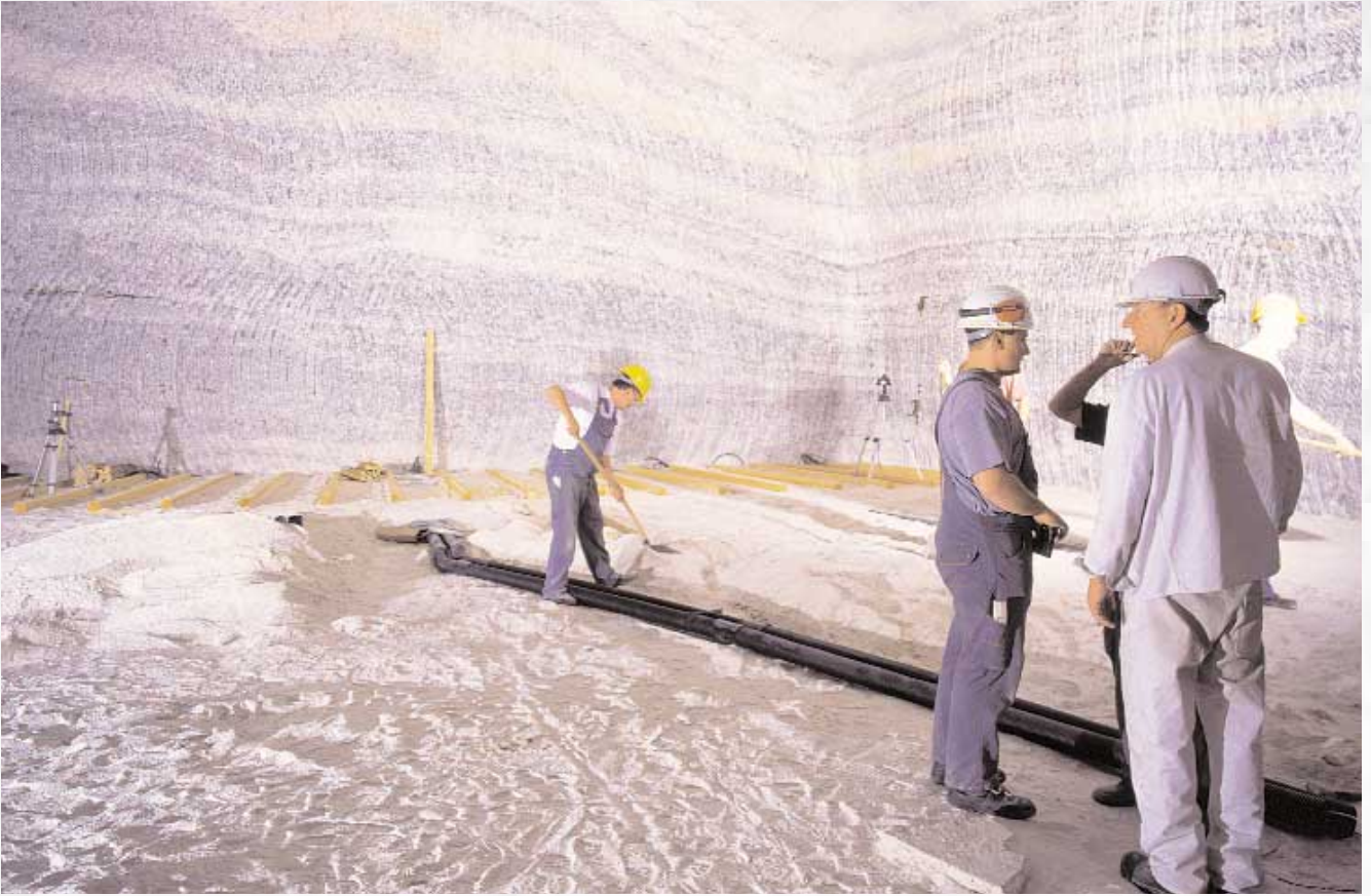
Bergmännisch fertiggestellter Konzertsaal, Elektriker beim Verlegen der elektrischen Einrichtungen
