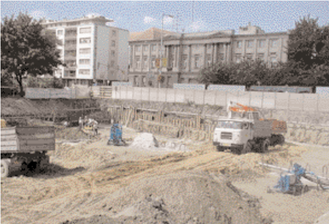
Erdarbeiten für das Fundament
