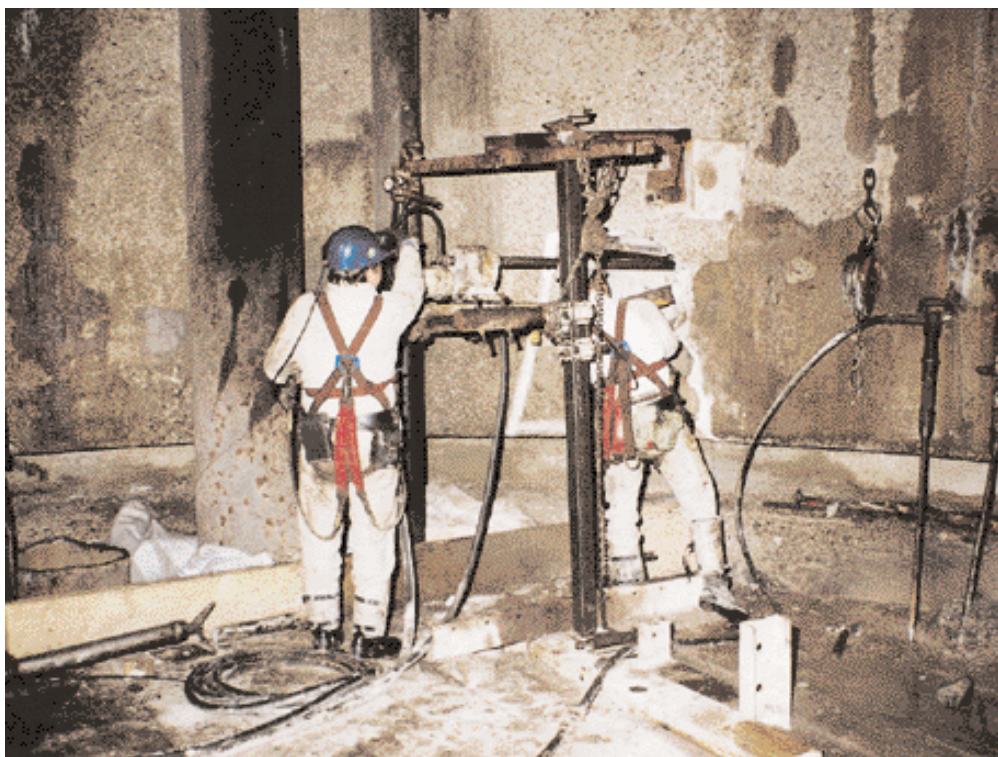
Erstellung der Aussparungen mittels Kernbohrmaschine
