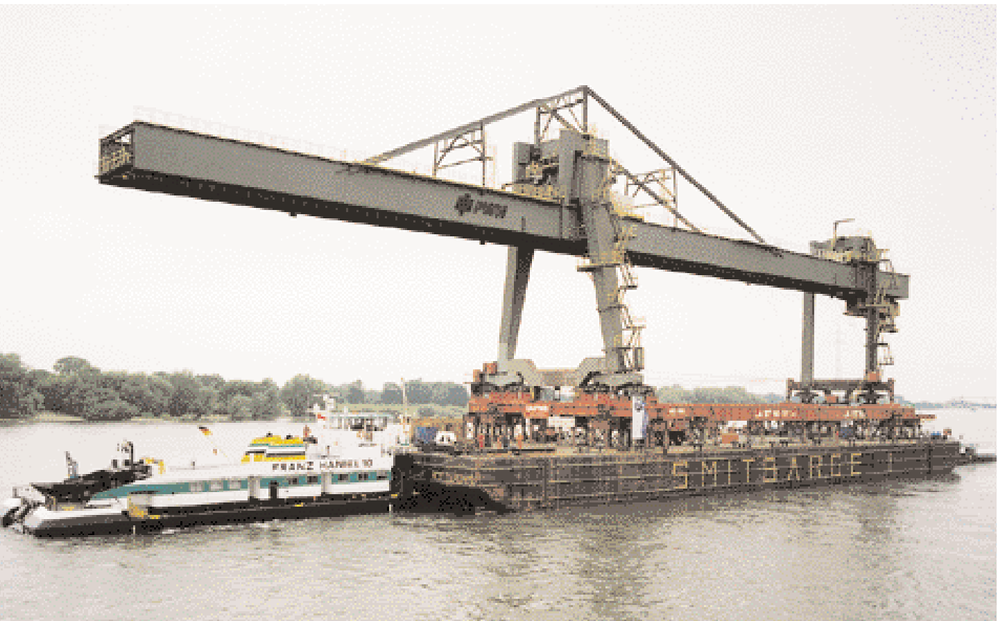
Eine Verladebrücke auf Reisen
