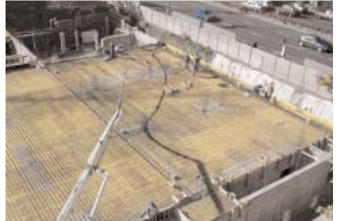
Betonierung der Kellerdecke
