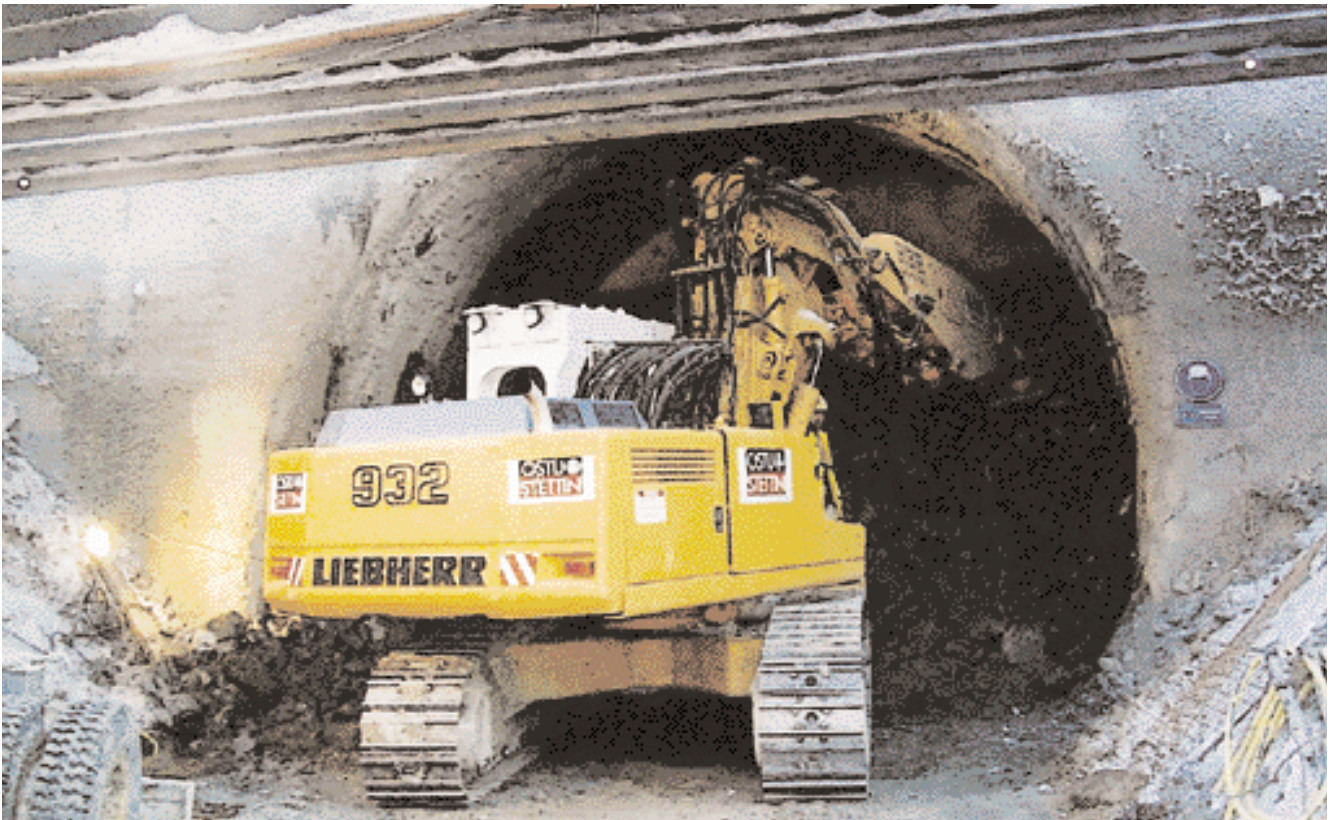
Bagger am Portal des Zufahrtstunnels unter bestehender Bahntrasse
