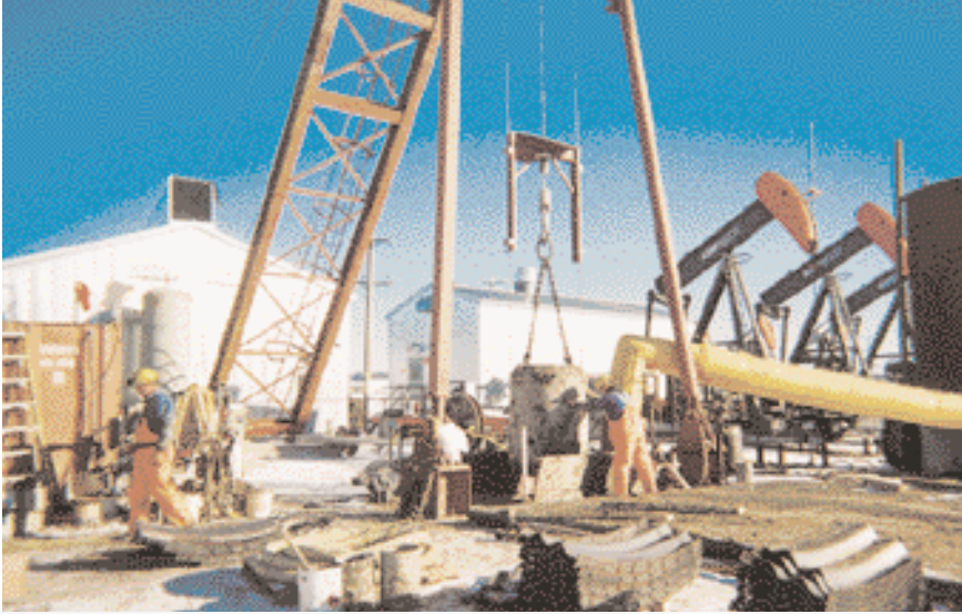
Das Fördergerüst wird in die richtige Position gehoben
