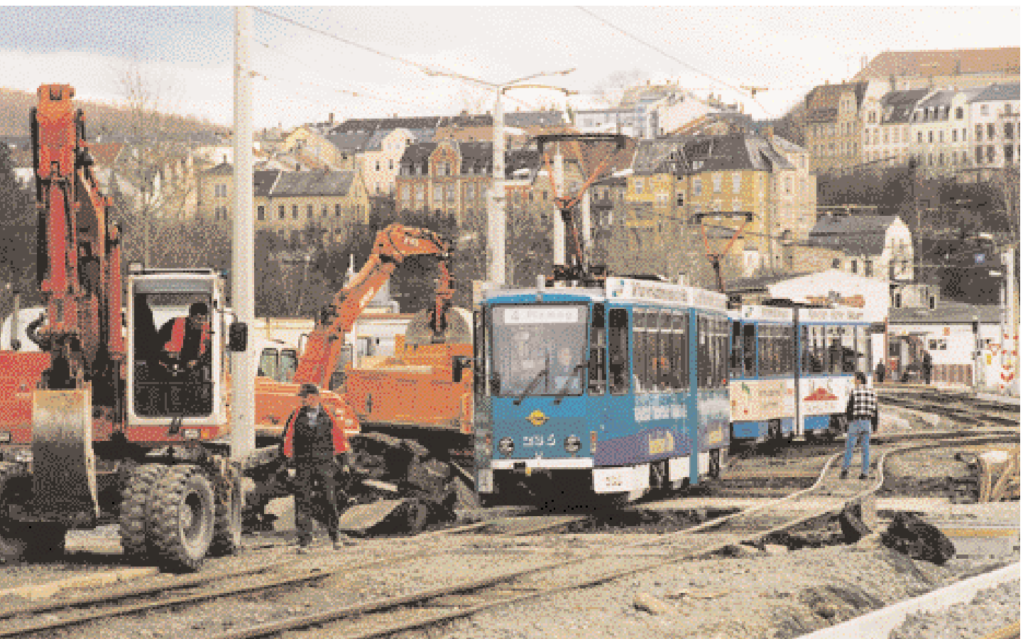
Enge Baustellenverhältnisse unter Aufrechterhaltung des Straßenbahn-Betriebs
