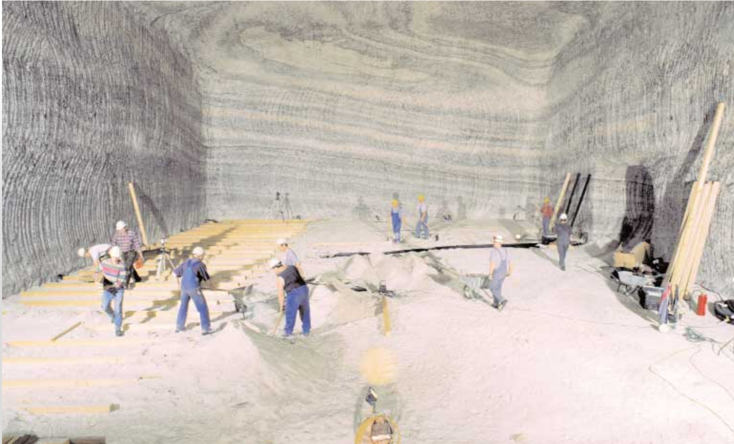
Bergmännisch fertiggestellter Konzertsaal, Handwerker beim Verlegen des Holzfußbodens
