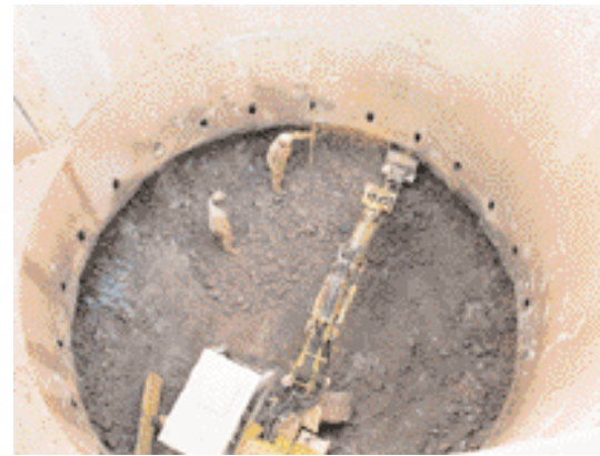
Das Teufen beginnt unterhalb des Schachtkragens
