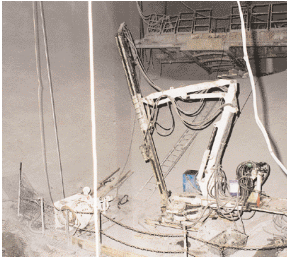
Zum Erstellen der Sprengbohrlöcher kommt ein einarmiges Schachtbohrgerät zum Einsatz
