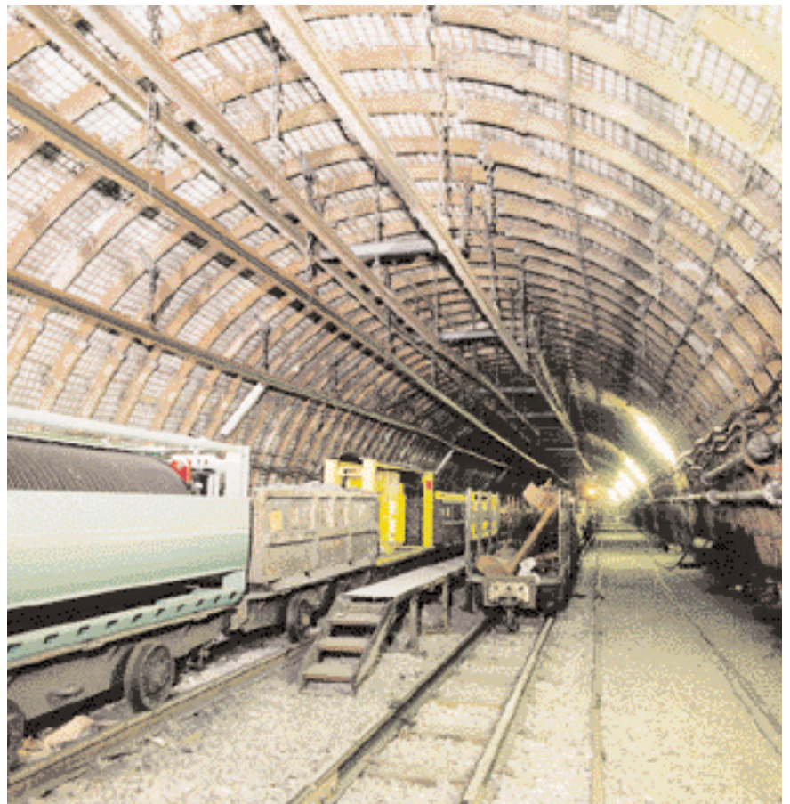
Bahnhof 0521, Materialumschlagplatz für das Baufeld 07, aufgefahren durch Thyssen Schachtbau
