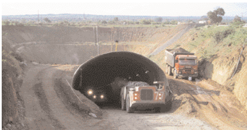
Mundloch der im Teufen befindlichen Rampe
