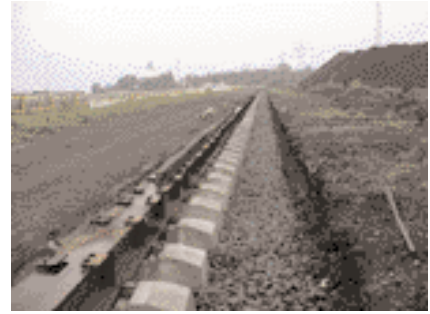
Der neue Gleiskörper der Verladebrücke
