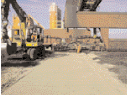
Erstellung der Verschieberampen
