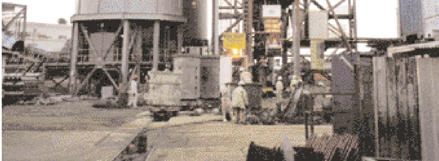
Schachtgerüst mit Erzbunker
