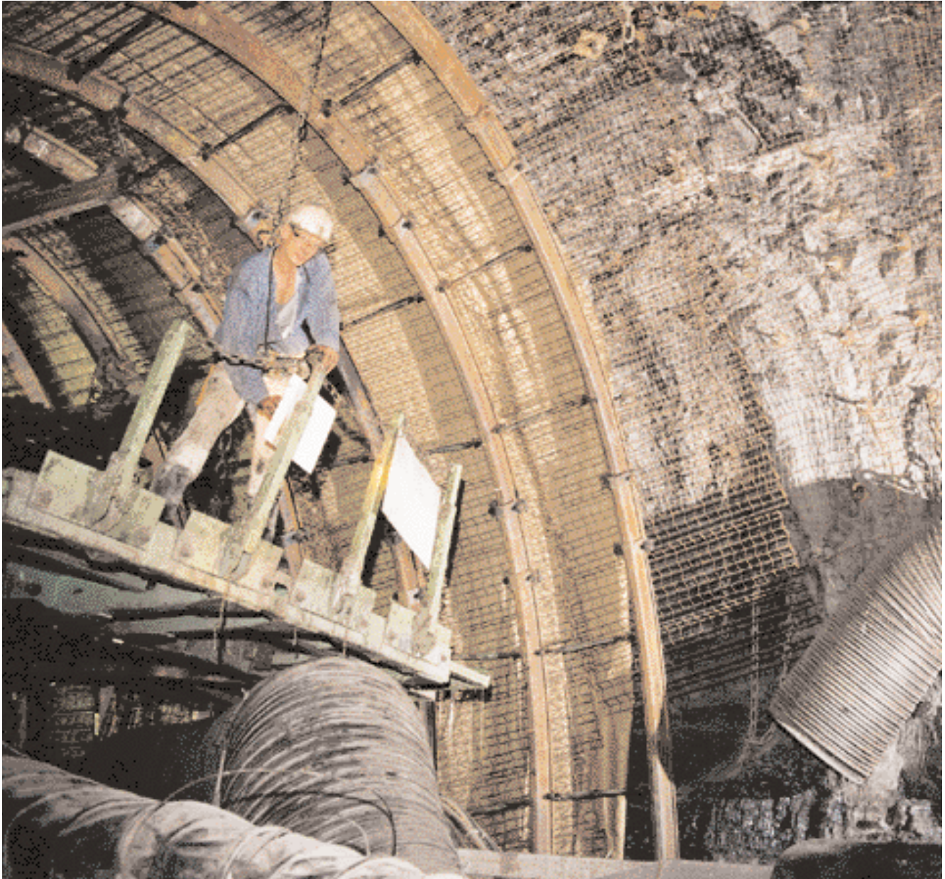
Der Unterstützungsausbau wird ca. 25 – 30 m hinter der Ortsbrust eingebracht
