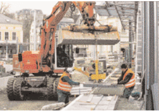
Einbringen des Bahnsteiges
