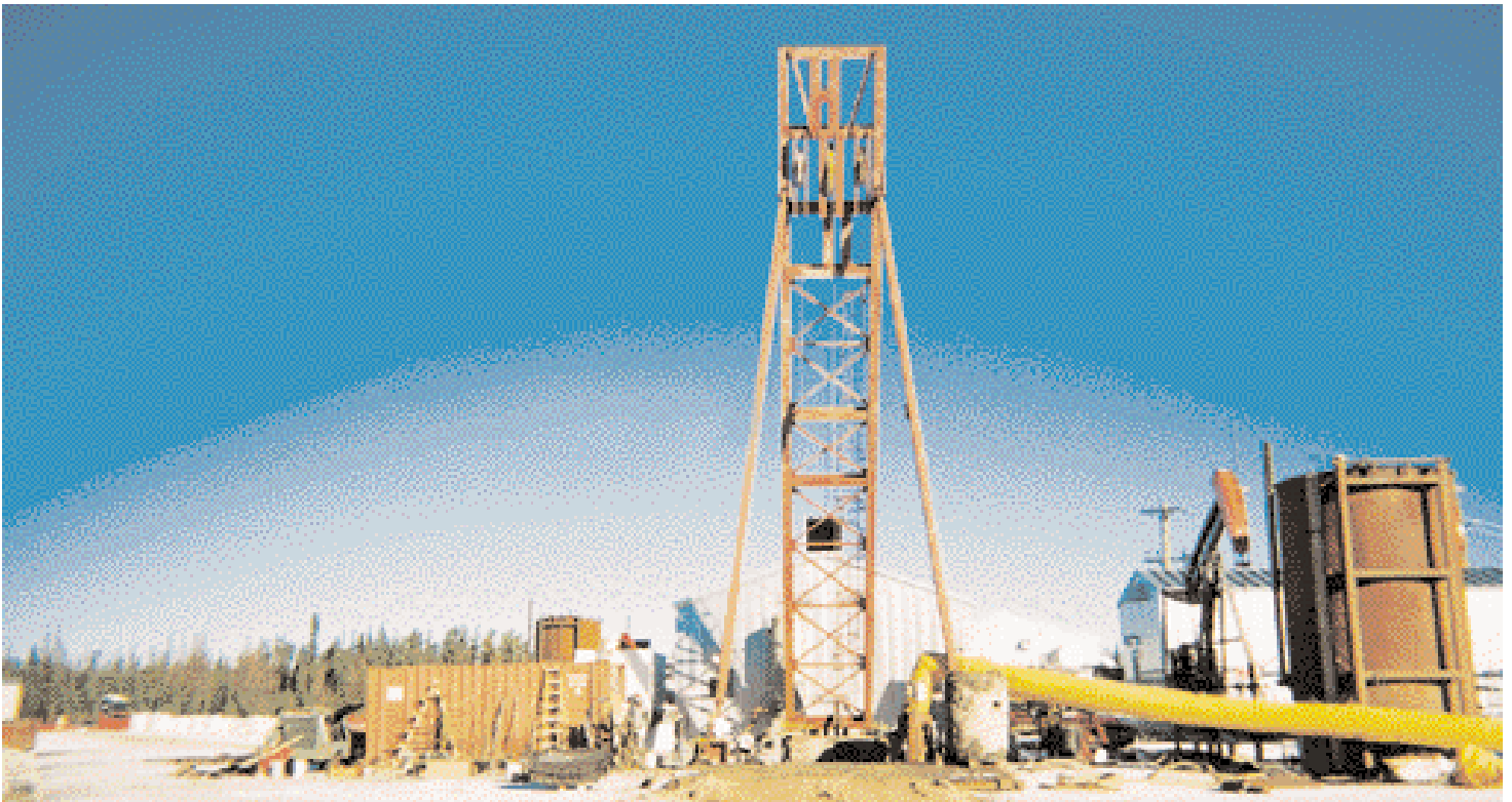
Baustellenanordnung mit Greifereinrichtung und Pumpen im Hintergrund
