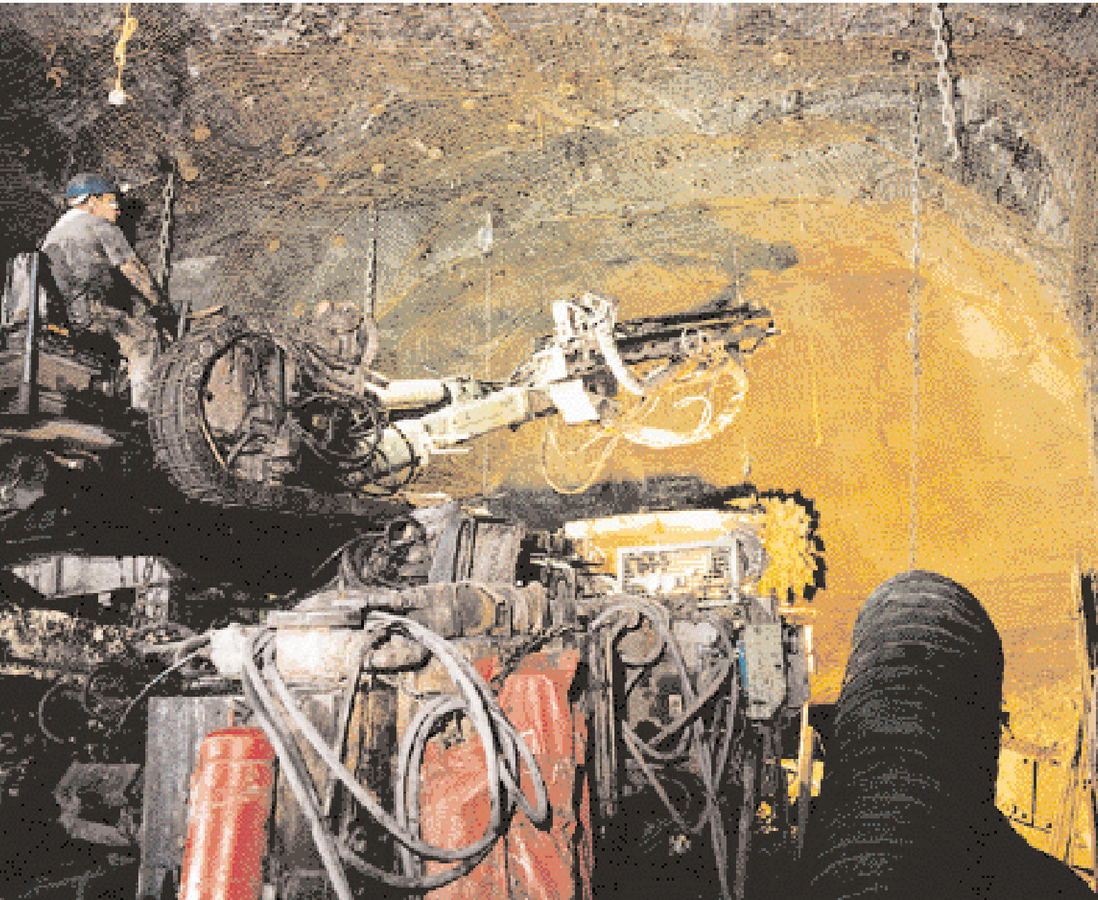
Vollankerung vor Ort
