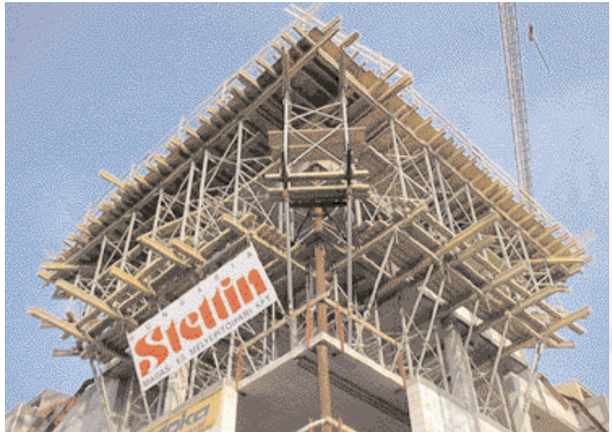
Schalung des Hauptgesimses
