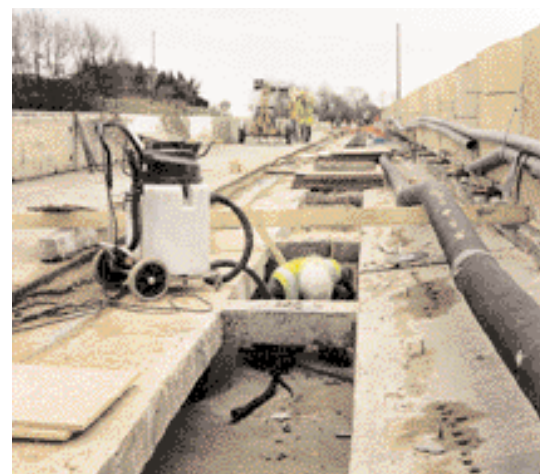
Brüstungsverstärkung auf der Pleasley Lane Brücke
