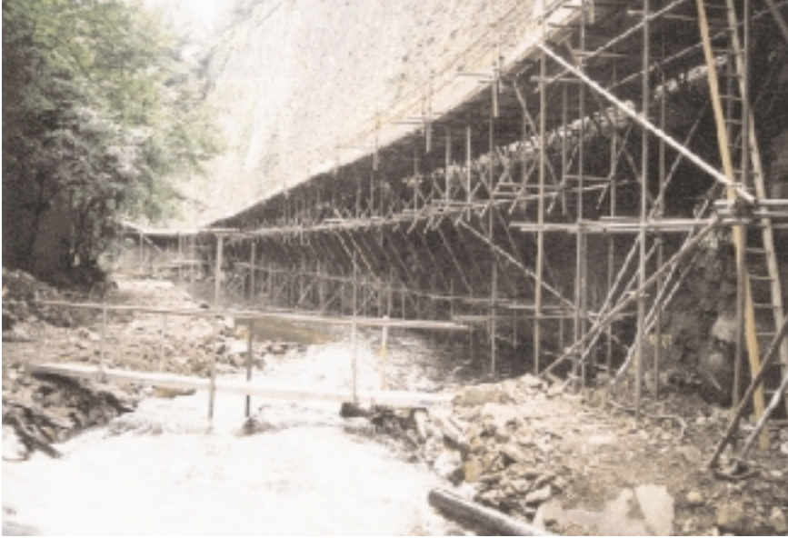
Komplizierter vorübergehender Baustellenzugang
