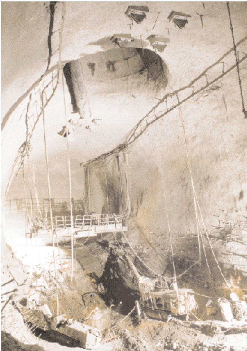
Auffahrung Scheibe 5, Einsatz von Arbeitsbühne, Lader und Bohrwagen
