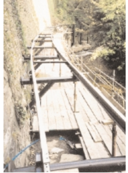
Anbringung der Stahlträger
