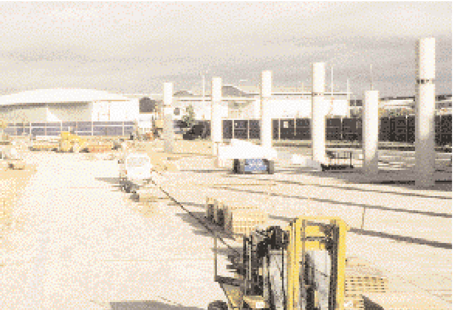
Panorama-Ansicht vom Einbau des Eichendecks
