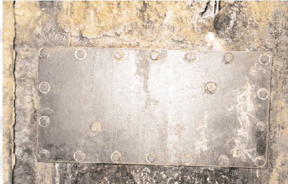
Abb. 2: Montierte Vorbaukassette
