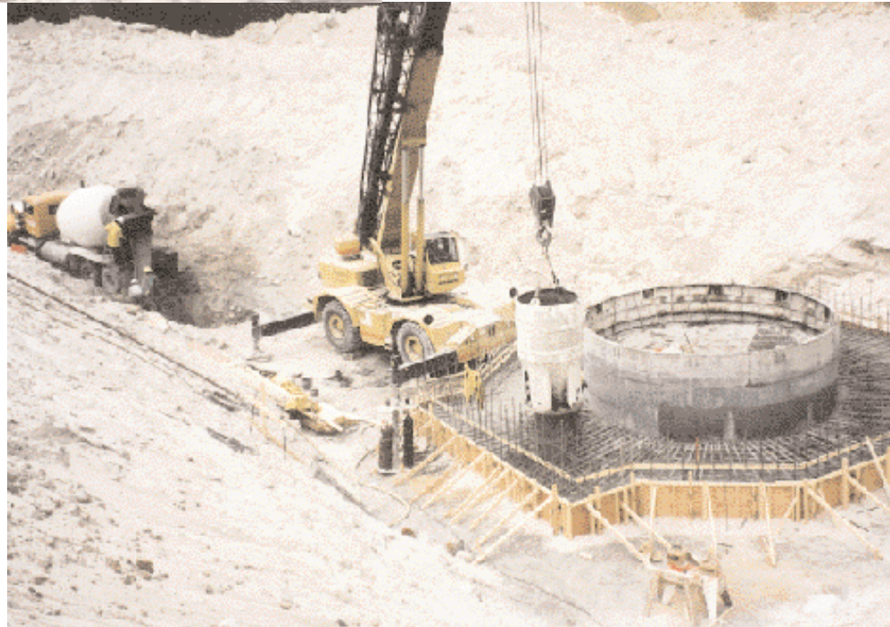
Bild unten: Betonieren des unteren Teils des Schachtkragens
