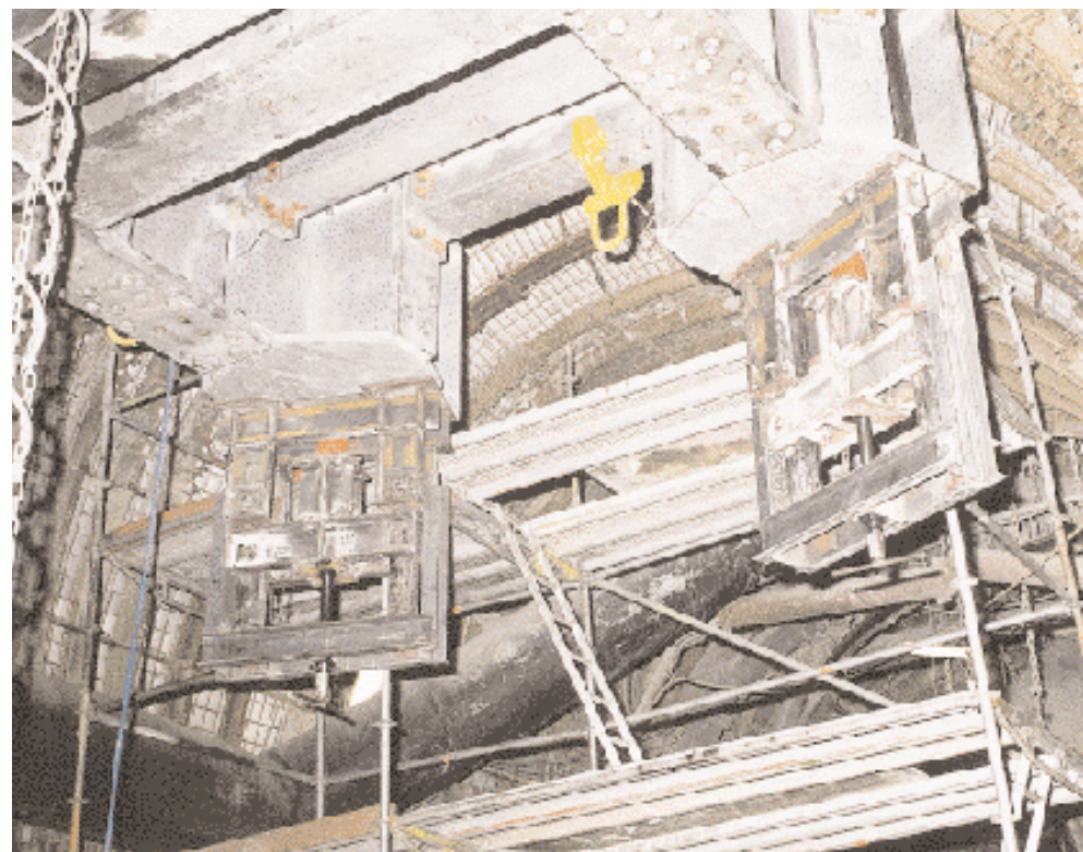
Bild 8: ... und werden schwebend an die Hydraulikheber übergeben
