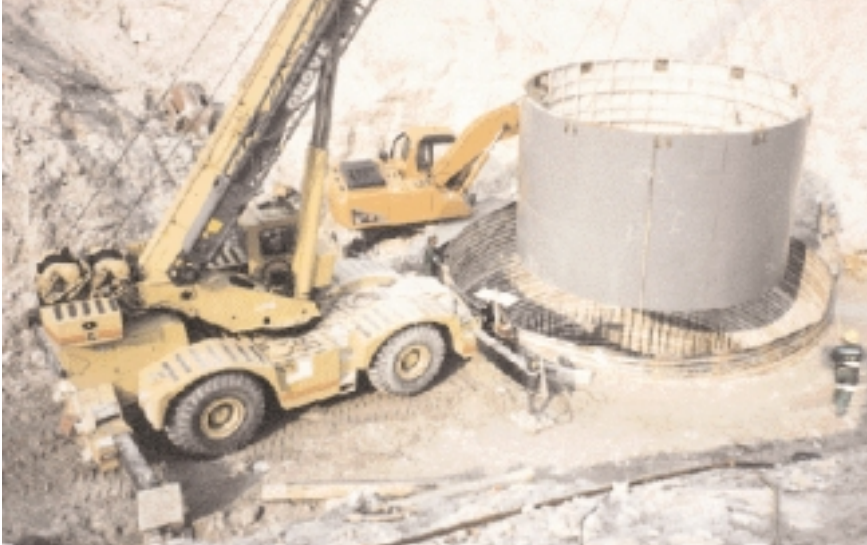
Bild links: Absenken der Betonierschalung
