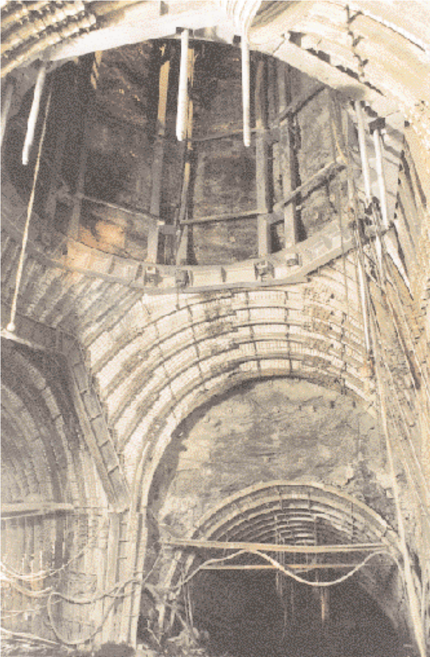
Bild 5: Der Bunkerunterraum ist ein komplexes Bauwerk
