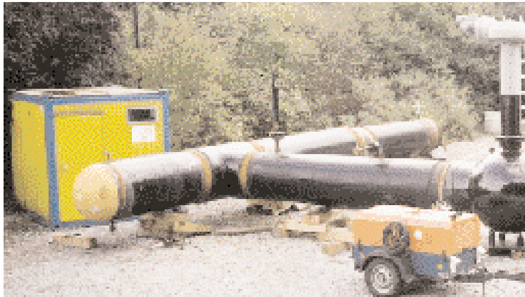
Bild 2: Vorgefertigte einzubauende Rohrleitungsteile DN 900 und DN 1000 im Druckprobekzustand
