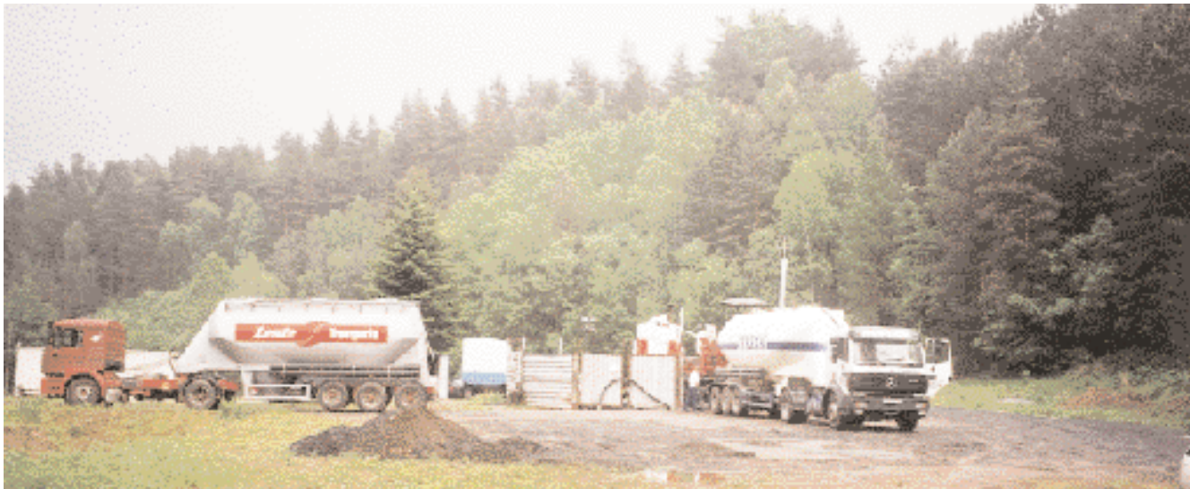
Abb. 2: Antransport des Dammbaustoffes zum Schachtkopf Springen I
