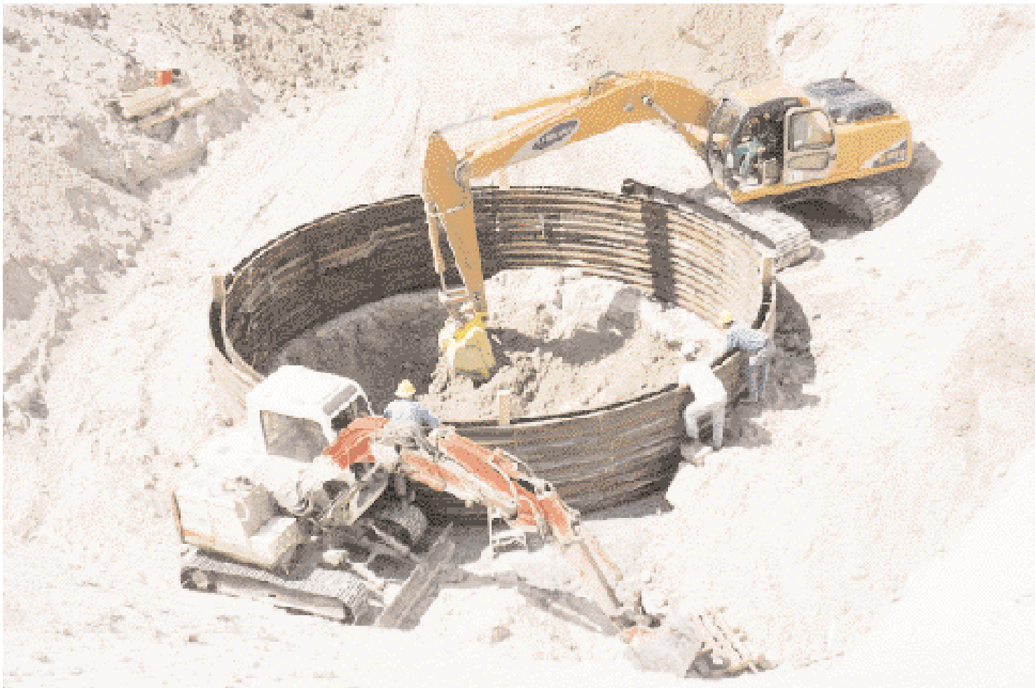
Einbau der Ringe am Schachtkragen – Aushub mit Tieflöffelbagger
