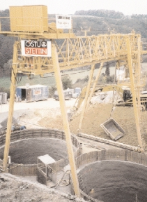
Bild 1: Teufanlage: Portalkran 12,5 to
