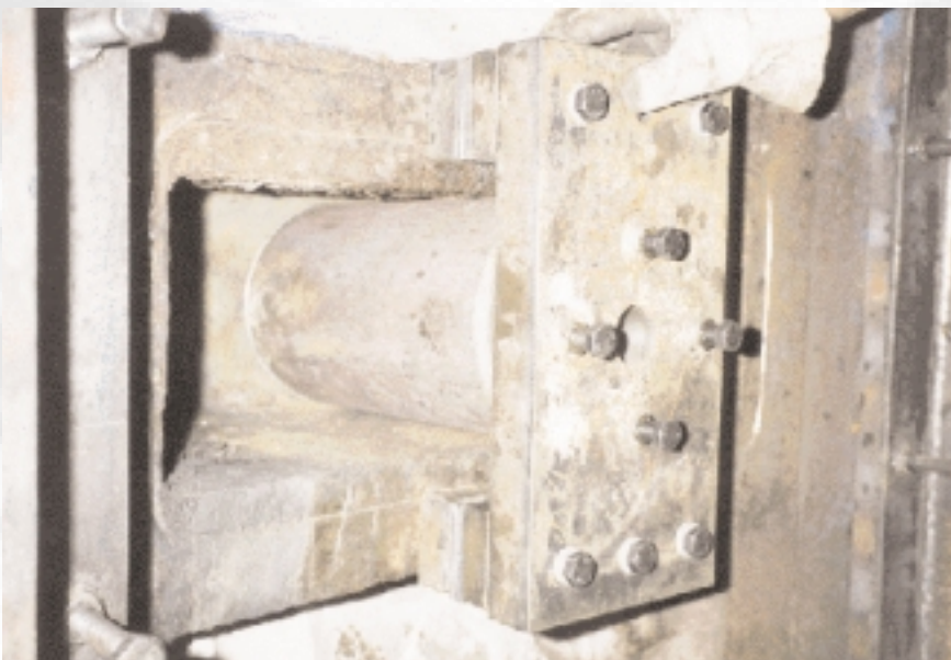
Abb. 1: Montierter Vorbautopf
