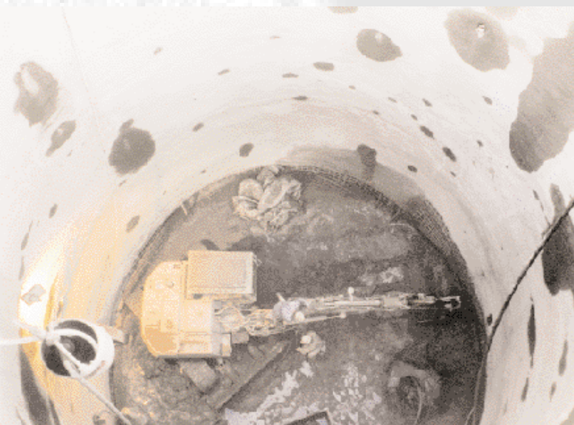
Bild 2: Schachtbagger: Liebherr R 308
