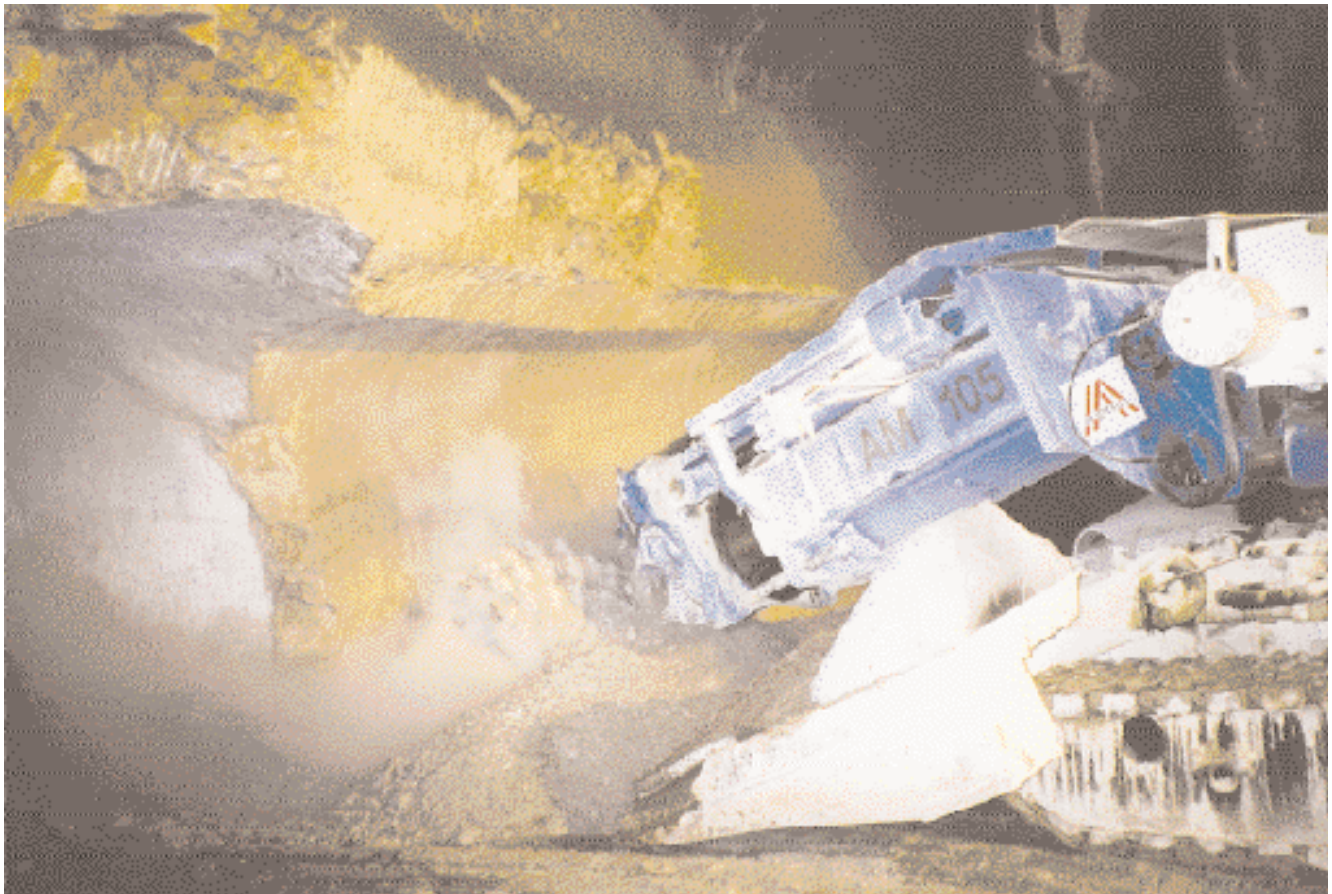
Testeinsatz im kompakten Kalkgestein mit ca. 200 MPA einaxialer Druckfestigkeit im Pozanotunnel in Süditalien
