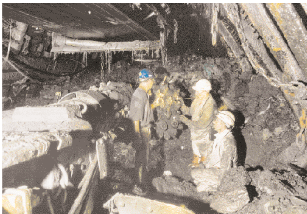
Die umgerüstete AM 75 paßt unter das Förderband
