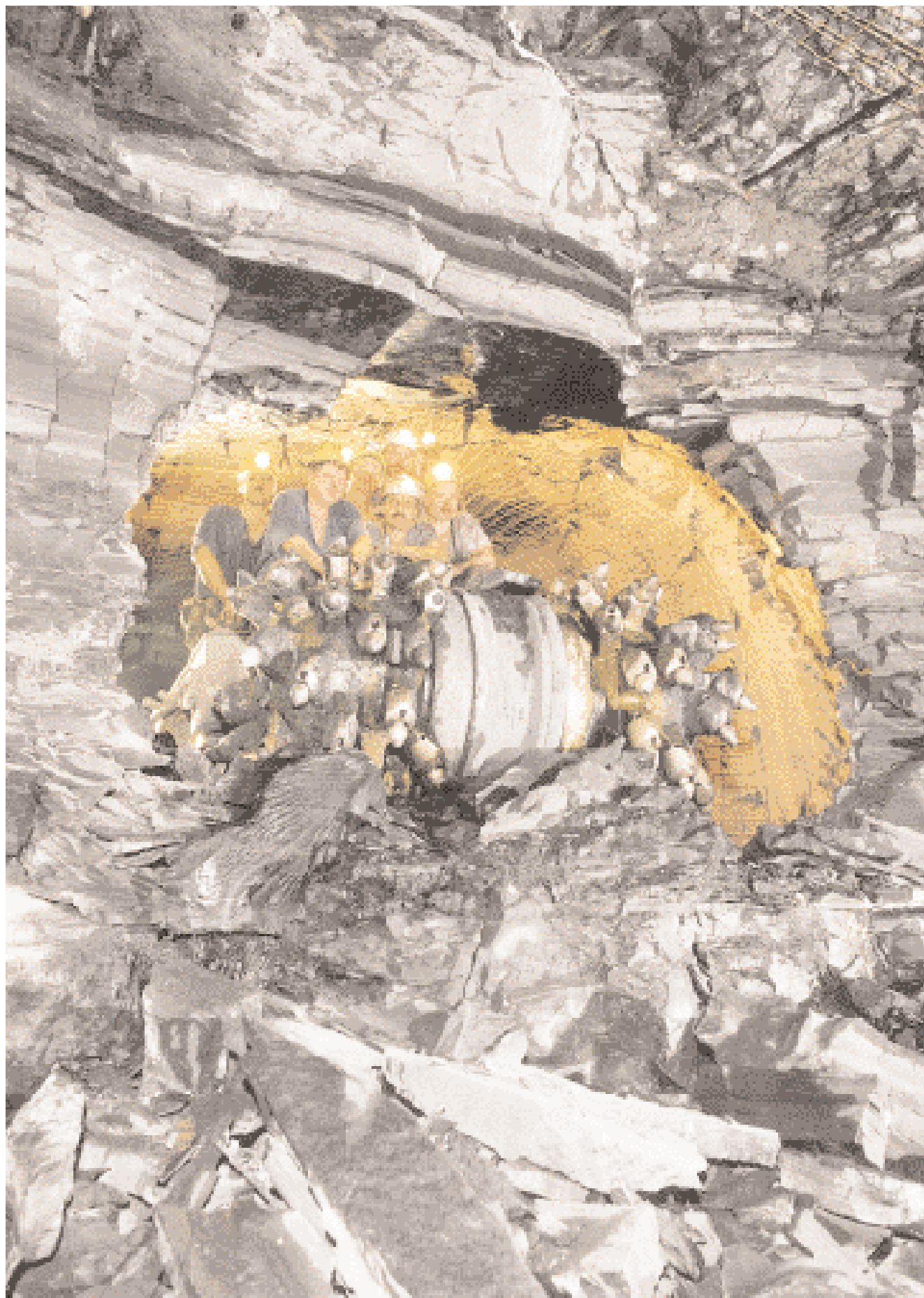
Durchschlag mit Teilschnittmaschine AM 85 auf dem Bergwerk Niederberg der Deutschen Steinkohle AG durch den Geschäftsbereich Bergbau der Thyssen Schachtbau GmbH
