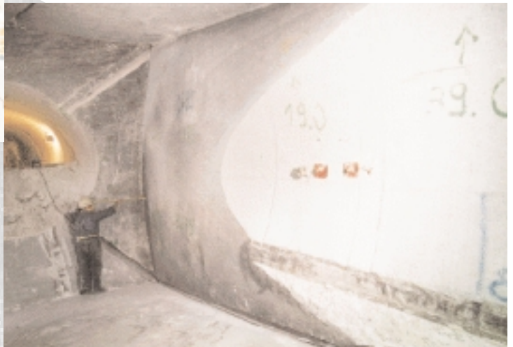
▶ Widerlager – ausgesägte Kontur des Pyramiden- stumpfes
