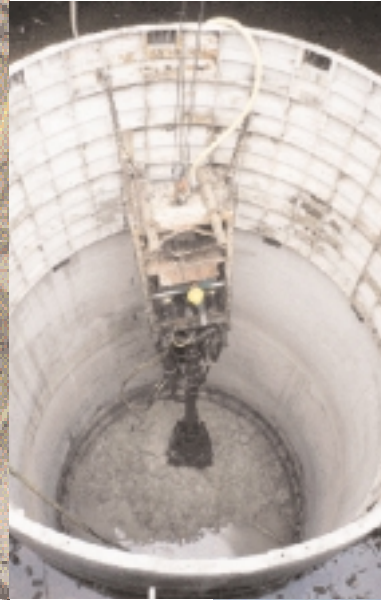
Bild links: Zeitweiser Einsatz eines Crydeman zur Vertiefung des Schacht- kragens
