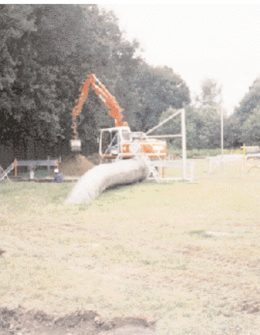
Bild 1: Station Elten, Beginn der Ausschachtungsarbeiten
