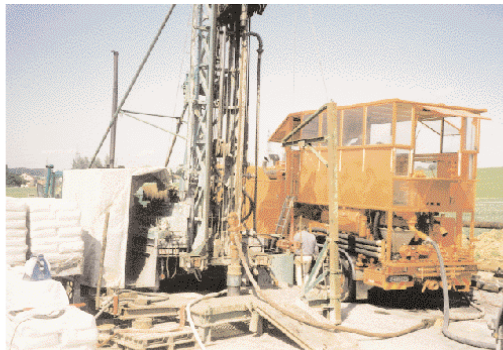
Verlustzementation bei einer Bohrteufe von ca. 155 m
