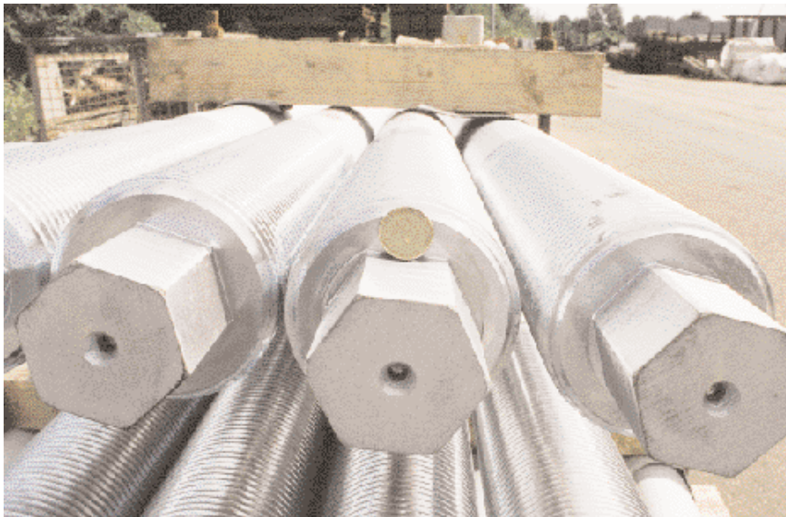
Bild 4: Die Tragstangen für den Bunkerboden liegen bereit
