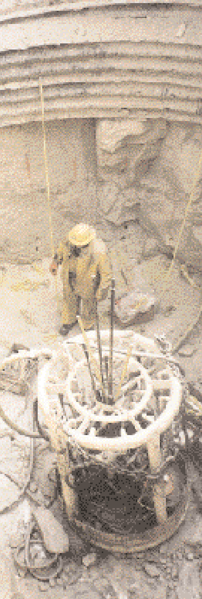
Bild links: Konventionelle Teuftechnik im Felsgestein
