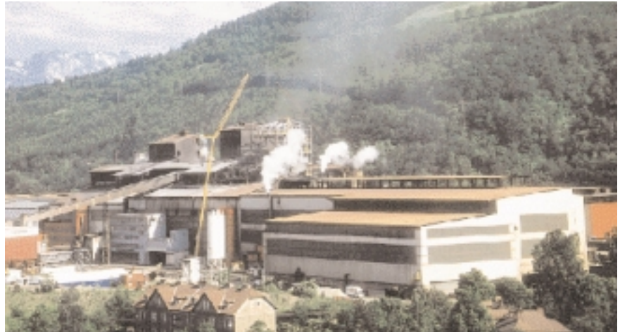
Ansicht Kompaktstahlwerk VOEST Alpine Donawitz/Leoben
