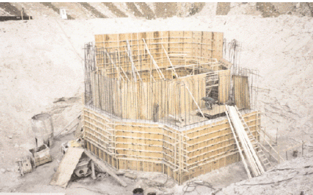
Verschalung des Schachtkragens
