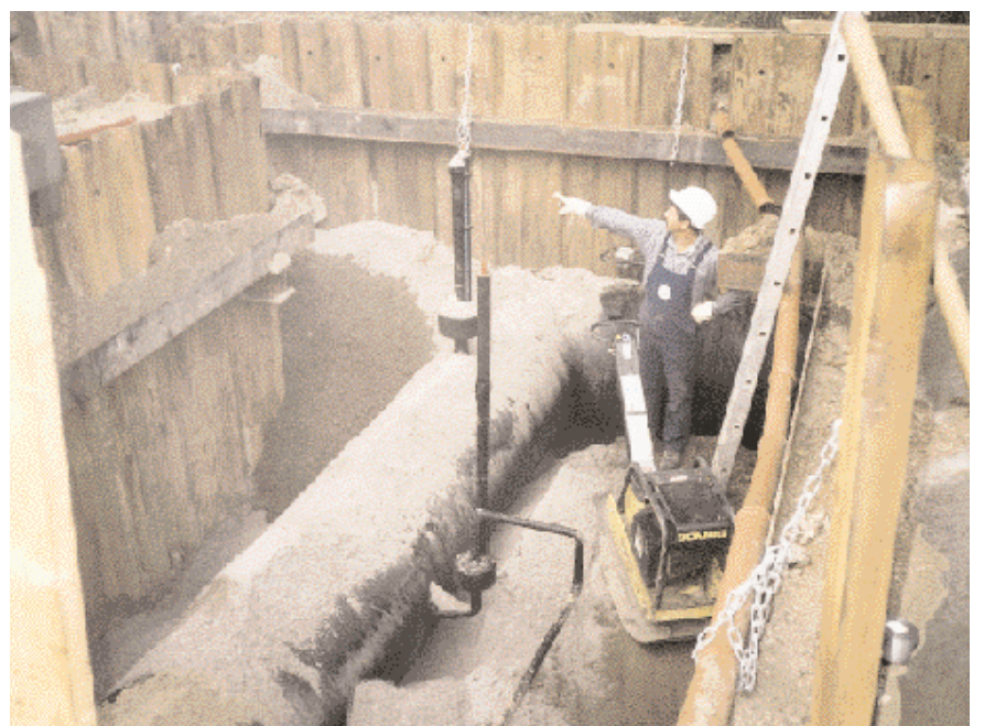
Bild 4 (rechts): Verfüllung und lagenweise Verdichtung der Baugrube mit steinfreiem Sand
