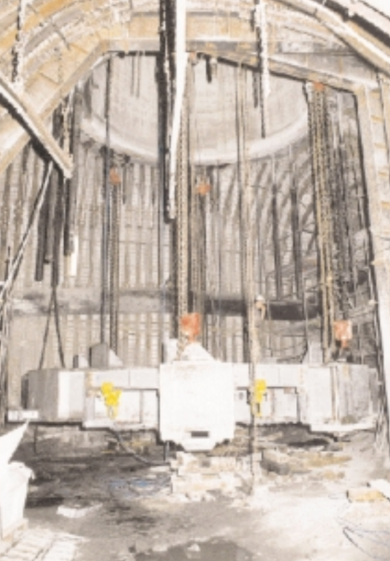
Bild 7: 60 t fertig montierter Bunkerboden heben von der Sohle ab...
