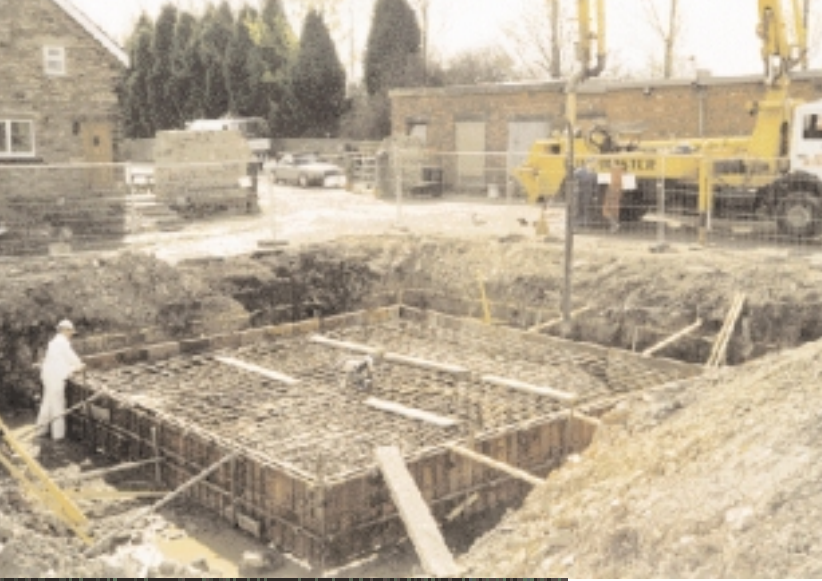
Überwachung und Behandlung stillgelegter Schachtanlagen
