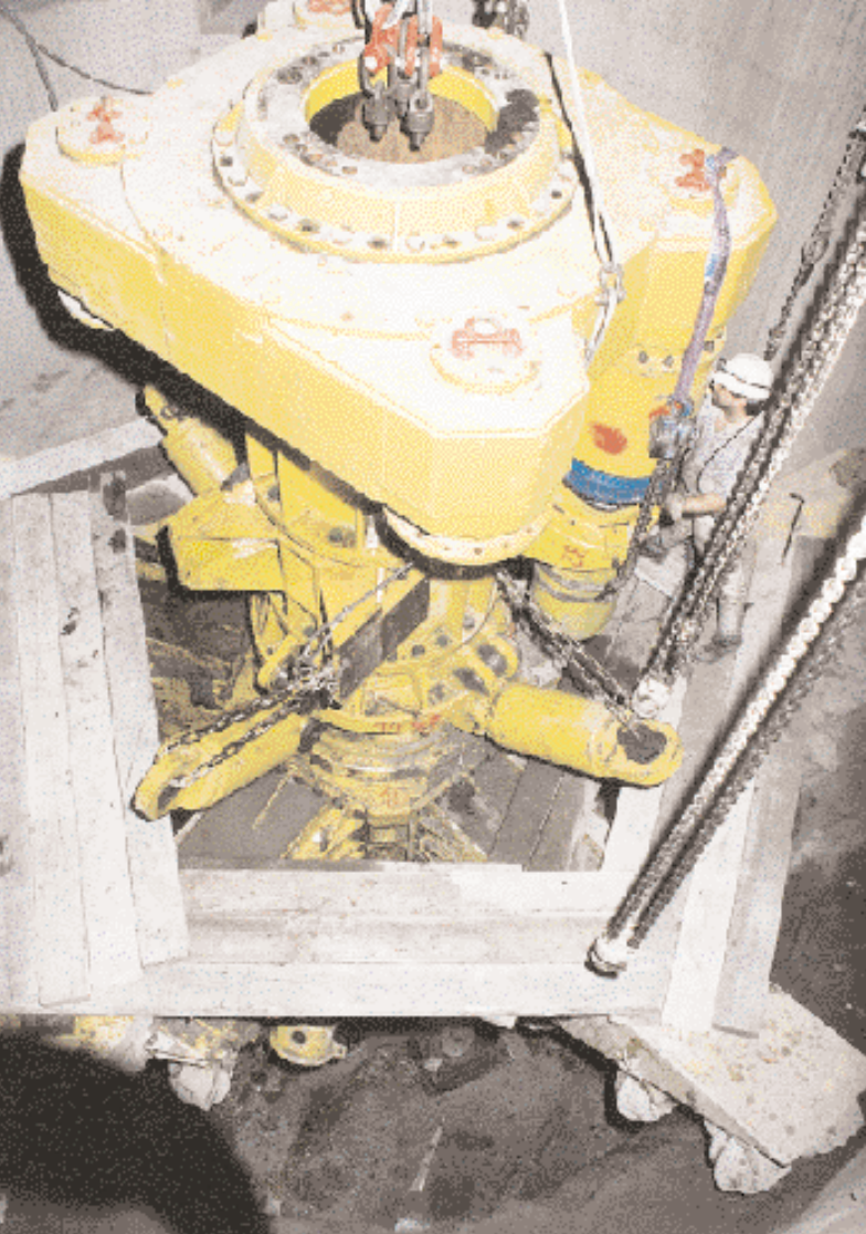
Bild 2: Die Innenkelly der SB VI wird über dem Bohrkopf montiert
