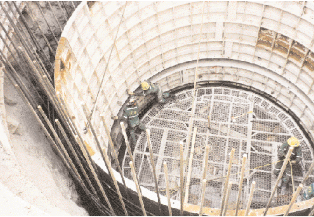
Einbau der Betonierschalung unterhalb der Stahlringe
