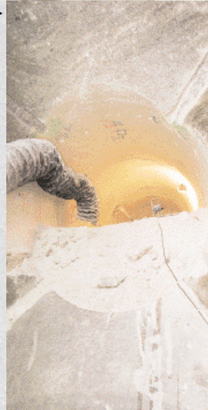
▶ Widerlager – ausgesägte Kontur des Pyramiden- stumpfes
