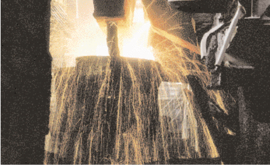
Die Bauarbeiten wurden bei vollem Heißbetrieb durchgeführt
