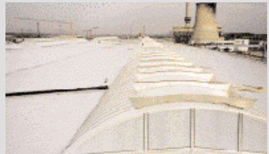
Sanierete Dachflächen mit Wärmedämmung und Oberlichtern
