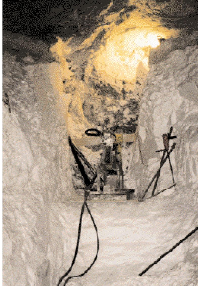
Die Extensometerbohrungen werden durch den Einsatz eines druckluftgetriebenen Bohrgerätes mit Zweigang-Schaltgetriebe ausgeführt. Der Motor ist auf einen Grundrahmen mit Lafette und Zahnstange so montiert, daß er in Richtung der Bohrlochachse verfahren werden kann.
