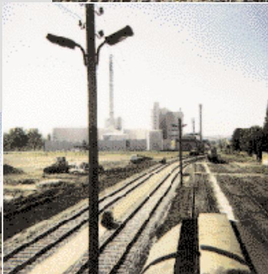
2.500 m Gleis und 19 Weichen zu sanieren. Das bedeutet, daß die Bahnanlage zurückgebaut, der Untergrund komplett ausgebaut und erneuert sowie eine Linienentwässerung mit einer Länge von 1.400 m hergestellt werden müssen. Alle Weichen und Gleise werden nach der Aufarbeitung
