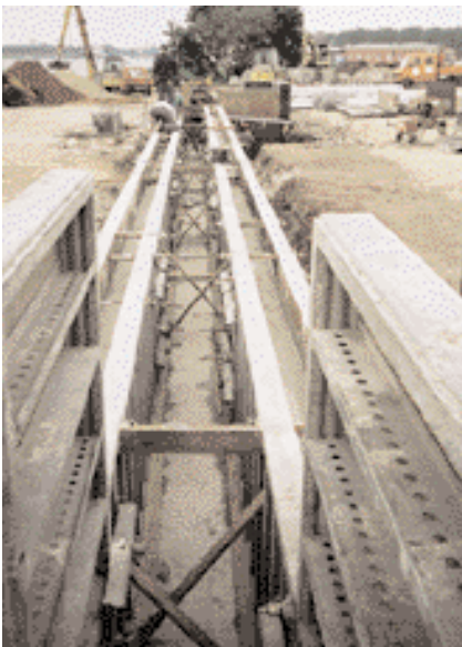
Schalung der Entwässerungsrinnen
