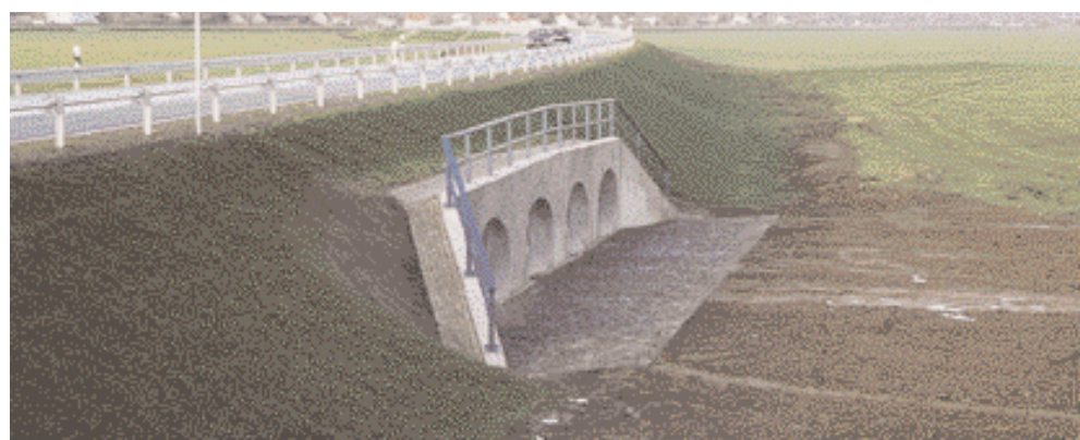
Flutdurchlass Nr. 4, DN 1800 nach der Gesamtfertigstellung
