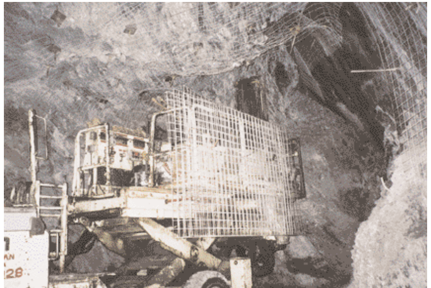
Bohrjumbo beim Setzen von 4,8 m-Zementankern
