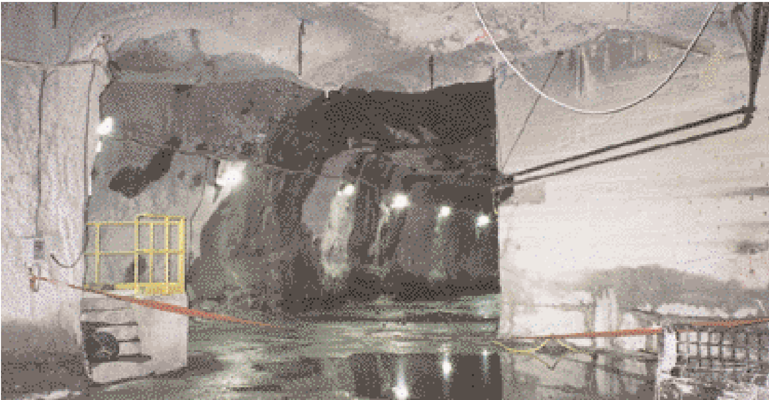
Förderstrecke auf der 640 m-Sohle neben verfüllter Strecke
