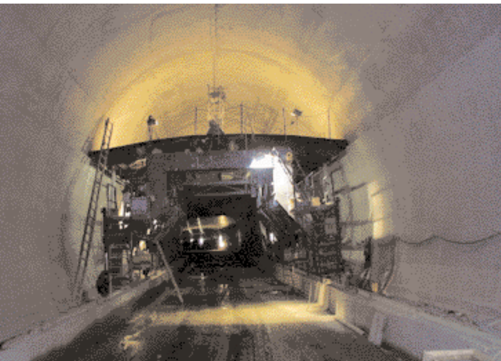
Herstellung der Zwischendecken unter Benutzung eines speziellen Transportwagens
