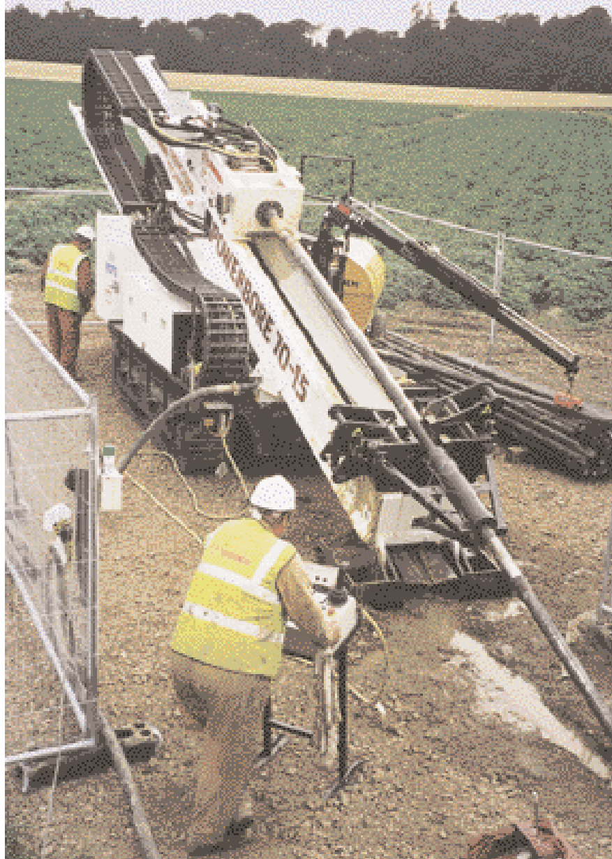
Die APPS Powerbore 70/15 während der Erweiterungsbohrung
