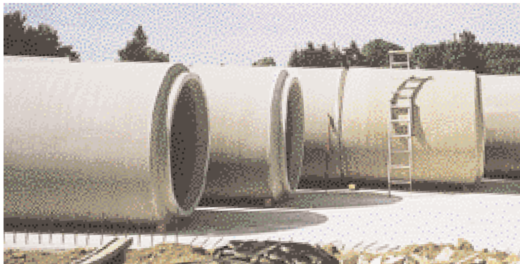
Montage der Stahlbetonrohre DN 1800 für den Flutdurchlass 4 (Gewicht eines Rohres: 10 t)
