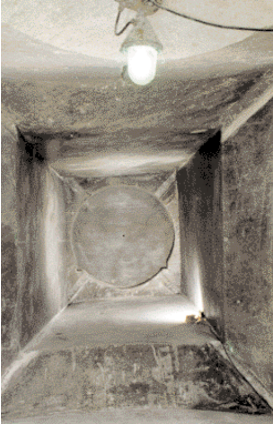
Gesamtansicht der fertigen Widerlager- und Dichtungskonturen des Streckenschlusses EU-1
