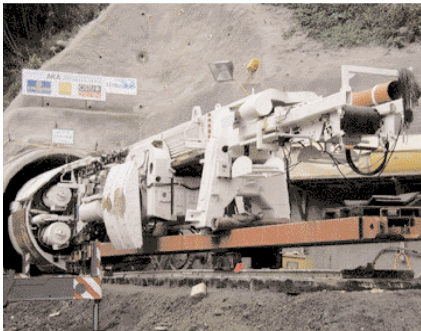
TBM vor dem Einschieben in den Stollen
