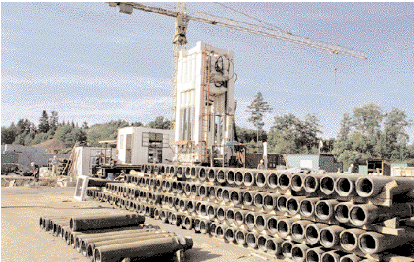
Erweiterungsbohrung, Raisebohranlage Wirth HG 330 SP
