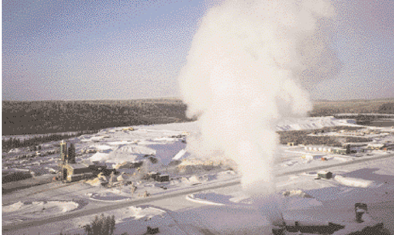
Tagesanlage im Winter mit Kondensationsfahne des Ausziehschachtes
