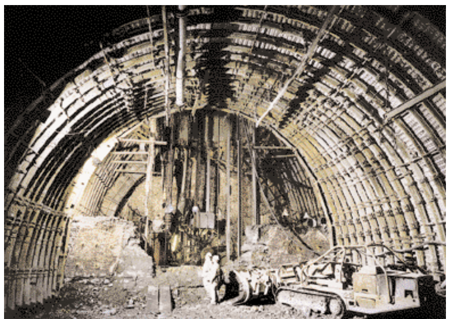
Bild links: Schachtquerschnitt mit Rampe, umgesetzte Schießbühne
