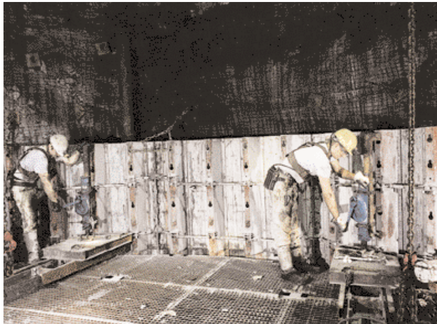
Umsetzen der Schalung
