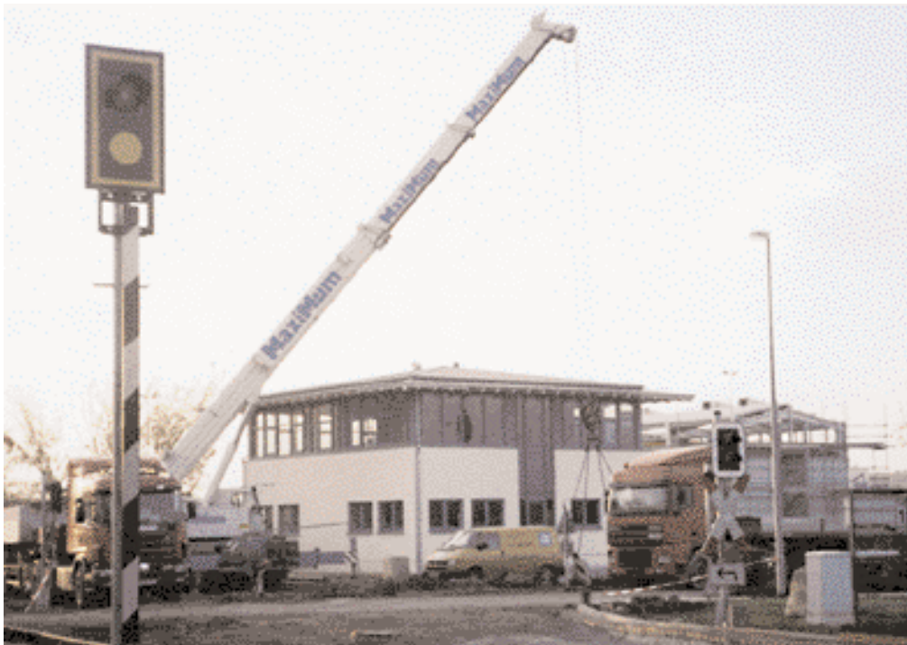
Straßenzufahrt zum Hafengelände mit neuen Verwaltungsgebäuden
