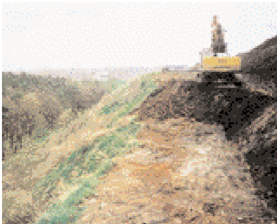
Baufortschritt im Bereich der Nordböschung. Deutlich erkennbar die steile Böschung mit einer Neigung vor der Oberflächenprofilierung bis 1:1
