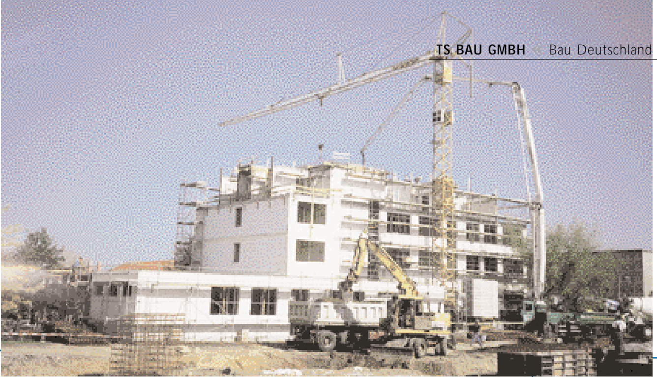
Betonage der Decke des 3. Obergeschosses des Schulungsgebäudes
