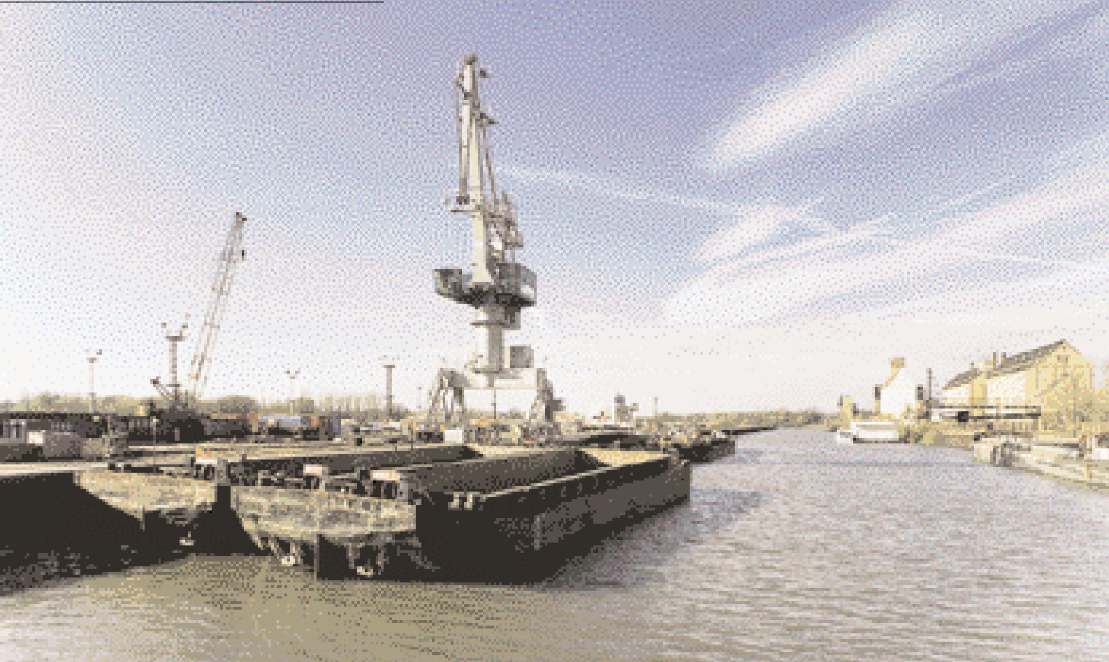
Der stolze Hafenkran: „Wahrzeichen“ des Hafens von Halle
