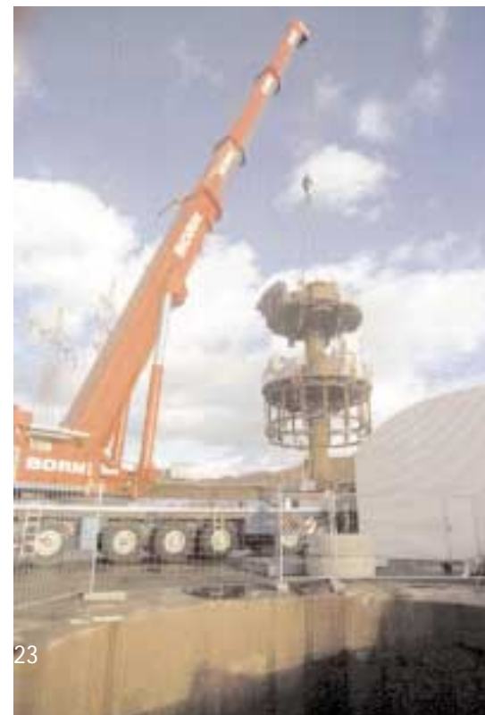
Vormontage der Arbeitsbühne
