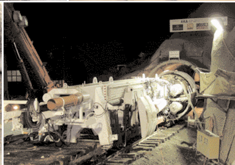
TBM-Montgearbeiten im Schichtbetrieb
