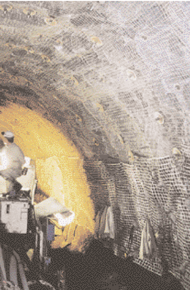
Ankerung mit Maschendrahtverzug im Bereich der Teilschnittmaschine
