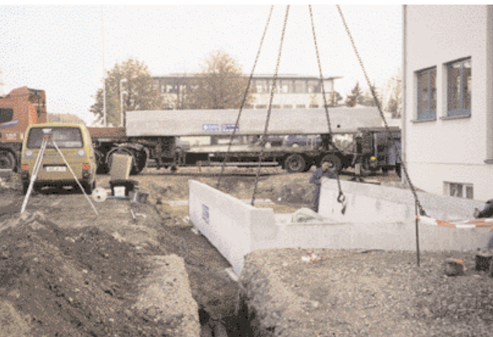
Errichtung der Straßenfahrzeugwaage
