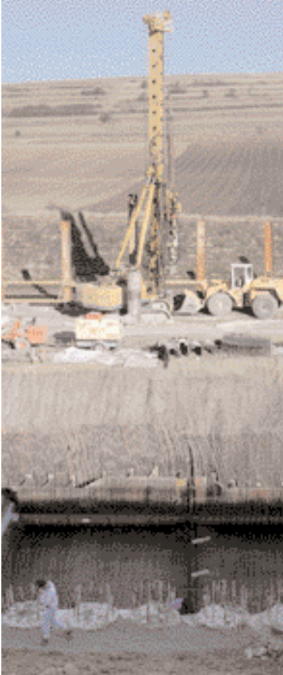
Pfahldrehbohrgerät BG 30
