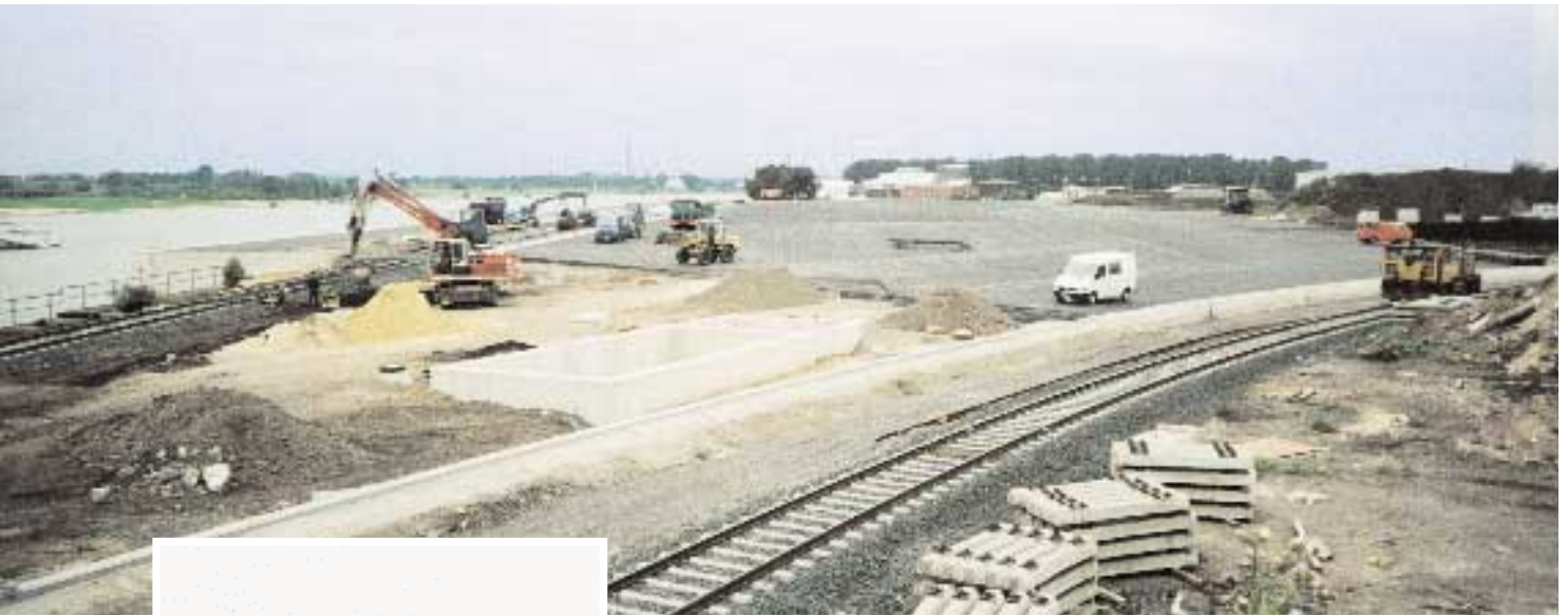
Das Areal wird asphaltiert
