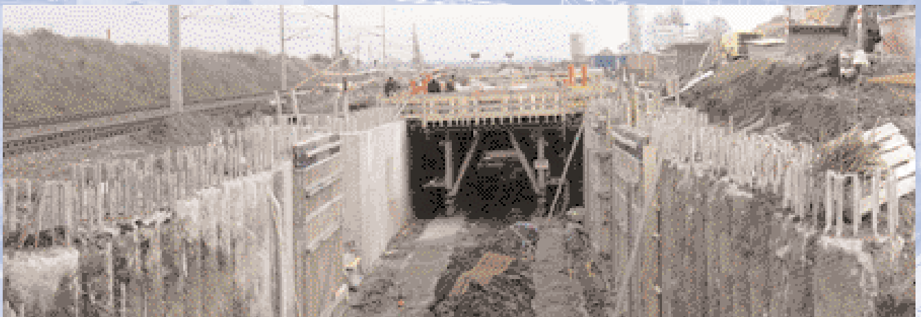
Östu-Stettin Schalwagen im Einsatz
