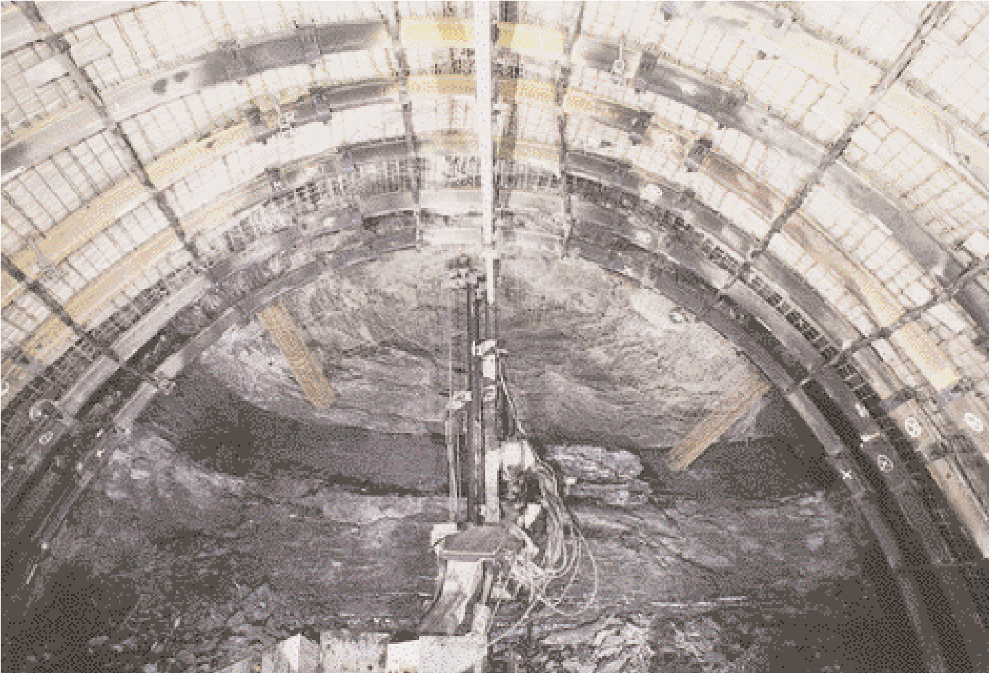
Ankerung der Firste mit Kompaktbohrwagen – gut zu erkennen sind die beiden Flözbänder mit Bergemittel (Referenzstrecke)
