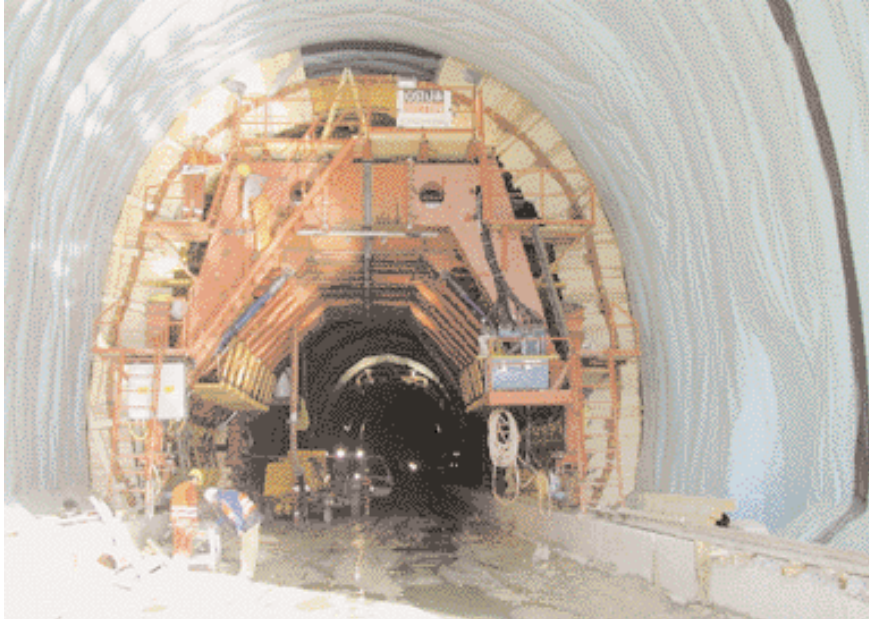
Verringerte Einschaltzeit durch Gewölbeshalungen, die ankerfreies Arbeiten ermöglichen
