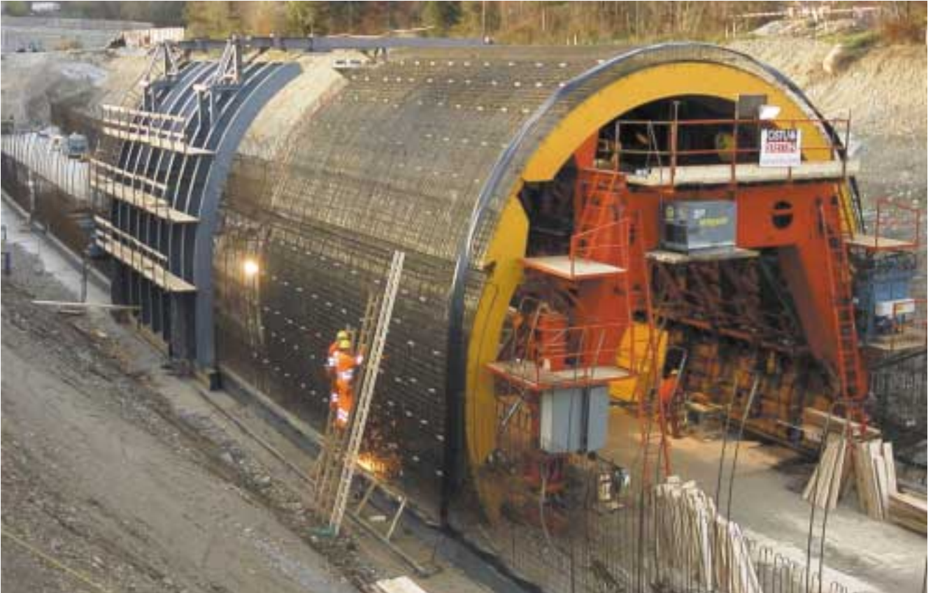
Gewölbe- und Konterschaltung für die offene Bauweise
