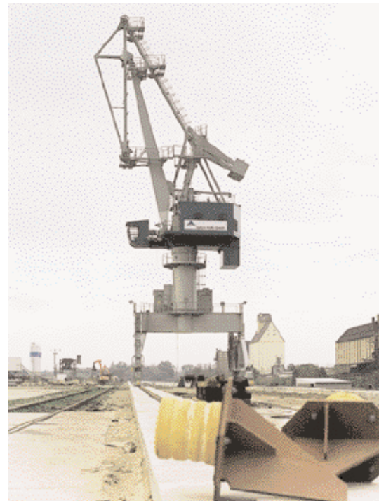
Neugestaltung der Gleistrassen
