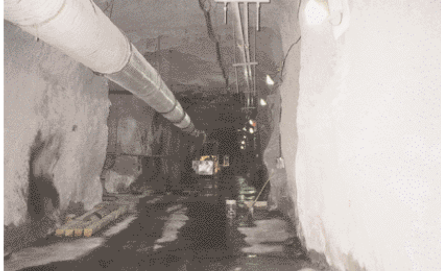
Fertigstellung der Raisebohrkammer in Spritzbeton, betonierte Sohle
