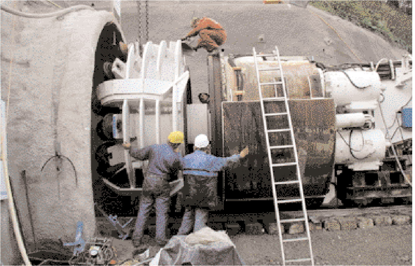
Anflanschen des Bohrkopfes der Tunnelbohrmaschine am Stollenmundloch
