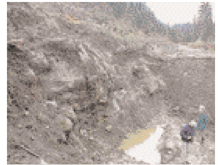
Ansetzen des oberen westlichen Portals (Frühjahr 2001)
