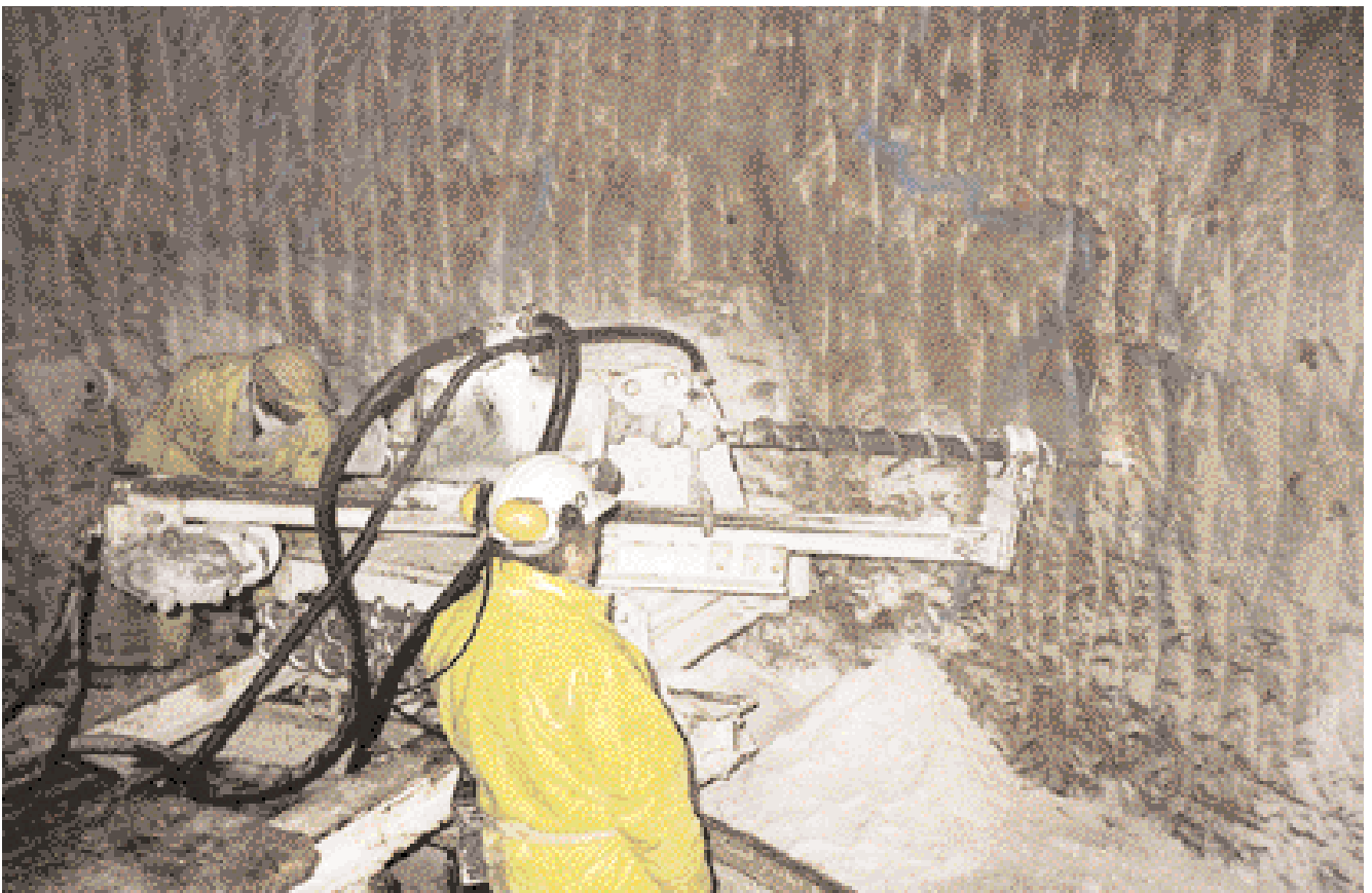
Erstellung annähernd horizontaler Abdichtungsbohrungen
