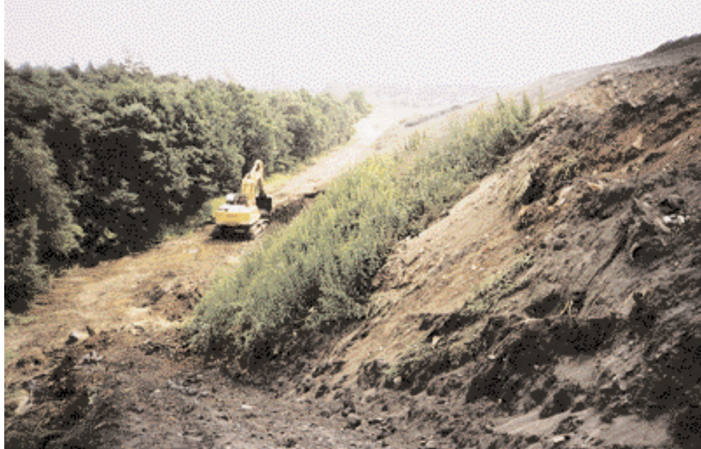
Baufortschritt im Bereich der Nordböschung. Deutlich erkennbar die steile Böschung mit einer Neigung vor der Oberflächenprofilierung bis 1:1
