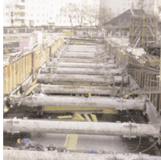
Herstellung des Deckentragwerks in der ausgesteiften Baugrube
