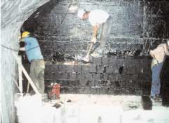
Abschlussbauwerk Hope: Einbau der Innendichtung aus Sandasphalt
